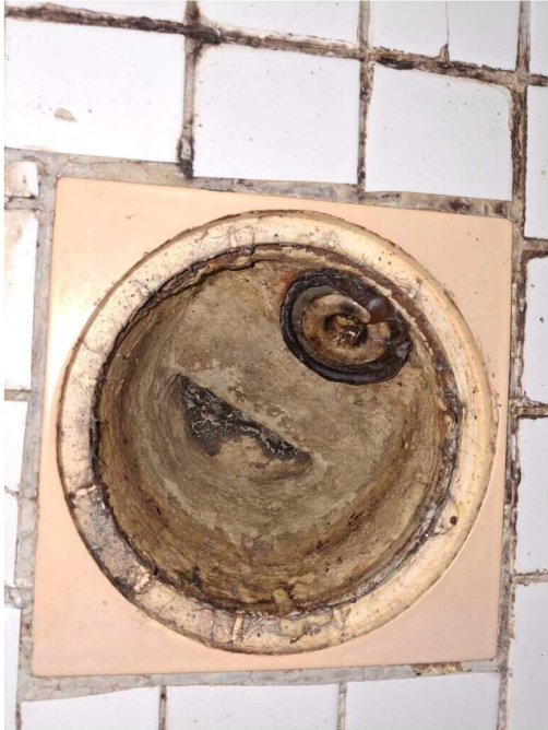
Kuva 19 Kylpyhuoneen lattiakaivo on alkuperäinen ja valurautainen.
