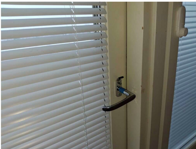
Kuva 2 Parvekkeen ovi on uusittu.
