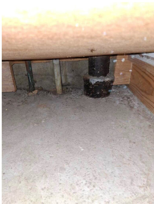
Kuva 13 Allaskaapin sokkelitilassa ei havaittu vuotojälkiä, viemärointi on valurautaa.
