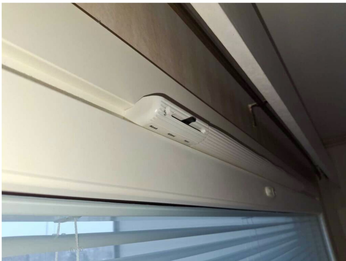
Kuva 4 Ikkunat on uusittu vuonna 2018, ikkunoihin on asennettu korvausilma säleiköt.
