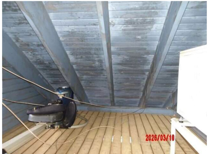
Kuva 19 Ilmanvaihto puutteellista
