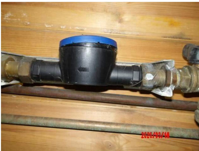
Kuva 12 Vesimittari jäätynyt rikki
