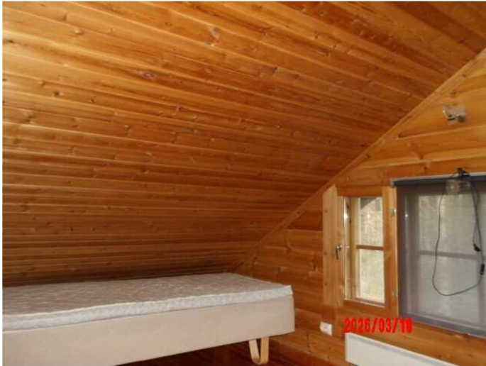
Kuva 16 Yläkerrassa vinot sisäkatot
