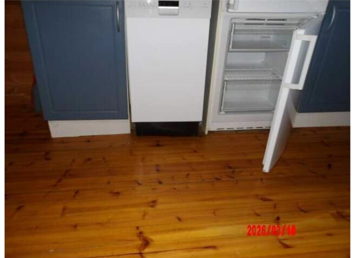
Kuva 3 Keittiössä ei pintapuolisesti ole havaittavissa merkkejä kosteusvaurioista
