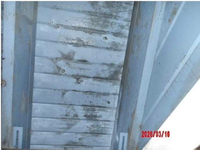
Kuva 18 Yläkerran terassilla tummia pilkkuja laudoissa
