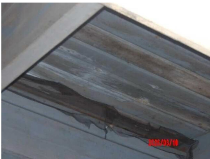
Kuva 26 Katon tuuletusrako seinän yläpuolella
