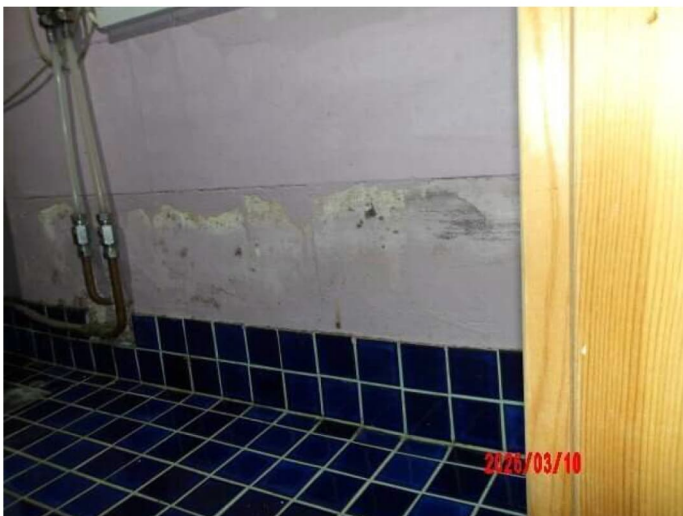
Kuva 4 Wc:n tiiliseinän alapäässä kosteutta
