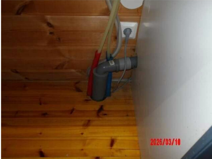
Kuva 2 Keittiössä ei pintapuolisesti ole havaittavissa merkkejä kosteusvaurioista
