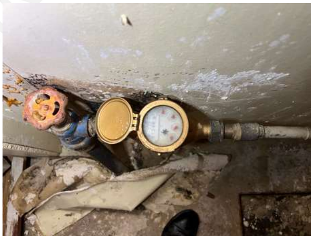
Kuva 9a. Vesimittari.
