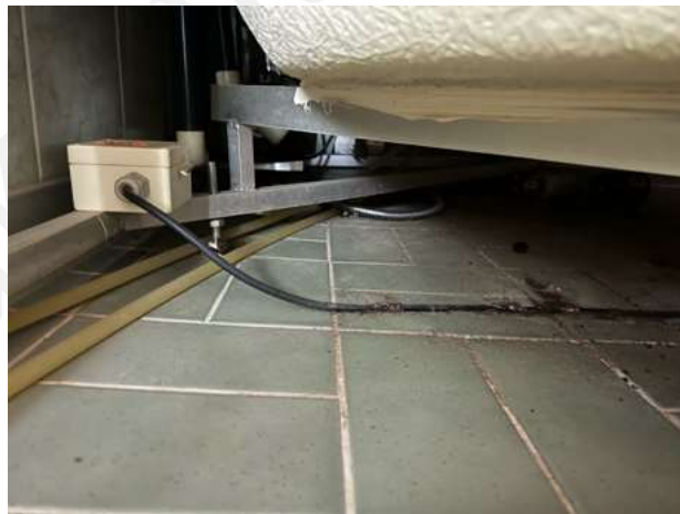
Kuva 5.1d. Ammeen alaosa. Johdon kunto varmentettava.
