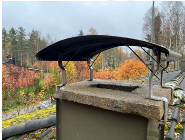
Kuva 12a. Sadehattu on asennettu. Hormin yläosassa ei havaittu rapautumaa.
