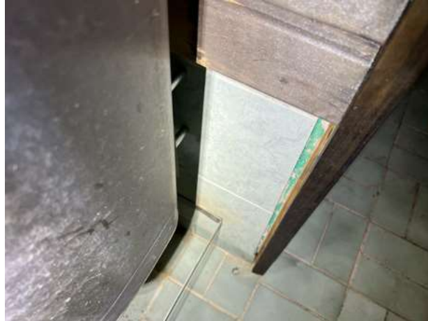
Kuva 5.2b. Vedeneristysmassa näkyvissä.
