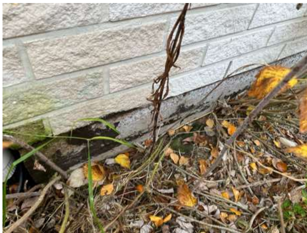
Kuva 1b. Vihertymää tiilien alaosassa. Sorastus puuttuu, sokkelissa pinnoitteen rapautumaa.
