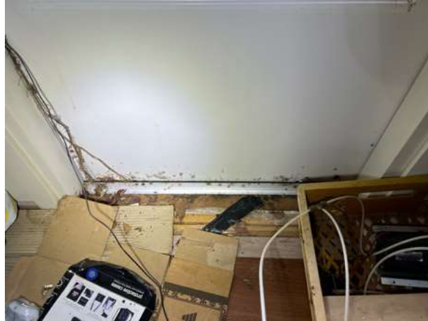
Kuva 3c. Köynnöskasvi, homepilkkuja oven alaosassa.
