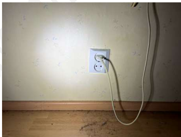
Kuva 11c. Maadoittamaton pistorasia.
