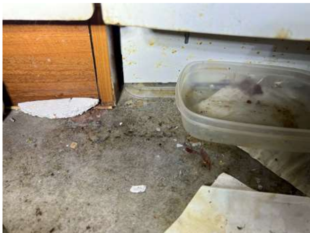
Kuva 5.5d. Valumakaukalo on asennettu.
