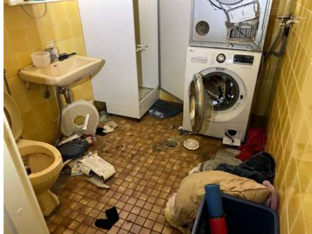
Kuva 5.4a. Wc / kodinhoituhuone. Pesukoneella on kiinteät liitännät.
