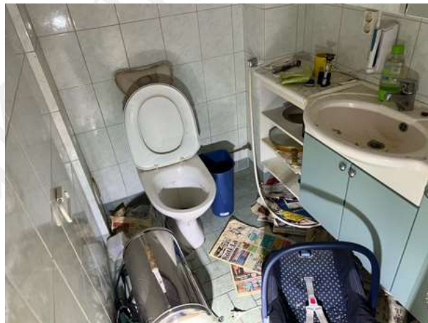
Kuva 5.3a. Roiskevesialue on suojattu. Arviolta tila on päivitetty 2000-luvun tienoilla.
