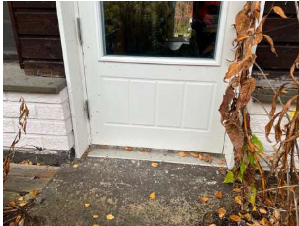
Kuva 3d. Astinpellitys on asennettu. Ovi on arviolta uusittu jossain vaiheessa.
