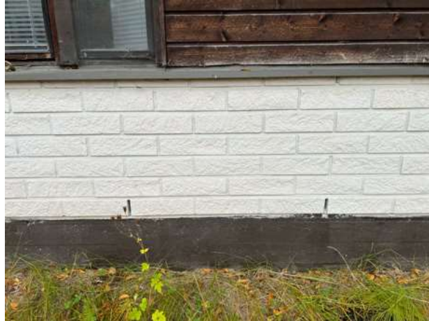
Kuva 2c. Tiilimuurauksessa tuuletusaukot.
