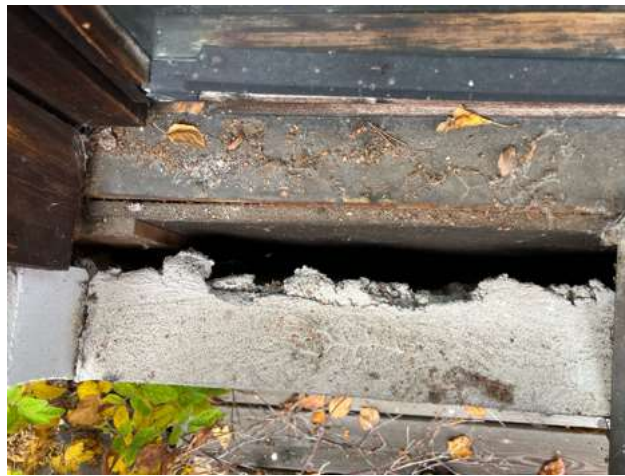
Kuva 2d. Ilmarako muurauksen taustalla. Tähystetty irtonaisen pellin kohdalta.
