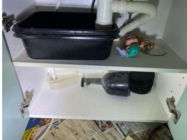
Kuva 5.3b. Allaskaapissa ei havaittu vuotojälkiä.
