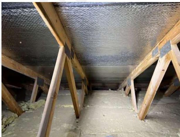
Kuva 4e. Räystäsrakenteissa on tuuletusaukko- Aluskate on asennettu.
