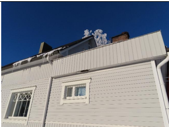
Savupiippujen päällä ei ole piipunhattuja
