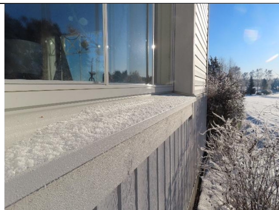
Ikkunat ja ikkunapellitykset ovat kunnossa
