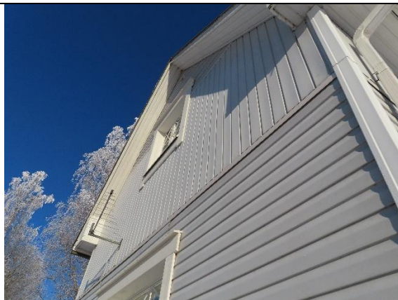
Julkisivut ovat pääosin kunnossa
