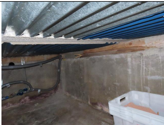
Kellari keittiön lattian alustassa
