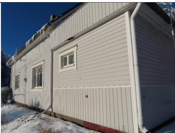
Julkisivut ovat pääosin kunnossa
