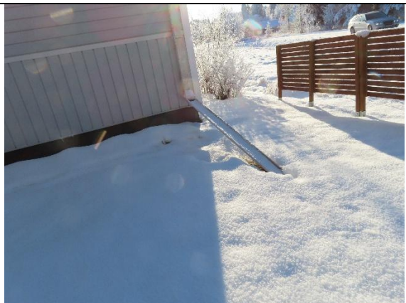
Rännivedet ohjattu etäämmälle perustusten viereltä kourujen avulla
