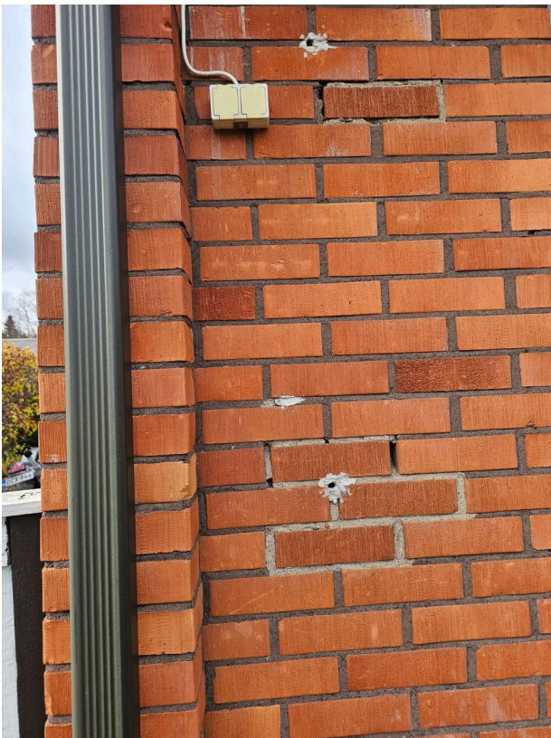
Verhouksen saumoja on uusittu.
