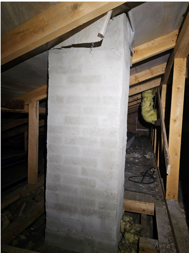
Piippu on pinnoitettu yläpohjassa
