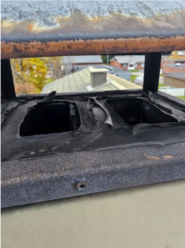
Piipun yläosan pelti on epätiivis.
