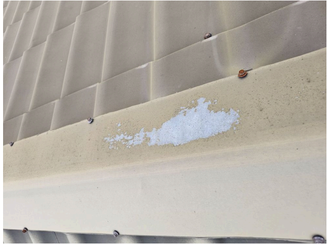
Pinnoite on irronnut. Ruuvit ruosteessa, tiivisteet hapertuneet.
