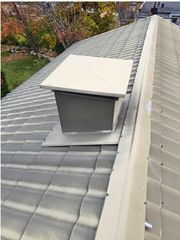
Piipun yläosan pelti on epätiivis.
