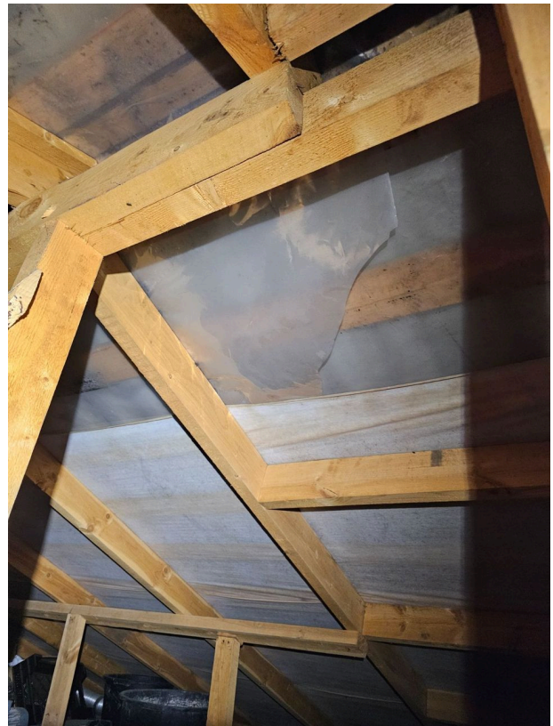
Osittain aluskatteena käytetty kirkasta ns. rakennusmuovia
