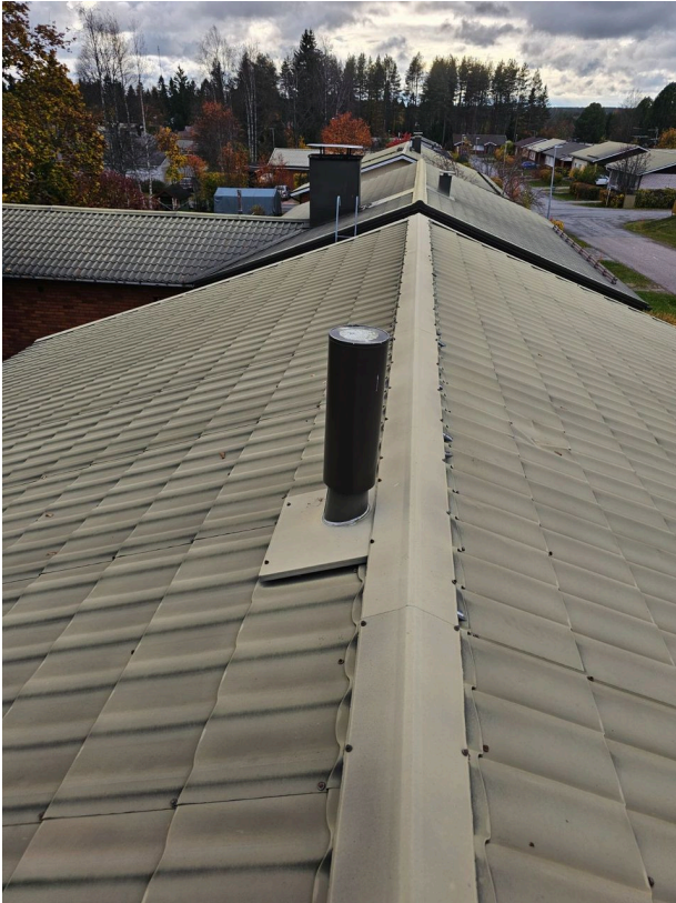
Viemärin tuuletusputki
