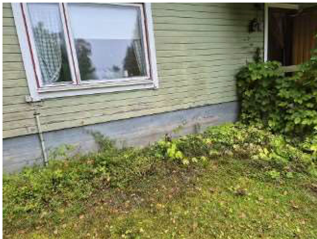
Sokkelista irronnut pinnoitetta
