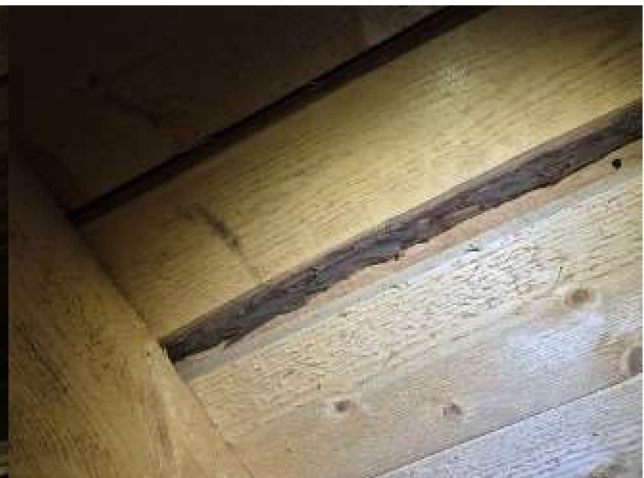
Vesikatteen alla pahvinen aluskate ja laudoitus
