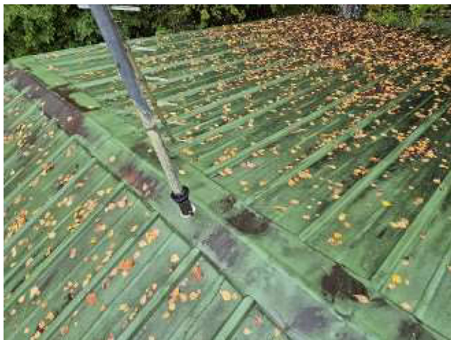
Antenniputken läpivienti vuotaa
