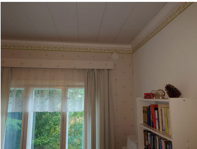
MH 2 siipi, ilmavaihto
