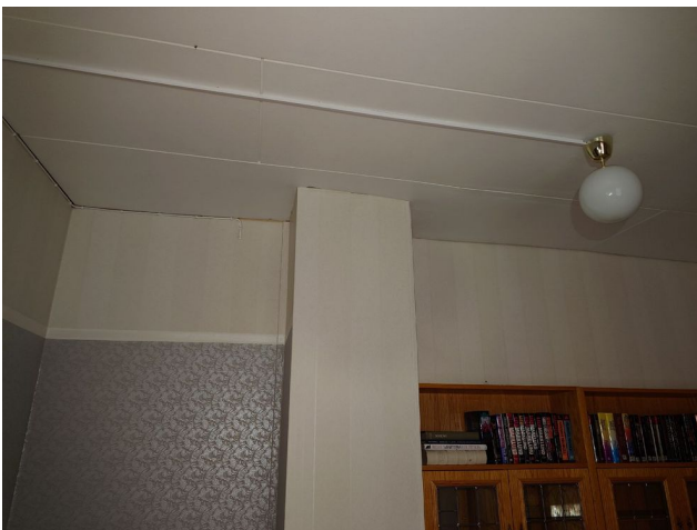
MH 2Krs. Ilmanvaihdon koteloointi
