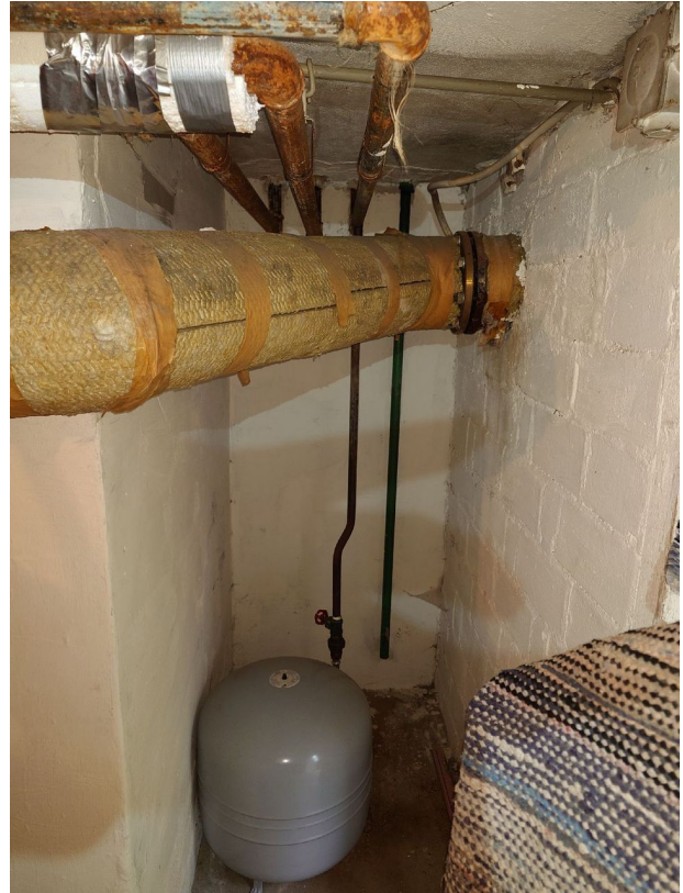
Hormin läpivienti seinästä
