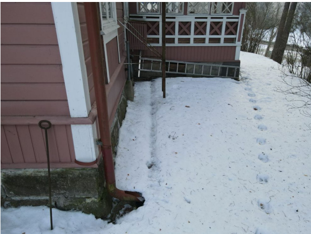
Kuva 50. Syöksy putki ja kaivo
