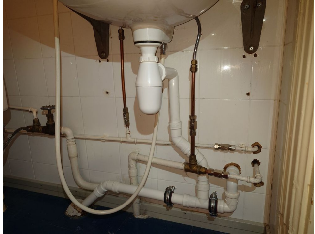
Hajulukko ja putkituksia keittiön puolelle
