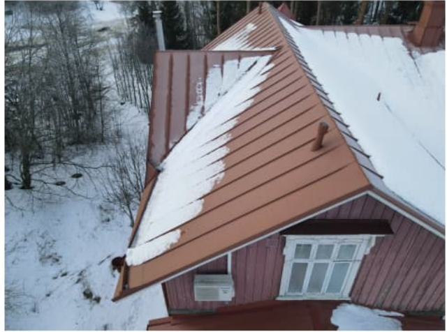
Kuva 24. Luultavasti yläpohjan tuuletus läpivienti
