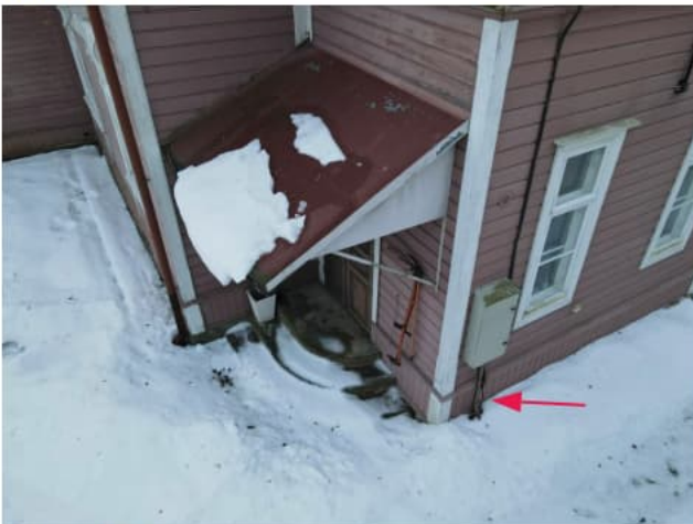
Kuva 46. Suojaamaton kaapeli
