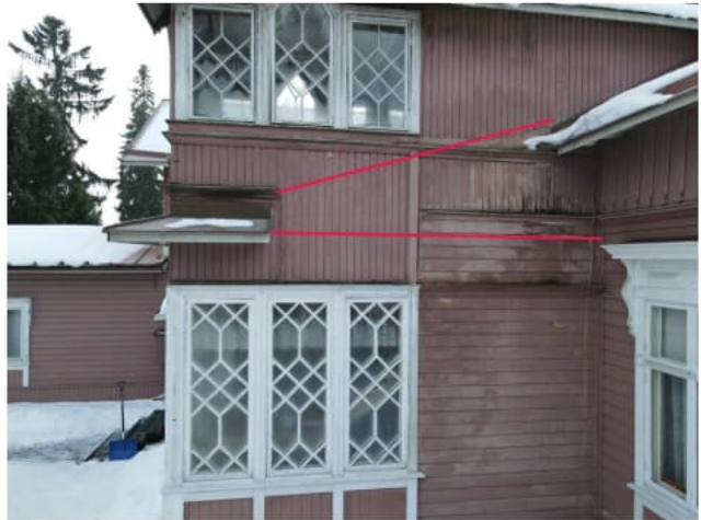
Kuva 45. Uloke kallistus purettu
