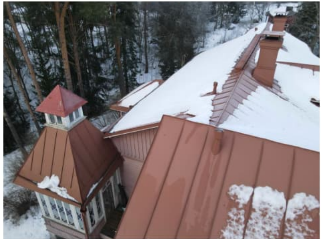
Kuva 26. Luultavasti yläpohjan tuuletus läpivienti
