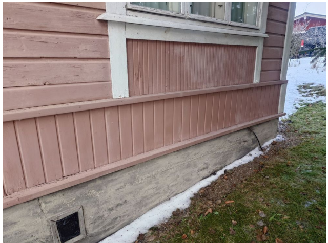
Kuva 63. Suojaamaton kaapeli
