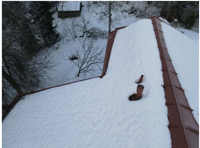
Kuva 34. Viemärintuuletuksen ja luultavasti yläpohjan tuuletus läpivienti
