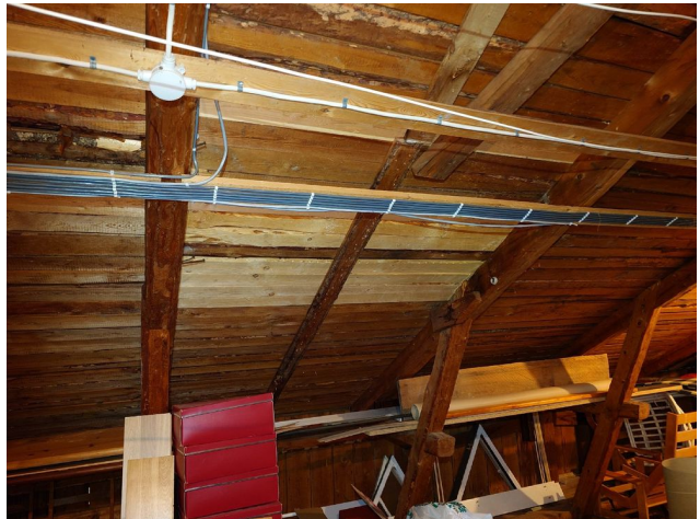
Kuva 18. Laudoituksia korjattu sieltä täältä
