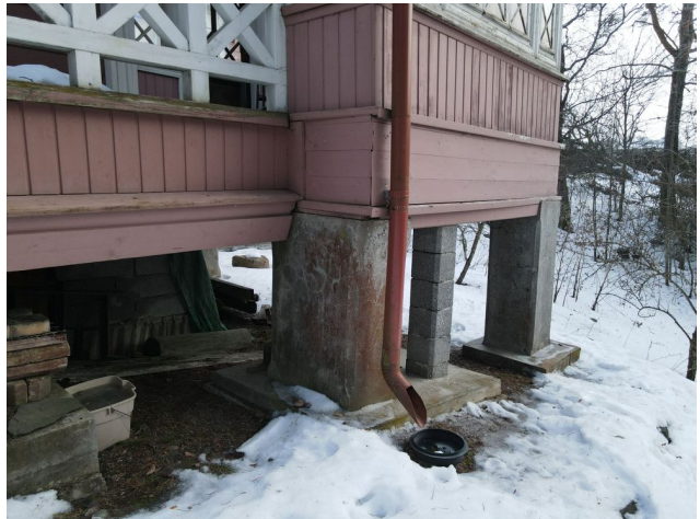
Kuva 53. Syöksy putki ja kaivo
