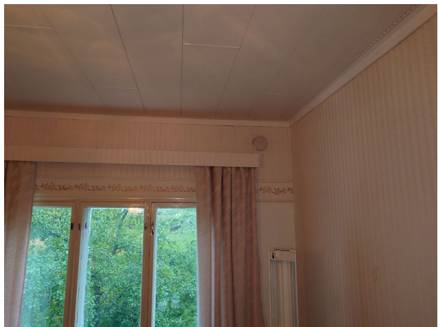
MH 3 siipi, ilmanvaihto
