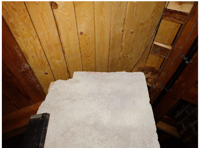
Kuva 16. Toinen hormi poistettu käytöstä
