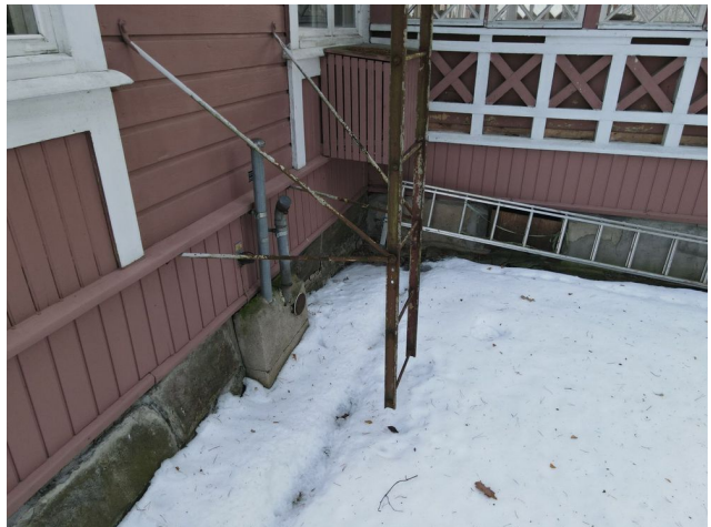
Kuva 51. Talotikkaat ja öljysäiliön täyttö
