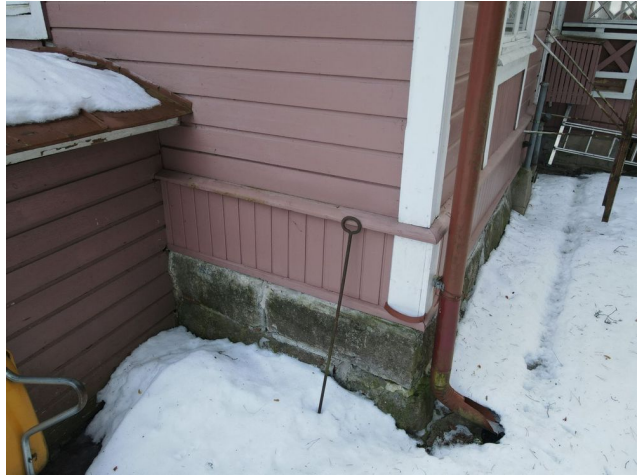
Kuva 49. Syöksy putki ja kaivo
