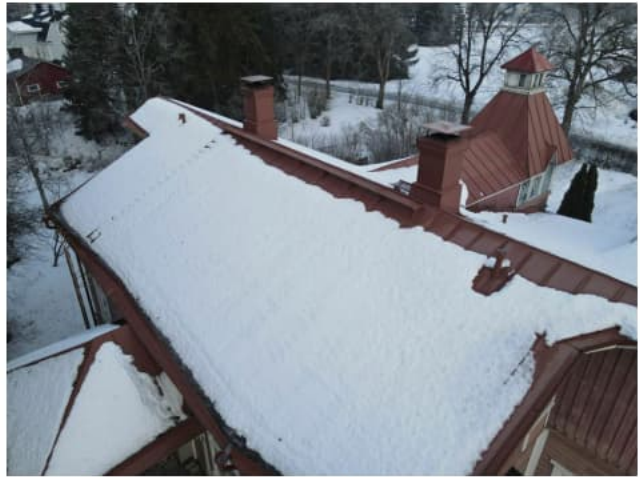
Kuva 28. Luultavasti yläpohjan tuuletus läpivienti
