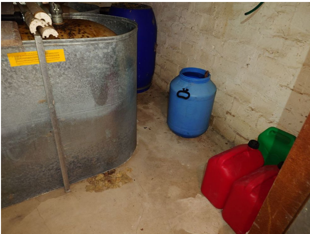
Ei merkkejä öljy vuodoista
