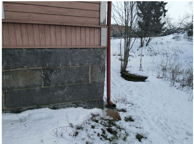
Kuva 57. Syöksy putki ja kaivo
