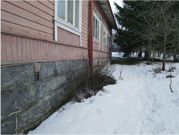
Kuva 60. Syöksy putki ja kaivo
