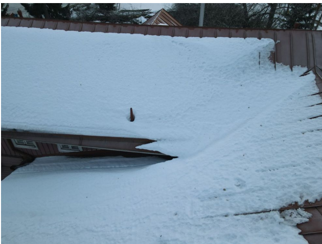
Kuva 39. Viemärintuuletuksen läpivienti
