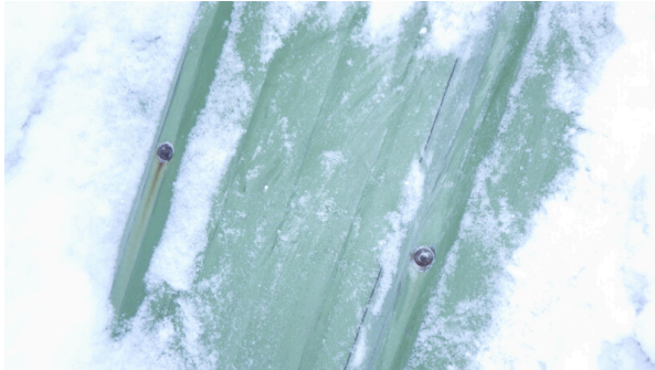
15. Vesikate on kiinnitetty nauloilla
