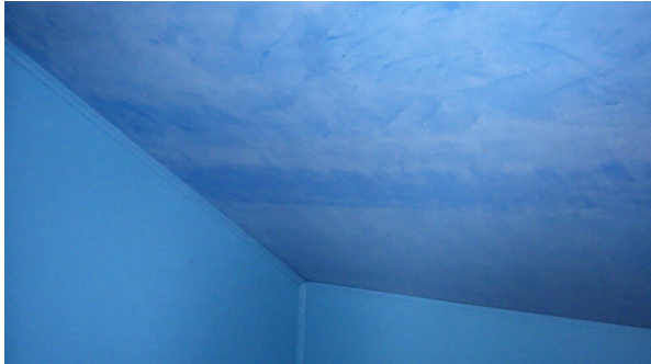
16. Kesähuoneen vino yläpohjarakenne
