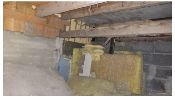
6. Ryömintätila kuistin kohdalla
