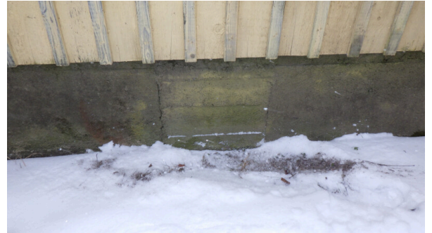
2. Tuuletusaukko valettu kiinni
