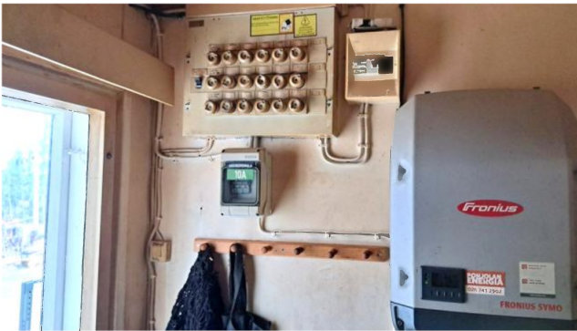
sulaketaulut + invertteri aurinkopaneeleihin
