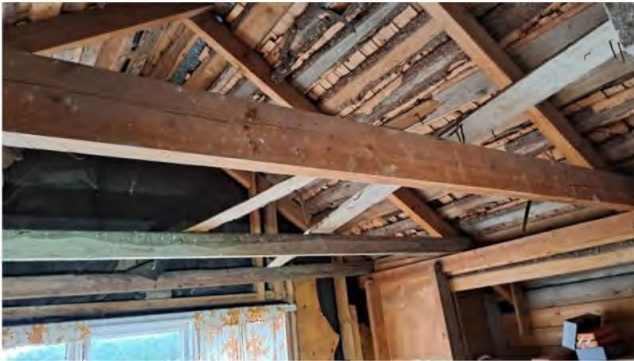
vanhan osan yläpohja
