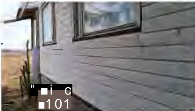
terassin ikkunat, ei vesipenkkipeltejä
