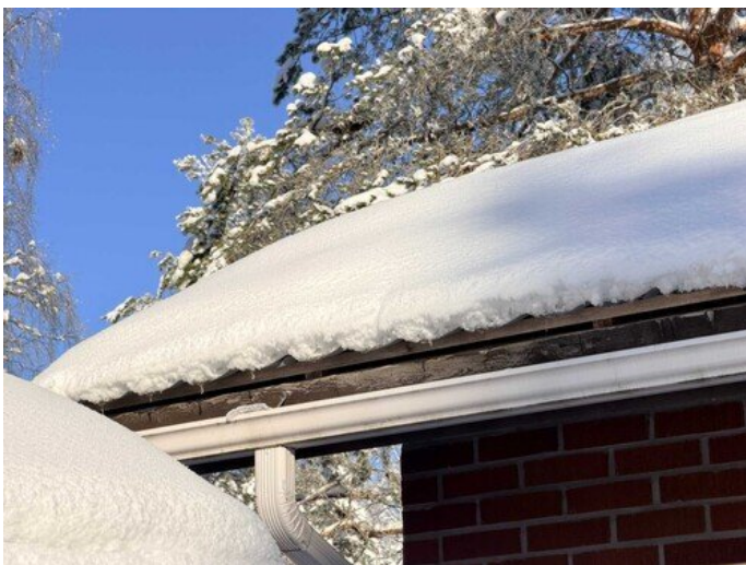
Kuva 2 Sadevesikourua ja syöksytorvea
