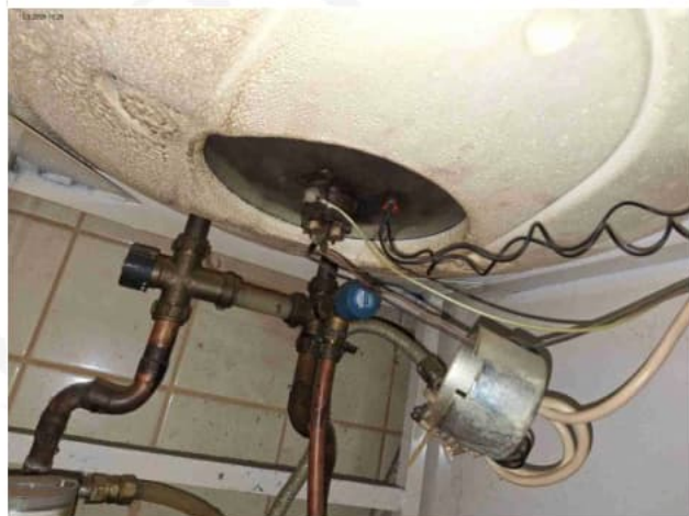
Kuva 14. Liittimien suoja irti
