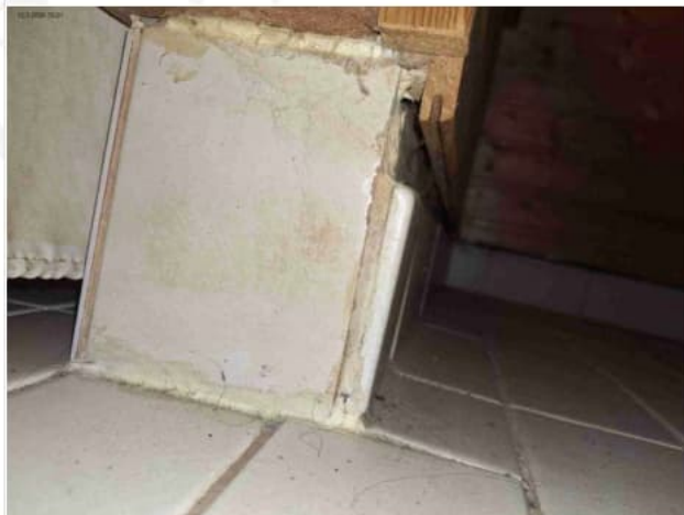
Kuva 11. Irtonainen laatta lattian ylösnostossa
