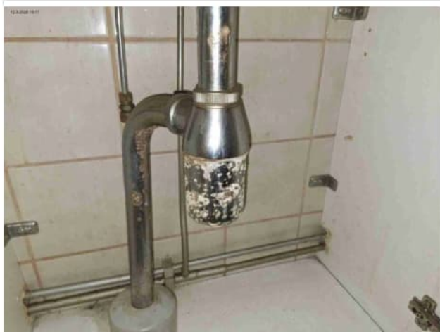
Kuva 9. Hapettumaa viemäriputkessa
