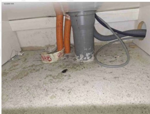
Kuva 4. Allaskaapin alustan tarkastus
