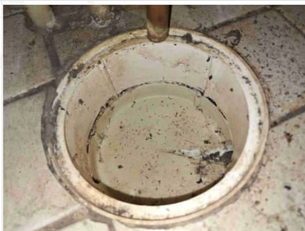
Kuva 13. Kaivo varaajan alla
