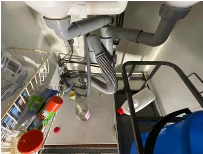
Kuva 37 Allaskaapissa ei havaittu kosteusjälkiä / kosteuspoikkeamia.
