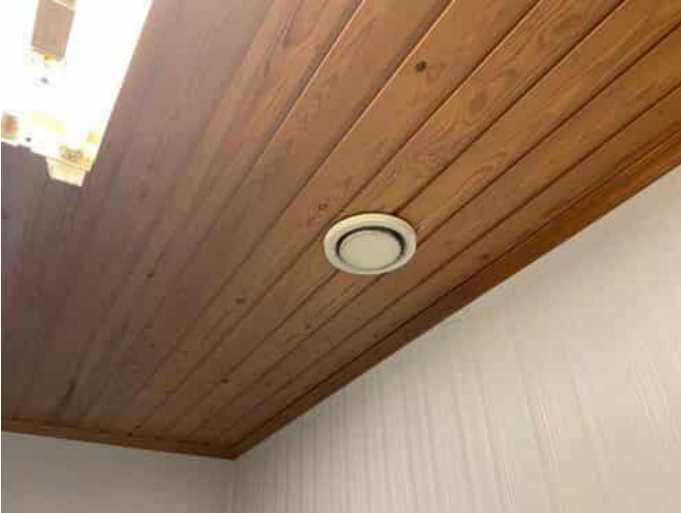
Kuva 34 KHH:ssa on koneellinen poistoilmanvaihto
