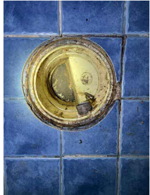
Kuva 52 Lattiakaivot ovat muovia ja niissä ei havaittu vaurioita.
