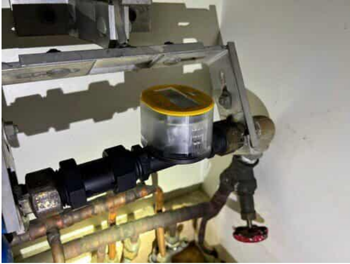
Kuva 49 Vesimittari LVV alla.
