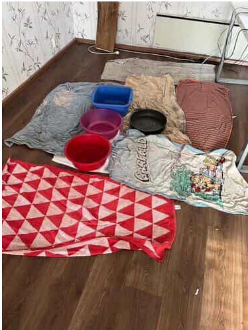
Kuva 43 3/2026 käynnillä ei havaittu vettä / aktiivisia vuotoja sisäkatossa. Lattiat/pyyhkeet/sisäkatto oli kuiva tarkastuskäynnin yhteydessä, vaikka keli oli plussalla ja lumi sulana.
