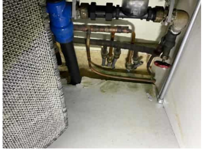
Kuva 50 Vesijohdot muoviputkea näkyvin osin.
