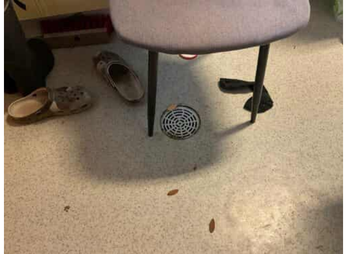
Kuva 35 Tilassa on lattiakaivo
