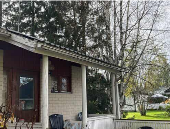
Kuva 18 Lumiesteet puuttuvat.
