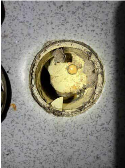
Kuva 51 Lattiakaivot ovat muovia ja niissä ei havaittu vaurioita.
