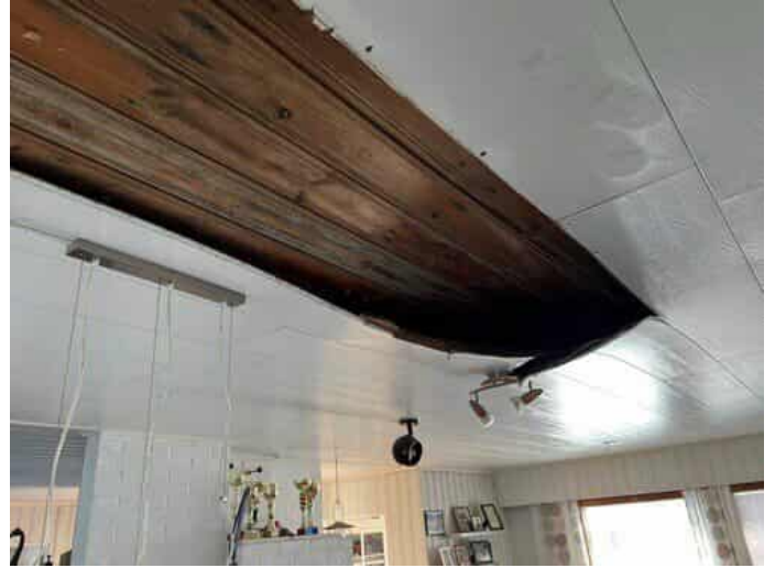
Kuva 42 3/2026 käynnillä ei havaittu vettä / aktiivisia vuotoja sisäkatossa. Lattiat/pyyhkeet/sisäkatto oli kuiva tarkastuskäynnin yhteydessä, vaikka keli oli plussalla ja lumi sulana.
