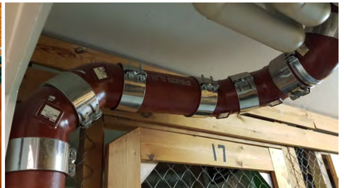
Kuva 26. Uusittua valurautaviemäriä kellaritilassa
