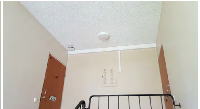
Kuva 28. Porrashuoneen poisto, kanavisto tiilihormina
