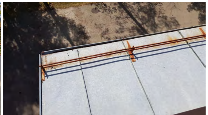
Kuva 16. Parvekkeiden rivipeltikate ja ruostuneet lumiesteet.
