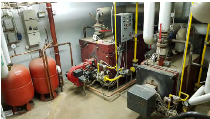
Kuva 21. Kaasupolttimet lämmönjakuhuoneessa
