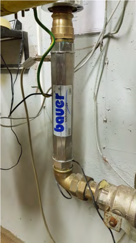
Kuva 23. Veden käsittelyjärjestelmä
