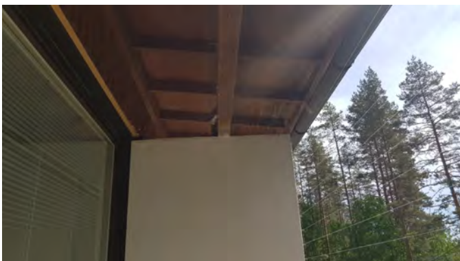
Kuva 14. Parvekekaton kantavia puurakenteita
