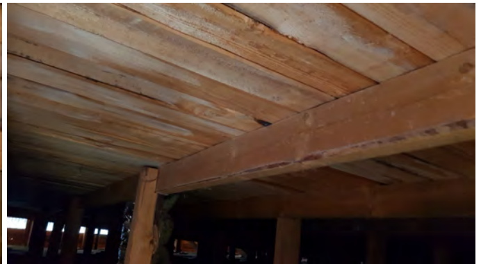
Kuva 13. Vesikaton aluslaudoitukset
