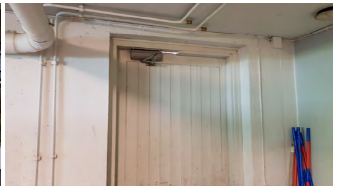
Kuva 9. Päätyvaraston puu-ulko-ovi, päivä paistaa ovilehden yläpuolelta.
