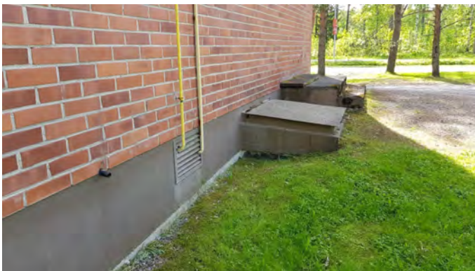
Kuva 4. Maan yläpuolista perustusrakennetta (lämmönjakohuoneen ulkoseinä)
