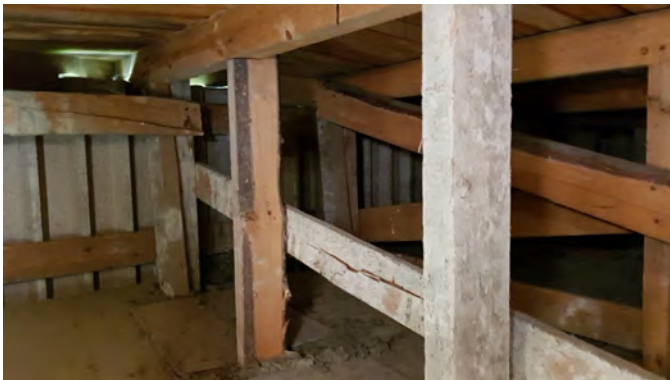
Kuva 12. Vesikaton kantavia puurakenteita
