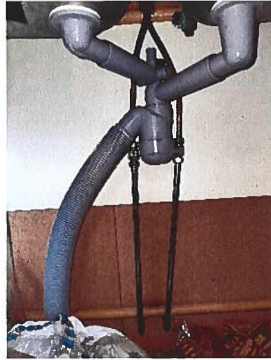
Tiskialtaan vesilukko on uusittu.
