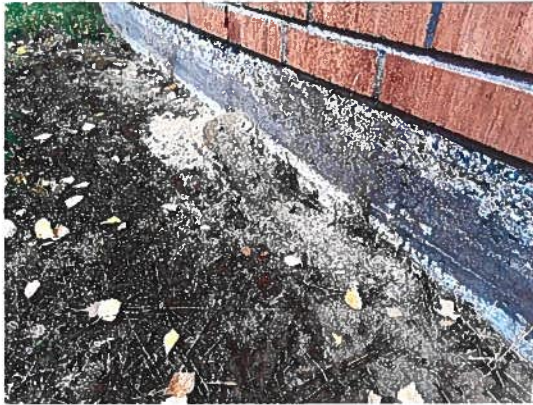
Erotuskaistat puuttuivat. Sokkelivierustoilla oli joko hienoa hiekkaa tai multaista maa-ainesta.
