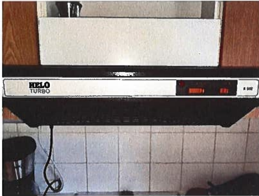
Liesituuletin aktiivihiihaisuodattimella.
