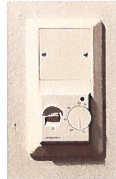
Osassa asuntoja lattialämmitystermostaatit uusittu. Osa suojattu vikavirralla, osa ei.
