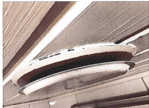
Poistoilmaventtiili.
