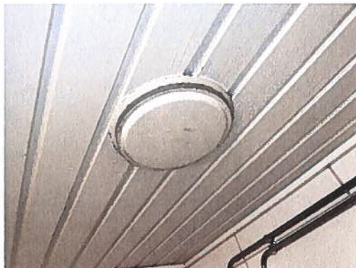
Poistoilmaventtiili.
