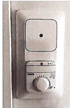
Osassa asuntoja lattialämmitystermostaatit uusittu. Osa suojattu vikavirralla, osa ei.
