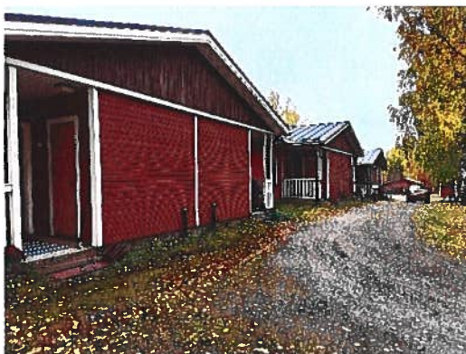
Varastojen panelointien kunto on hyvä.
