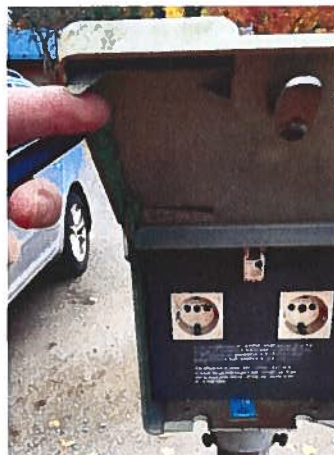
Lämmityspistorasiat alkavat olemaan elinkaaren päässä.
