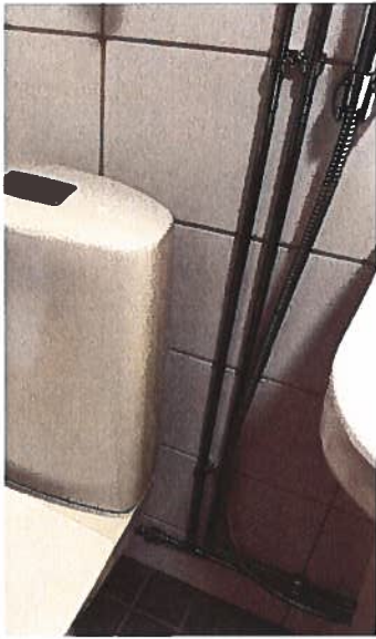
Kromikuparilla uusittuja käyttövesijohtoja.
