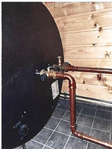
Lämminvesivaraaja (Jäspi).
