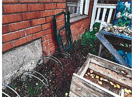
Sokkelivierustoilla istutuksia. Sokkelikorkeudet paikoin minimaaliset.
