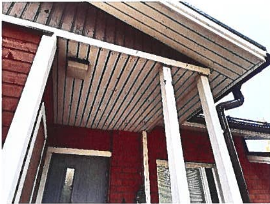
Räystäsrakenteet kunnostettu ja huoltomaalattu 2019.
