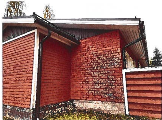
Julkisivupinnoilla jäkäläkasvustoa.
