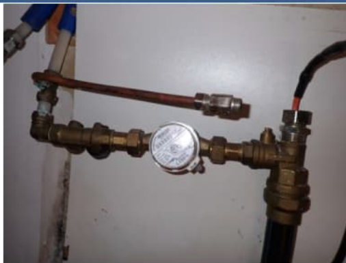
Kuva 29. Vesimittari.
