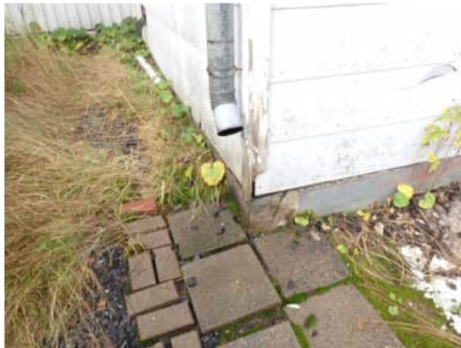
Kuva 23. Kattovedet johdettu rakennuksen vierelle.
