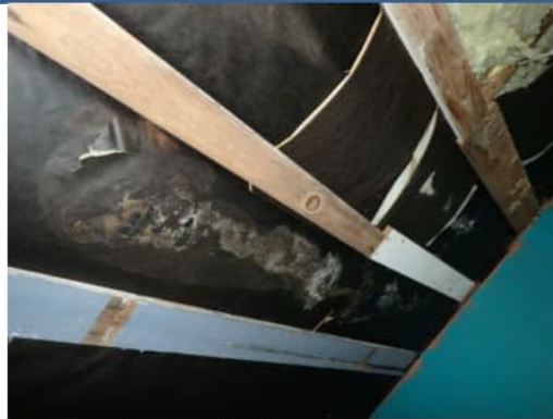
Kuva 37. Kosteusjälkiä tervapaperissa.
