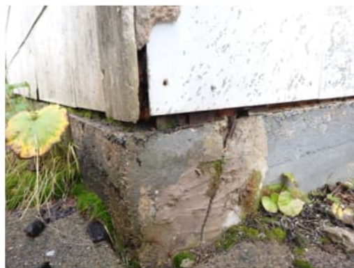
Kuva 4. Sokkelin halkeamaa.
