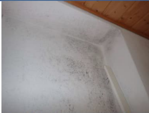
Kuva 40. Mikrobikasvustoa sisäpinnoilla.
