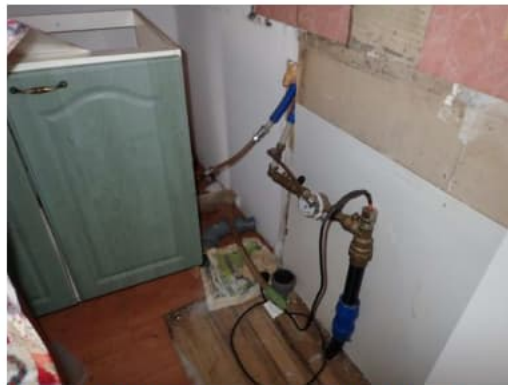
Kuva 39. Keittiön remontoiminen kesken.
