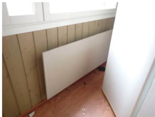
Kuva 32. Sähköpatteri.
