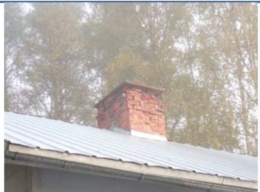
Kuva 28. Savupiipun yläosassa pakkasrapautumaa.
