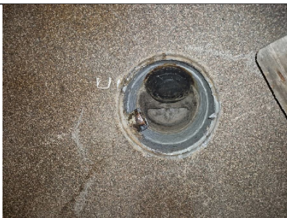
Kuva 5. Pinnoitettu lattiakaivo.
