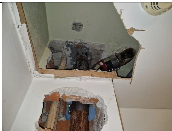
Kuva 6. Osin korjattua valurautaviemäriä.
