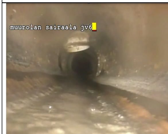
Kuva 11. Asennusvirhe jätevesiviemärissä.
