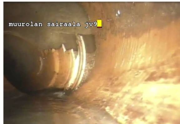
Kuva 6. Kaivon liitos irti.
