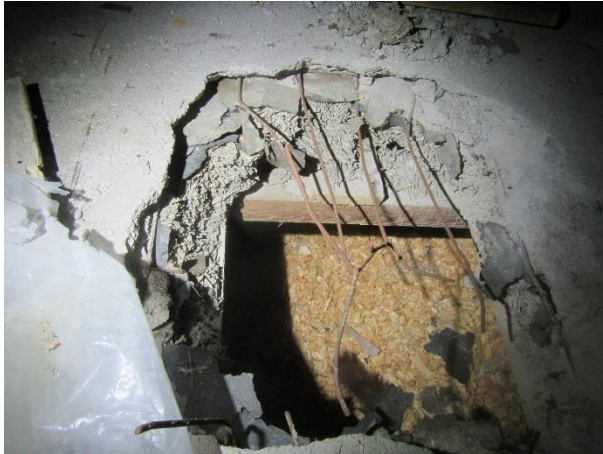
Kuva 172. Viistön osuuden rakenneavaus.
