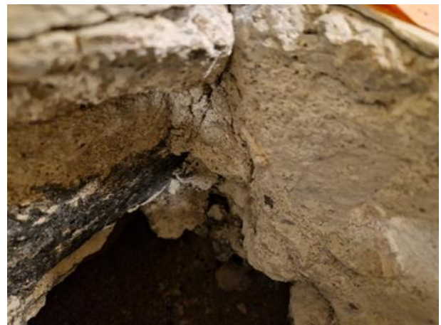
Kuva 32. Rakenneliittymä vaikutti tiiviiltä.
