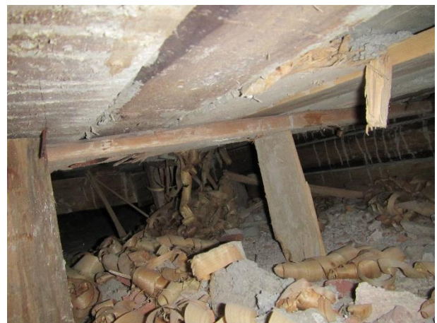
Kuva 140. Kutterilastua kotelotilassa.
