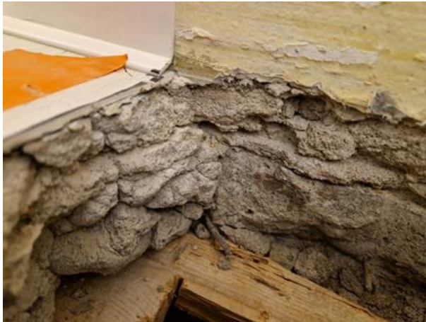
Kuva 137. Rakenneavaus RA68. Liittymä tiivis.
