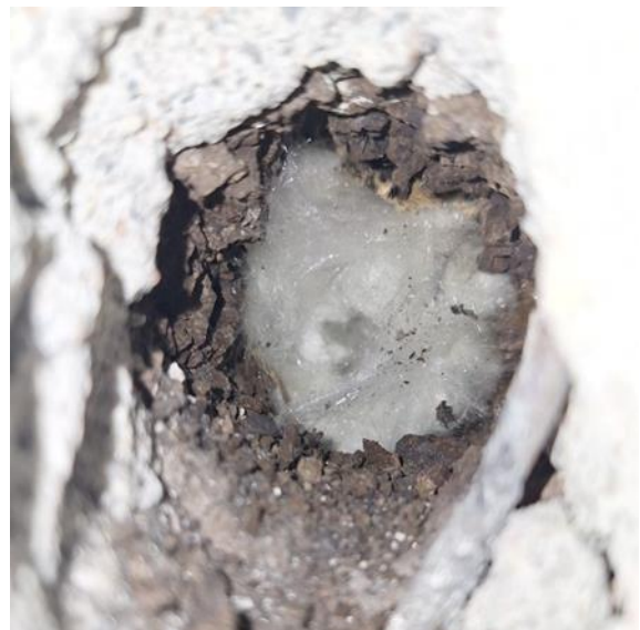
Kuva 94. Eristeenä korkkia ja lasivillaa.
