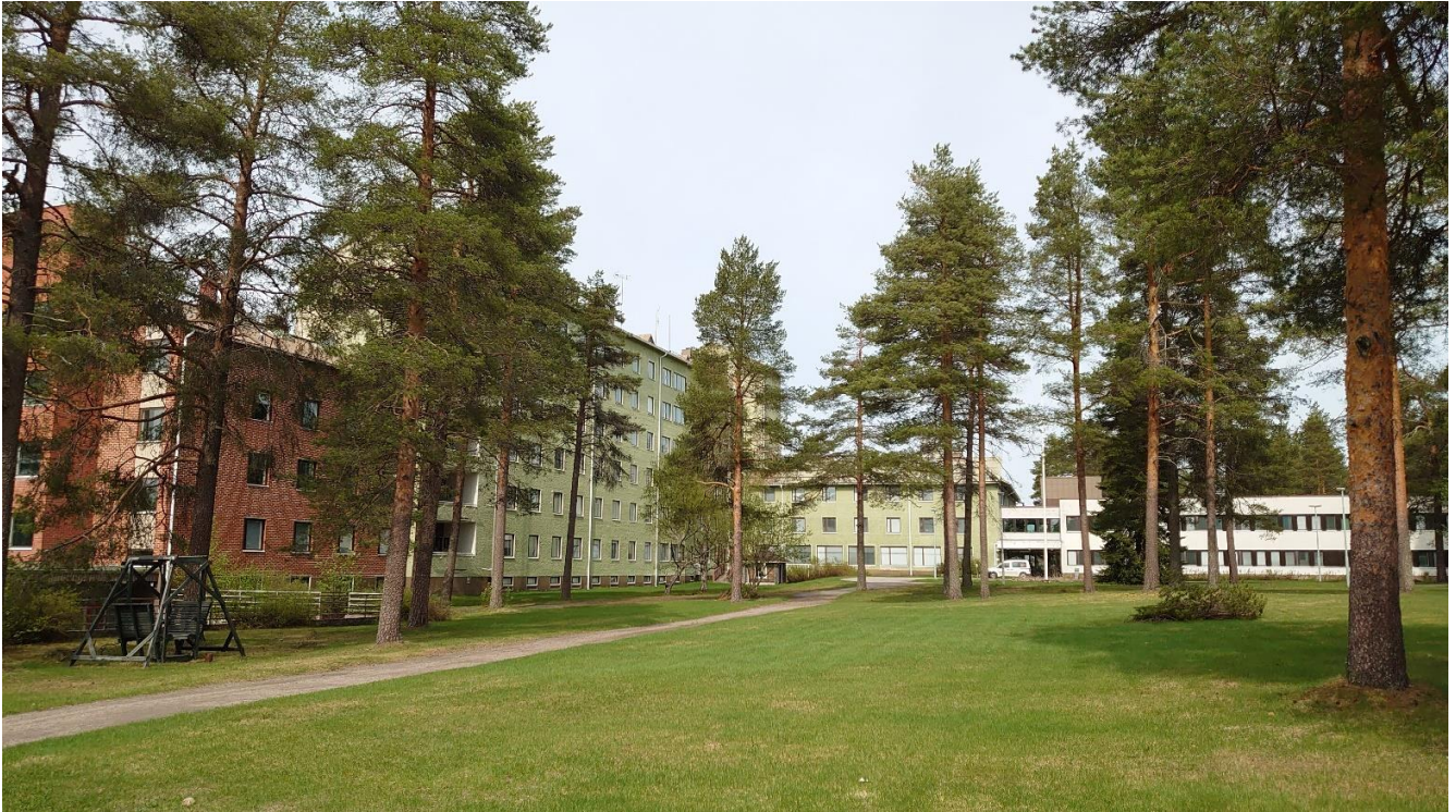
Kuva 62. Oikealla A-osa, sitten B-osaa ja korkea C-osa. C-osan jatkeena julkisivuiltaan tiilimuurattu D-osa.
