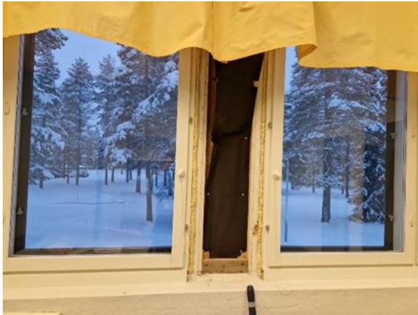
Kuva 74. RA30, ikkunaliittymä.
