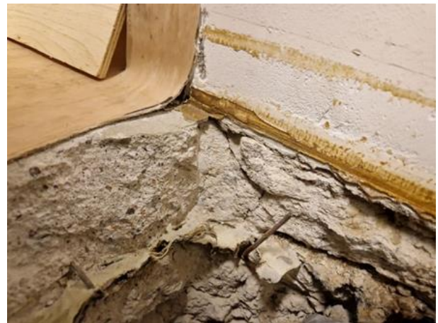
Kuva 142. Betonirakenteiden välissä muovia ja bitumisively.
