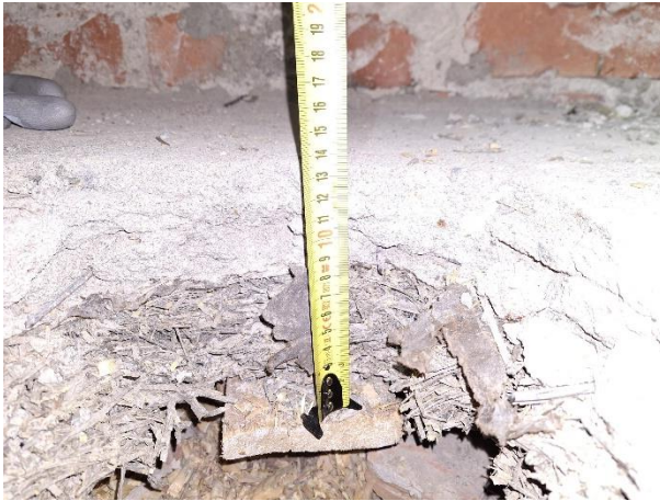
Kuva 177. RA87. Yleiskuva avauksesta.
