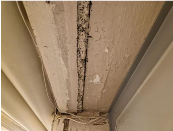
Kuva 48. B-osa, tila 069B. Oviaukossa toja-levy näkyvillä → ilmayhteys eristetilaan.
