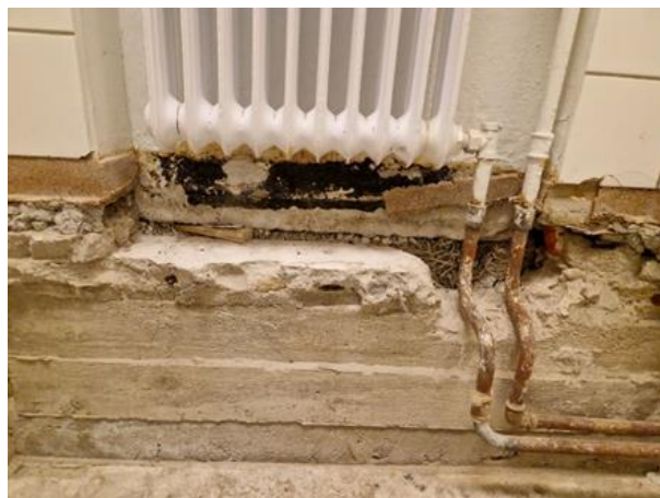
Kuva 121. D-osa, tila 2040. Välipohjarakenteessa lämpöputkia. Ulkoseinärakenteessa eristeenä Toja-levyä.
