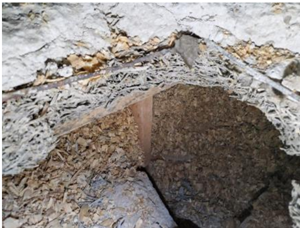
Kuva 170. RA51. Avattiin alakattorakennetta.
