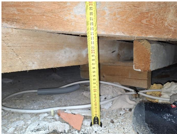
Kuva 168. Yläpohjatila on matala.
