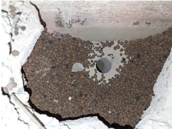
Kuva 40. Lämmöneristeen kevytsoraa. Täyttöhiekkä kuivaa.
