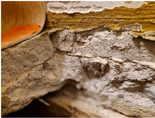
Kuva 131. Rakenneavaus RA63. Rakenne tiivis.
