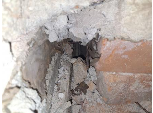
Kuva 152. Mahdollinen ilmayhteys hormirakenteeseen.
