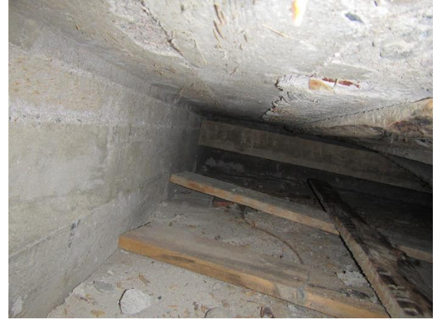
Kuva 162. Muottipuuta ei kauttaaltaan.
