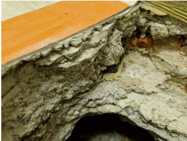
Kuva 126. Betonivalujen välissä pikisively.
