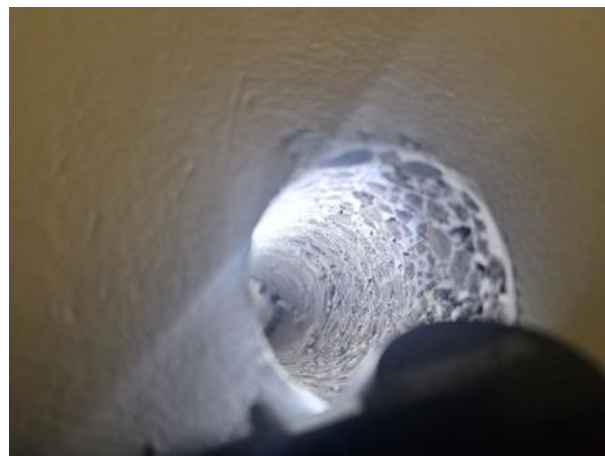
Kuva 58. Rakenne muodostuu kevytsoraharkosta
