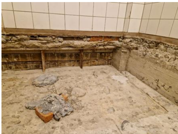
Kuva 120. D-osa, tila 2040. Välipohjarakennetta avattu vesivuodon takia. Muottirakenteita paikoillaan.
