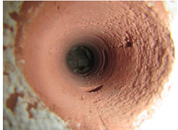
Kuva 70. RA25. Materiaalinäyte mineraalivillasta.
