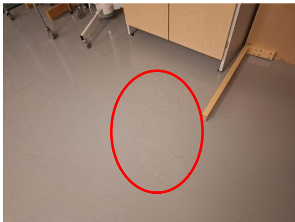
Kuva 20. Tila 010. Muovimatossa kupruja.
