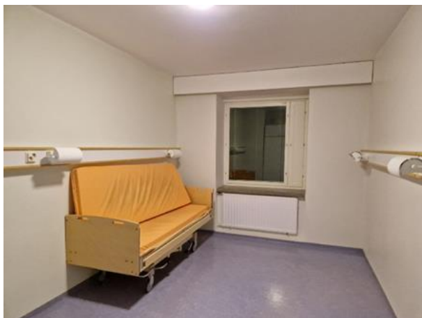
Kuva 116. C-osa, 3. kerros 3035 lattiassa muovimattoja.
