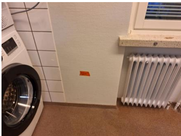
Kuva 95. Rakenneavauksen RA53 sijainti.
