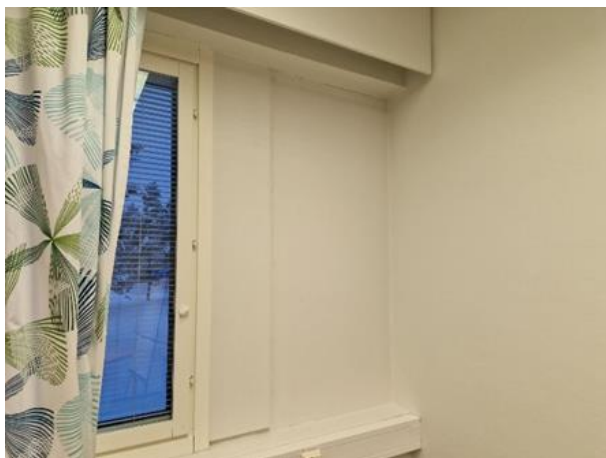
Kuva 63. A-osalla ikkunaliittymissä levyrakenteita.
