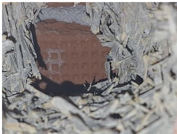
Kuva 96. Eristeenä toja-levyä.
