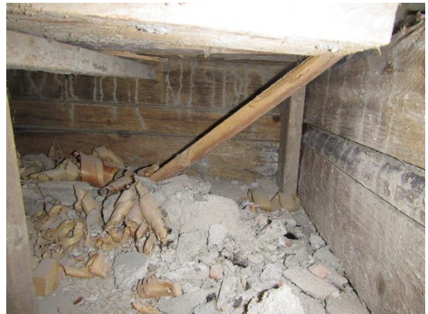
Kuva 154. Kotelossa kuterilastua.
