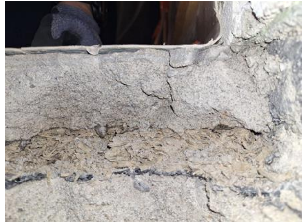
Kuva 36. RA8. Rakenneliittymä vaikutti tiiviiltä.
