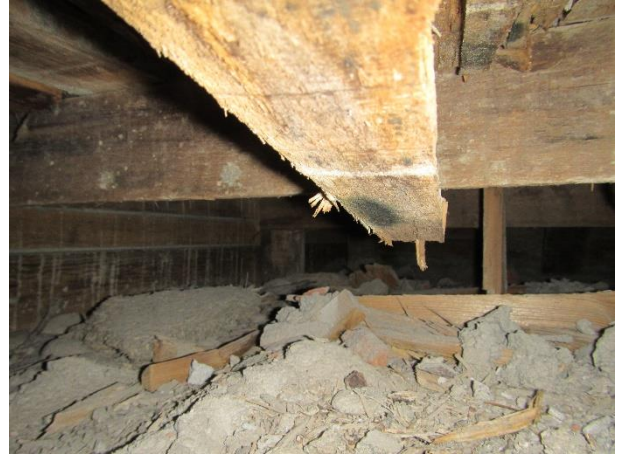
Kuva 144. Muottilaudoituksessa tummentumia.
