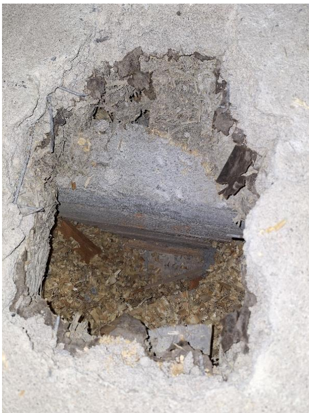
Kuva 176. RA87. Yleiskuva avauksesta.
