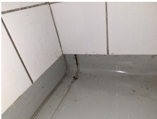
Kuva 18. Muovimaton saumat ratkeilevat, tila 060.
