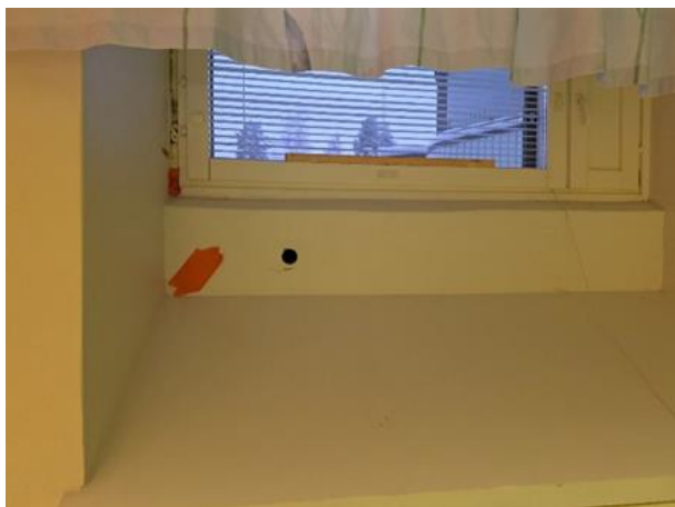
Kuva 57. Rakenneavaus ikkunan alapuolelle.
