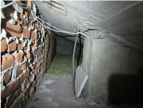
Kuva 167. Puhallusvillaa yläpohjarakenteen lämmöneristeena.
