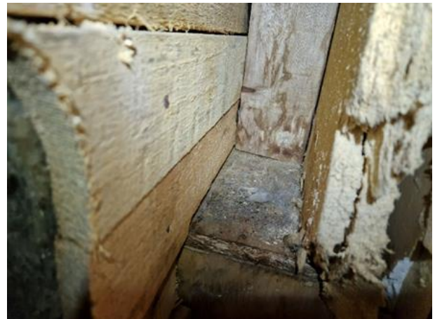
Kuva 99. Kosteusjälkiä puurakenteissa.
