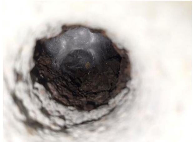
Kuva 92. Eristeenä korkkia ja lasivillaa.
