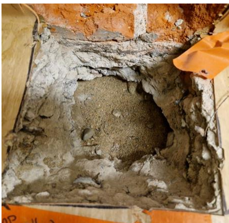
Kuva 24. Yleiskuva RA1 Täyttöhiekka kuivaa.
