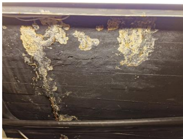
Kuva 164. Ruostunutta raudoitusta.
