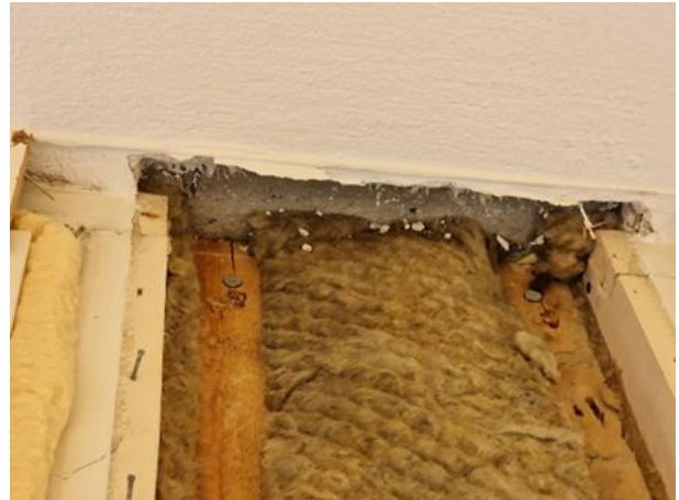
Kuva 75. RA30. Mineraalivillaeristeestä otettiin materiaalinäyte.
