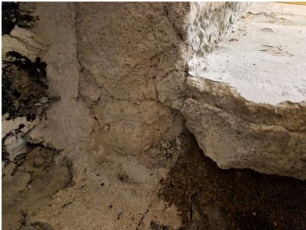
Kuva 28. RA3. Tiiveys maalin varassa
