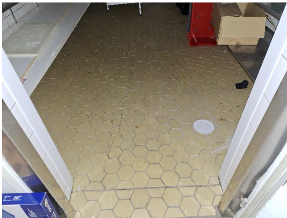
Kuva 15. Lattioiden 6-kulmalaatoitus ei sisällä asbestia.
