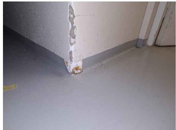
Kuva 16. Kuivien tilojen seinä- ja kattotasoihteet eivät sisällä asbestia..
