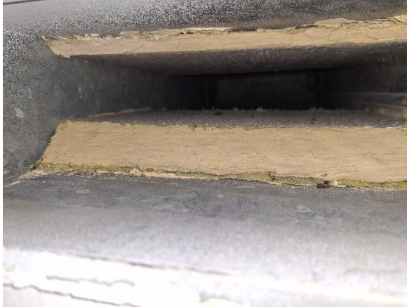
Kuva 21. Teräksisten ilmanvaihtokanavien ääneneristevilloituksen kiinnitys- ja kapselointiliima ei sisällä asbestia
