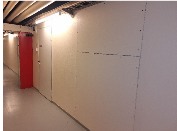
Kuva 18. C-osan kellarikäytävän 002 lujalevytyks ei sisällä asbestia (analyysiraportti
