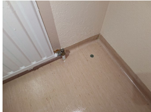
Kuva 20. Kuivien tilojen muovimatot ja niiden liimat sekä tasoitteet eivät sisällä asbestia.
