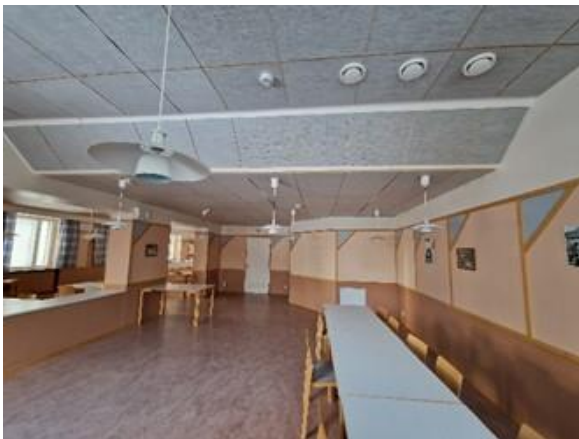
Kuva 25. Tilassa 3114 (HK:n ruokasali) ainoastaan koneellinen poisto. Tilan akustiikkalevyt ovat mahdollisia kuitulähteitä.
