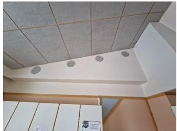
Kuva 26. Tilan 3114 (HK:n ruokasali) tilan päätelaitteita tutkittu.
