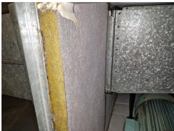
Kuva 3. TK01 – kammion äänieristyslevy pinnoittamatta.
