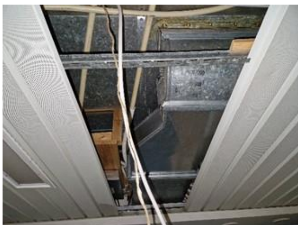
Kuva 21. Osassa käytäviä on reikäkattopaneelit.
