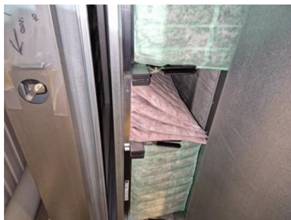
Kuva 12. TK1 TF01 – liian pitkät suodatinpusstit.
