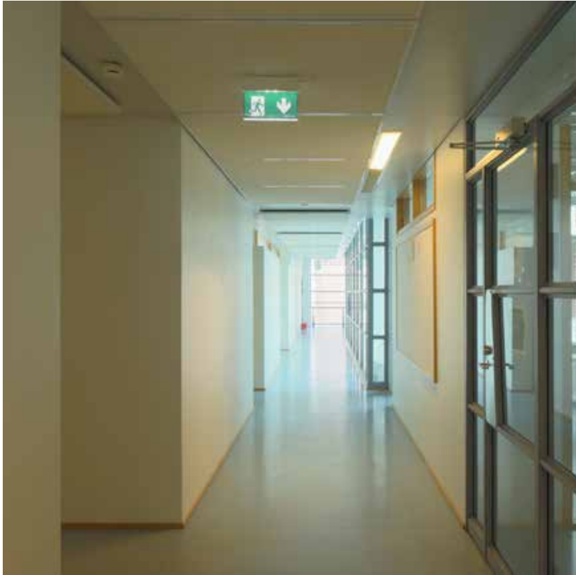
↑ Toisen kerroksen C-osan 202.1 käytävä kuvattuna Vuorikadun päädyn suuntaan. Poikkikäytävien toimistojen kohdalla käytävän alakattoon on upotettu pitkänmallisia valaisimia.
