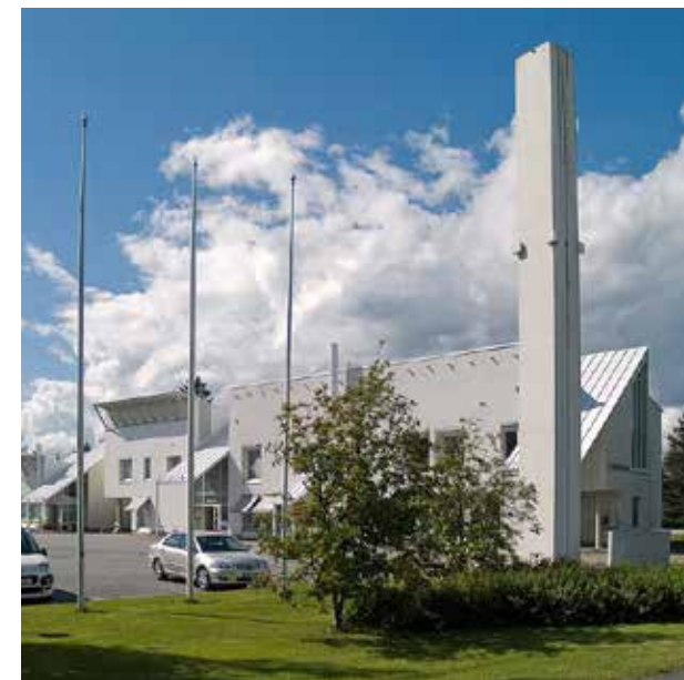
↑ Valokuva entisestä Ylistaron virastotalosta vuodelta 2012. Rakennuksen suunnitteli arkkitehti Kari Järvinen, ja virastotalo valmistui vuonna 1989. Julkisivua rytmittävät jyrkät lapettikatot laskevat rakennuksen puolelta toiselle vaihdellen. Alkuperäistä valokuvaa on rajattu. Valokuvaaja Kotivalo CC BY-SA 3.0.
