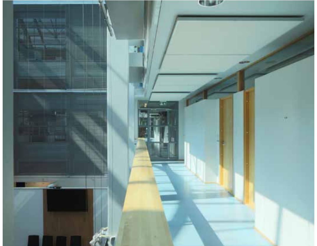
↑ Toisen kerroksen käytävä numero 201.1 A-osan avonaisen atriumin kohdalla. Käytävässä on hyvin säilyneet alkuperäiset puulasikaiteet, lattiamatto, alakatto sekä väliseinät laakaovineen.
