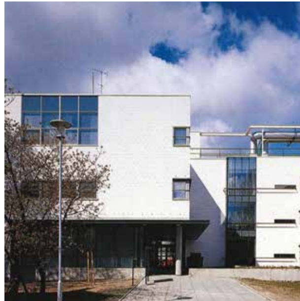
↑ Vuonna 1990 rakennettu Joensuun virastotalo. Sen valkoinen tiilijulkisivu koostuu solumaisista massoista, joiden väliin muodostuu valopihoja. Katon talotekniikka ja kanavat on jätetty näkyviin, mikä korostaa virastotalon uudenlaista tyyliä. Rakennuksen suunnitteli Gullichsen-Kairamo-Vormala arkkitehdit Ky. Valokuvaaja Jussi Tiainen.
