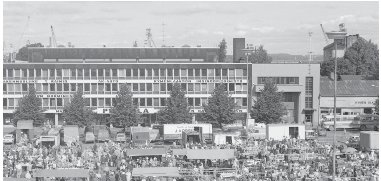
↑ Kotkan kauppatori kuvattuna pohjoiseen vuonna 1973–1974. Torin pohjoisreunaa rajaa selvä ja eheä rakennusten korttelijulkisivu. Valokuvan rakennuksista vain kaupungin rahatoimisto (ent. Suomalainen Säästöpankki) on säilynyt. Valtion virastotalo rakennettiin valokuvan oikean reunan puoleisen liikeyrityksen tilalle. Valokuvaaja Teuvo Kanerva. MV.
