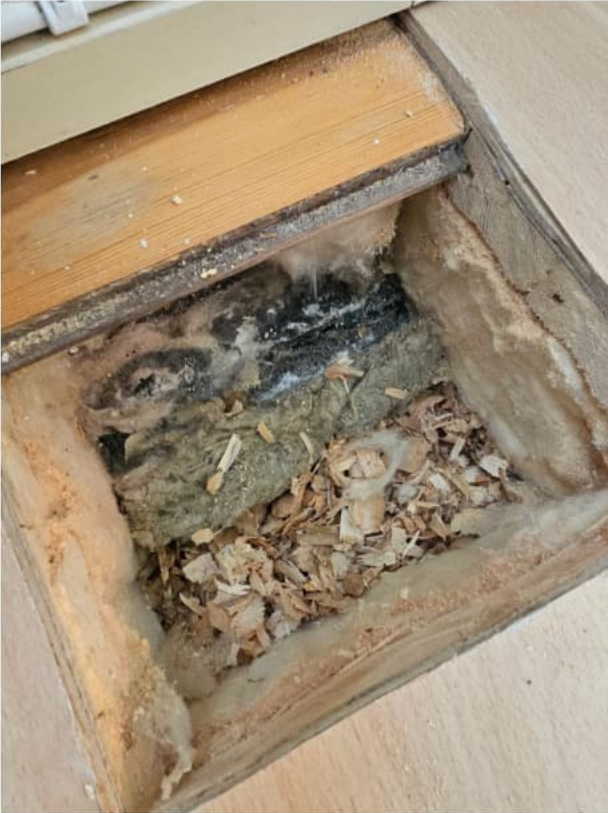
Lasivillan alla mineraalivillaa ja kutterinlastua / sahanpurua
