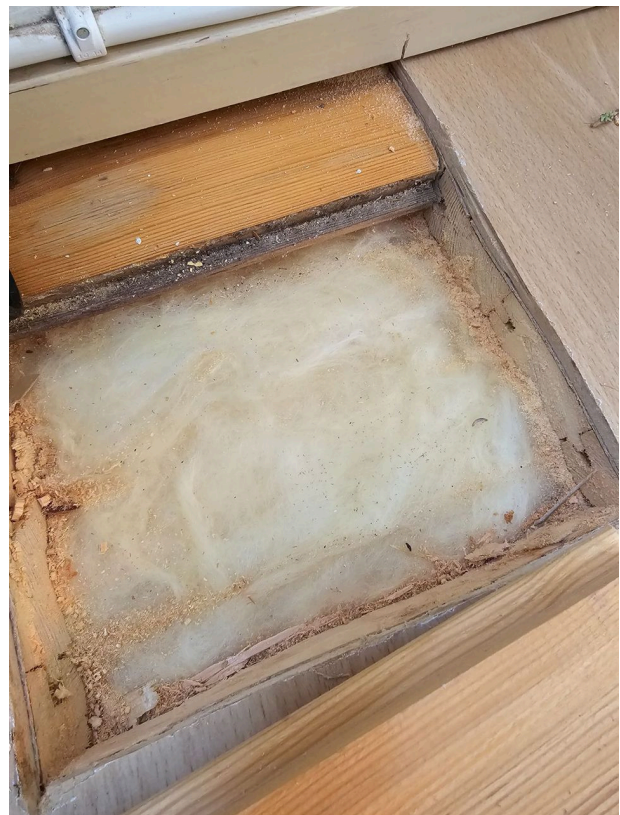
Lautalattian alla siistikuntoinen lasivillaeriste
