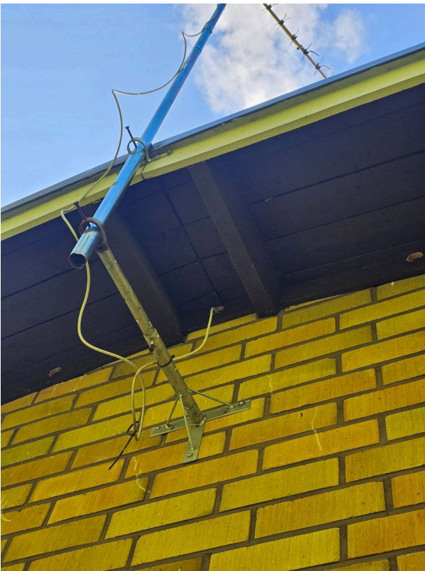
Toisessa päädyssä tuuletusta on lisätty poraamalla reikä päätykolmion yläosaan
