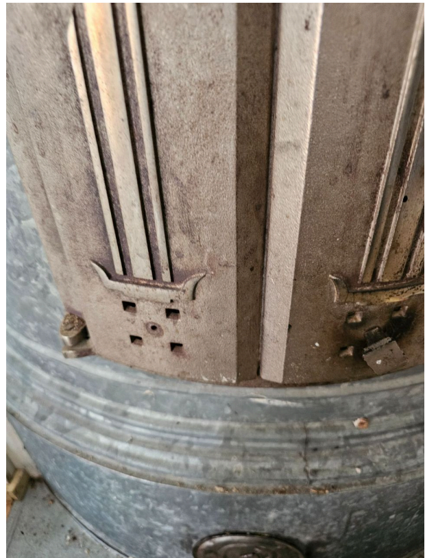
Pönttöuunin luukun nappi puuttuu
