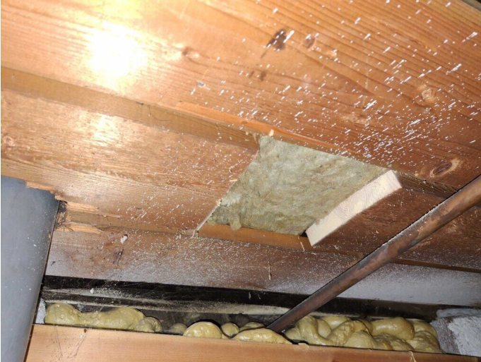
Kuva 17 Asuinkerroksen puualapohjan alapintaan tehdyn rakenneavauksen kautta havaittiin, että alapohjan lämmöneristeenä on mineraalivilla. Asuinkerroksen puualapohjarakenne kallistaa paikoin kellarissa ulkoseinäperusmuuria kohti, mutta tarkastuksella ei saatu varmuutta, onko rakenteisiin tehty muutoksia/korjauksia vai ovatko rakenteet painuneet.
