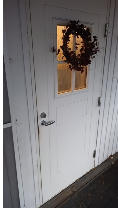
Kuva 54 Asuinkerroksen uusitut puu-ulko-ovet ehjät ja kunnossa.
