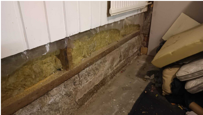
Kuva 7 Rakennuksen luoteispäädystä (kellariportaikon pääty) ulkoseinäpuurunko lähtee maanvastaisen betonisen ulkoseinäperusmuurin leuan päältä noin 330...380 mm kellarin lattiapintaa ylempää. On todennäköistä, että päädystä on ollut aiemmin samanlainen rivinteeri-muuraus kuin muualla kellarissa, mutta tämä on purettu ja korvattu pystypuurungolla. Puurungon ja betonirakenteen välissä ei ollut kapillaarikatkoista. Luoteispäädystä (kellariportaikon pääty) betoniperusmuurin alaosassa ulkopuolisen kosteusrasituksen aiheuttamaa rapautumaa ja kalkkihärmää
