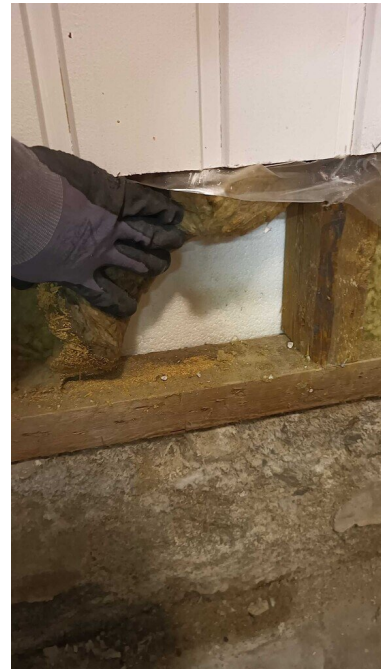
Kuva 8 Puurungon ja betonirakenteen välissä ei ollut kapillaarikatkoista. Päädyn pystypuurunko erotettu maanvastaisesta ulkoseinäperusmuurista 50 mm paksulla solumuovieristeellä. Tarkastetuilta osin maanvastaisten ulkoseinien puurakenteissa ei havaittu lahovaurioita.
