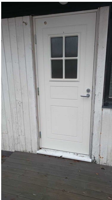
Kuva 55 Asuinkerroksen uusitut puu-ulko-ovet ehjät ja kunnossa.
