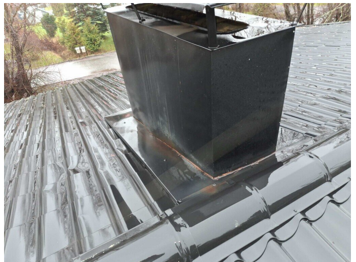
Kuva 60 Uusittu tiilikuvioitu profiilipelti-vesikate pääosin ehjä ja kunnossa. Vesikatteessa paikoin jokusia lommoja ja vesikate paikoin roskaantunut. Savupiipun pellitykset ja piipunhattu ehjät ja kunnossa. Havaintojen mukaan öljykattilan savuhormin teräksinen sisäputkitus puuttuu.
