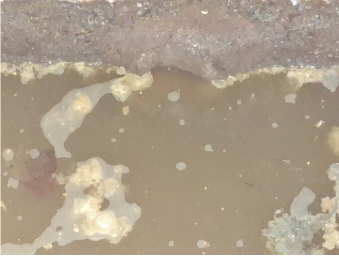
Kuva 45 Rakennuksen jätevesiviemärin todennäköisesti alkuperäinen betoninen saostuskaivo tontin takapihalla tarkastettiin silmämääräisesti. Saostuskaivossa vedenpinta tarkastushetkellä oli hyvin korkealla ja kaivolta purkava viemäriputken suuaukko vedenpinnan alapuolella. Vettä jätevesiviemäriin laskettaessa havaittiin saostuskaivossa vedenpinnan lievää virtausta, mikä viittaa siihen, että jätevesi poistuu kaivosta hiljalleen. Saostuskaivosta jätevedet johdettu tontin rajalla olevaan avo-ojaan muoviviemärillä.
