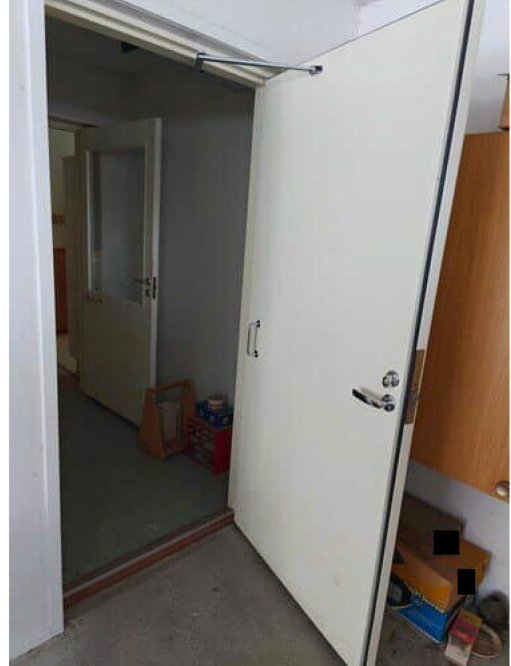
Kuva 63 Autotallin ja asuintilojen välinen ovi pitäisi olla itsestään sulkeutuva osastoiva ovi
