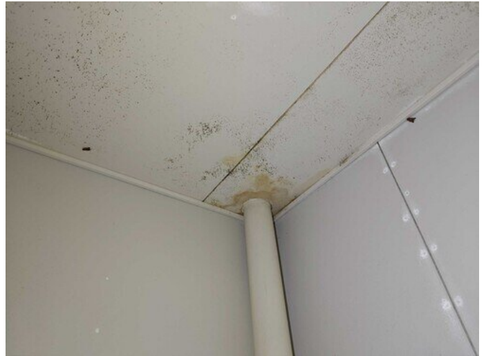
Kuva 41 Sisäkaton vauriojälkiä
