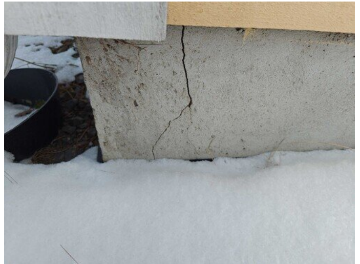
Kuva 4 Autotalli laajennuksen päädyn harkkomuurauksen saumahalkeamaan
