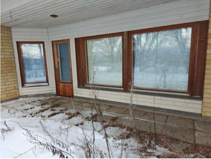
Kuva 21 Takapihan ovea ja ikkunoita
