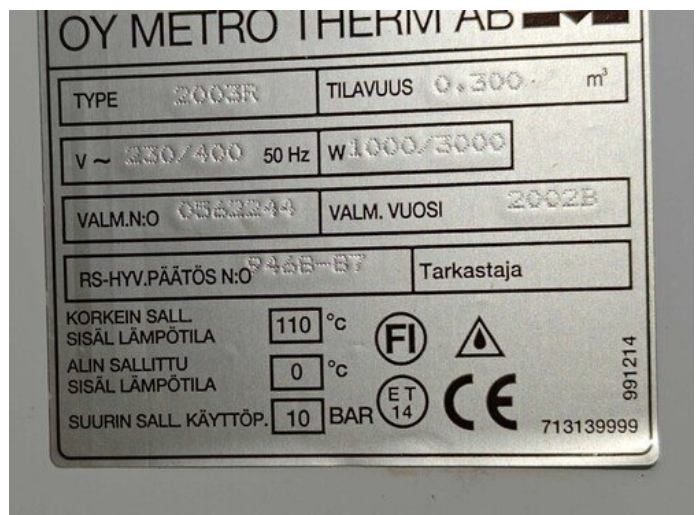
Kuva 67 Lämminvesipareen tyyppikilpi
