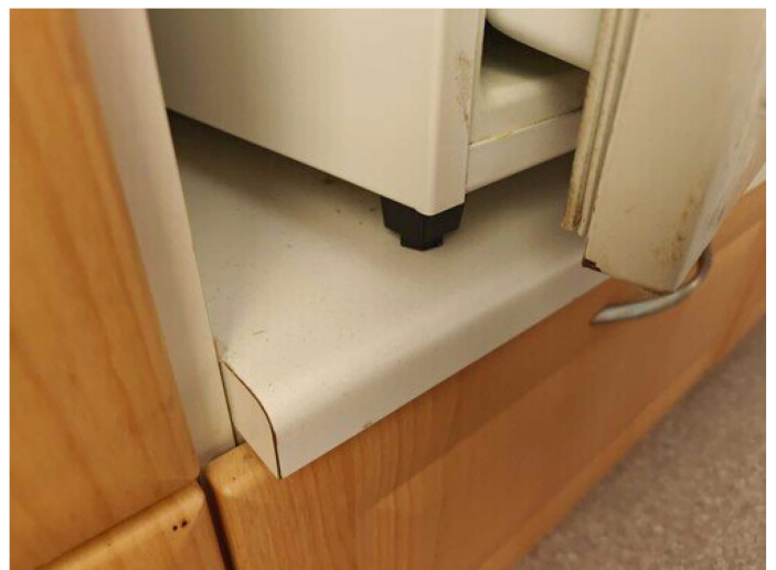
Kuva 45 Kylmälaitteen alla ei ole valumakaukaloa
