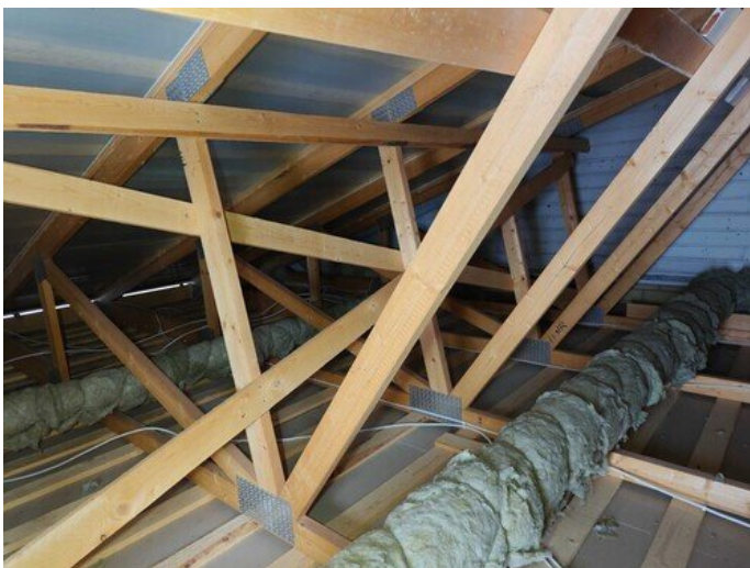
Kuva 25 Autotallin yläpohjaa, putkieristystä ja peltikatteen alla olevaa aluskatetta. Näkymää räystästuuleuksesta
