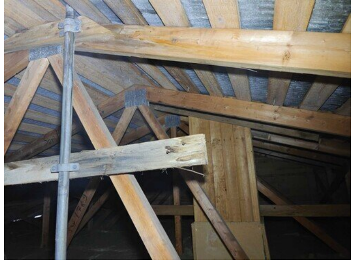
Kuva 32 Antennin putken läpivientiä ja hormikotelo
