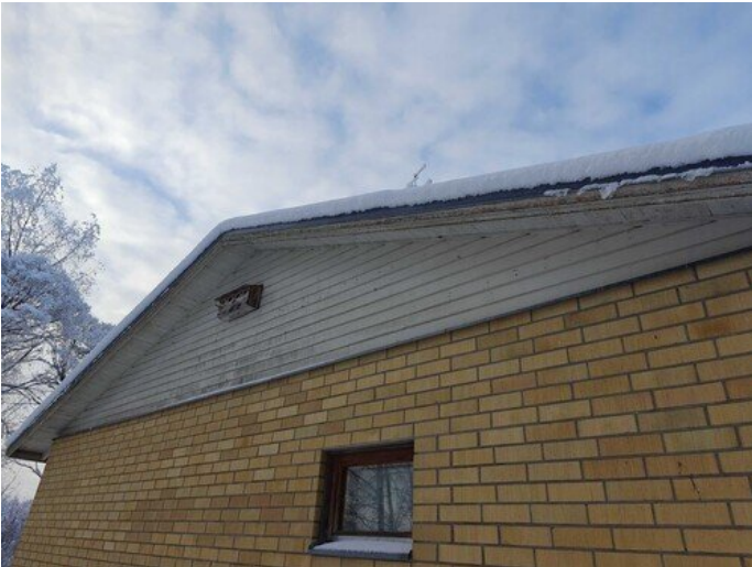
Kuva 10 Alkuperäisen osan päätylaudoituksen pinnan haristumaa
