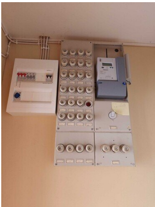
Kuva 70 Sähköpääkeskus
