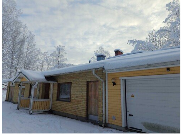
Kuva 23 Autotallilajennuksen lumiestettä ja sisäänkäynnin katosta
