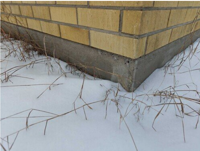
Kuva 3 Sokkelia ja sokkelin vierustaa
