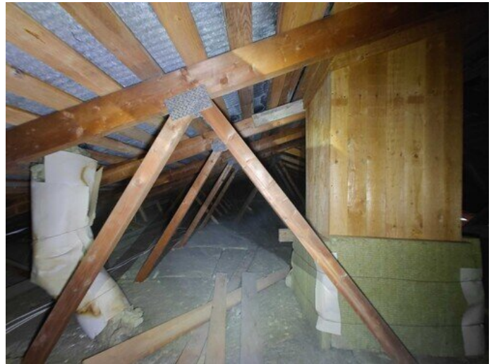
Kuva 30 Hormi kotelo ja viemärin tuuletusputken lämmöneristystä
