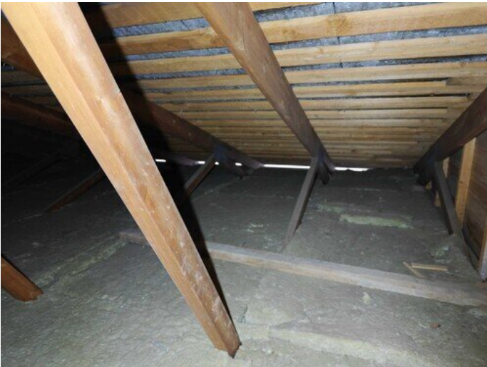
Kuva 29 Rästästuuletusta ja eristetilaa
