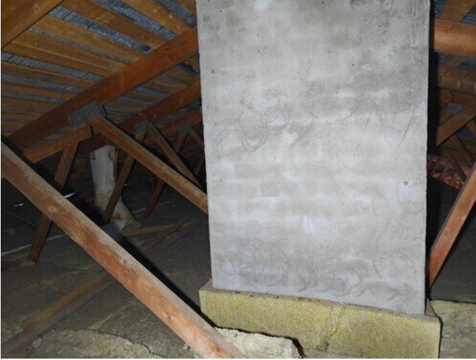
Kuva 27 Alkuperäisen osan savupiippua ja putkieristystä
