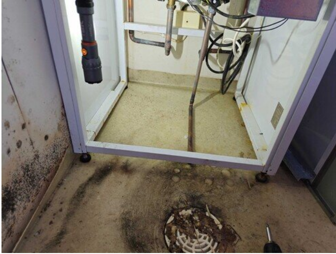
Kuva 68 Näkymää varajana alapuolelta ja lattiakaivoon
