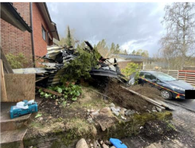
Naapurin pihalle nostettu palojetettä.
