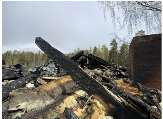
Palokunta purkanut vesikaton pois.
