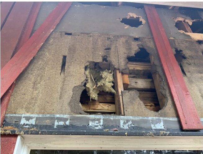
Seinän rakenne näkyvissä.
