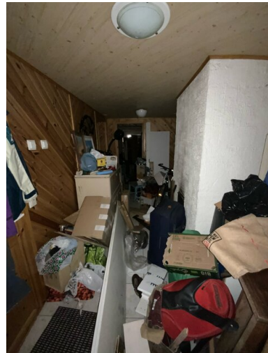
Kellarikerroksen takkahuone. Lattia laatoitettu, katto ja seinät paneloitu.
