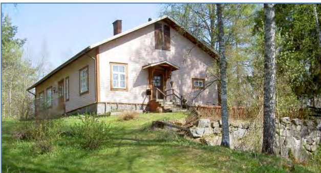
Retkeilymajan eteläinen ja läntinen julkisivu.
