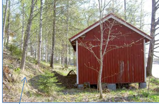
Saunarakennus idästä ja lännestä kuvattuna. Olutkellarin kiveys alkaa heti saunan pohjoispuolelta. Sauna on nurkkakiville perustettu huopakattoinen hirsirakennus, jossa on pysty peiterimavuoraus. Ulko-ovi puuttuu, myös sisätiloja on turmeltu.
