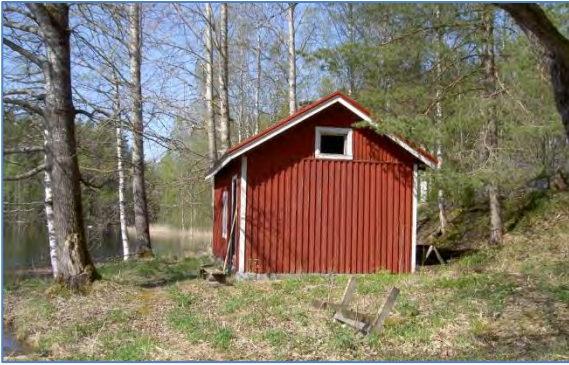
Saunarakennus idästä ja lännestä kuvattuna. Olutkellarin kiveys alkaa heti saunan pohjoispuolelta. Sauna on nurkkakiville perustettu huopakattoinen hirsirakennus, jossa on pysty peiterimavuoraus. Ulko-ovi puuttuu, myös sisätiloja on turmeltu.
