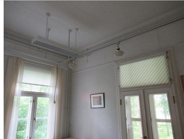
Kuva 22. Päärakennuksen valaisinvirtakisko.
