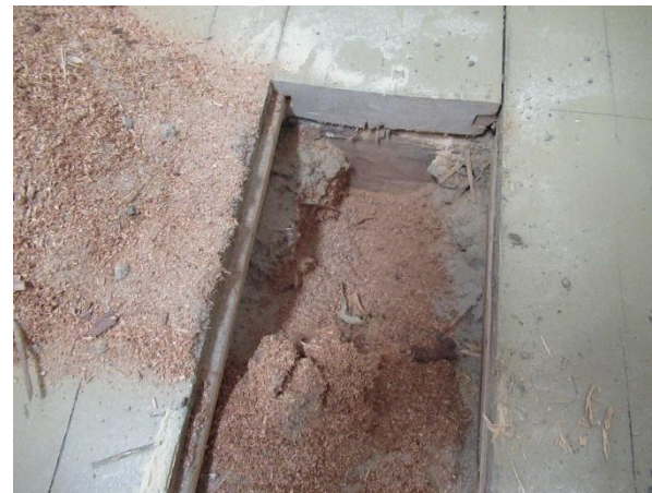
Kuva 8. Alapohjan rakenneavaus 2, päärakennus
