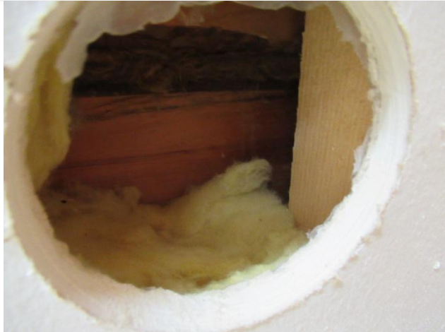
Kuva 13. Rakenneavaus 6, päärakennuksen ulkoseinä
