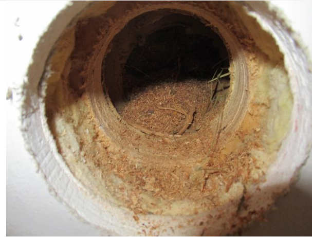
Kuva 14. Rakenneavaus 9, retkeilymajan ulkoseinä
