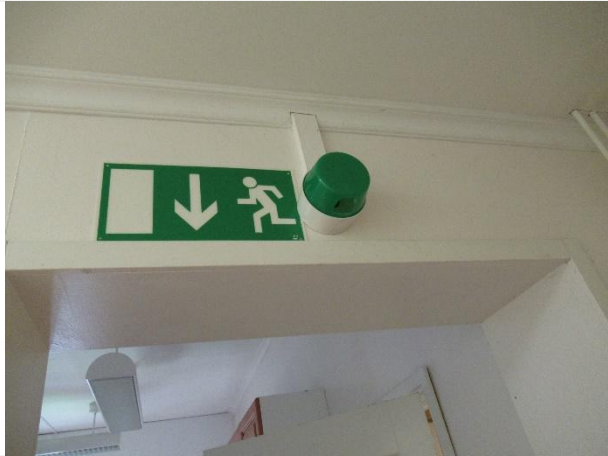
Kuva 21. Sivurakennuksen poistumistievalaisin.
