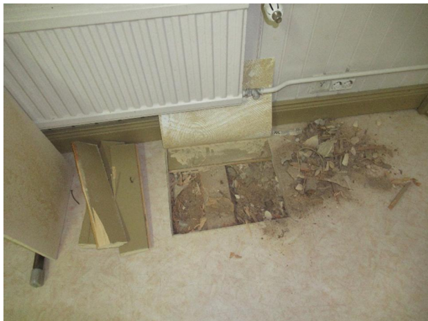
Kuva 7. Alapohjan rakenneavaus 1, päärakennus
