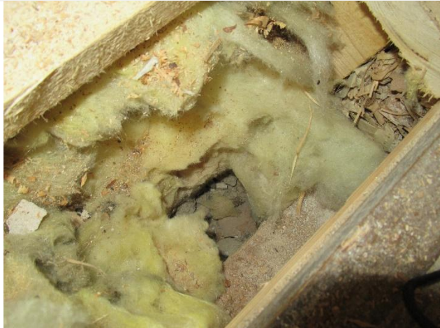
Kuva 9. Alapohjan rakenneavaus 8, retkeilymaja
