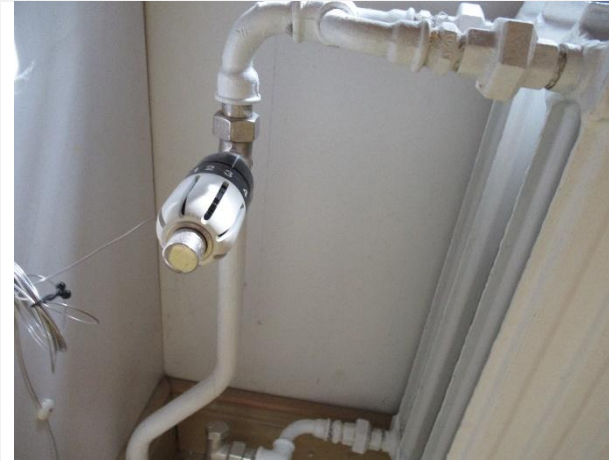
Kuva 18. Patteriventtiilit ehdotetaan uusittavaksi.
