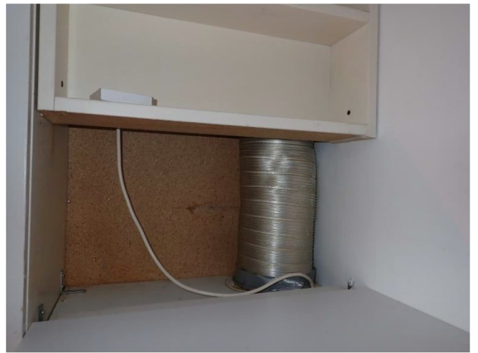
Liesituulettimen poistoputki tehty alumiinisesta haitariputkesta.
