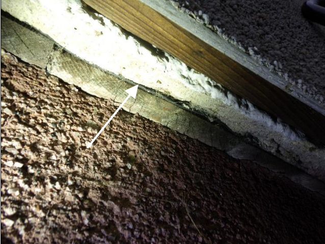
Kuva 8. Ulkoseinän alaosa. Bitumikermi.
