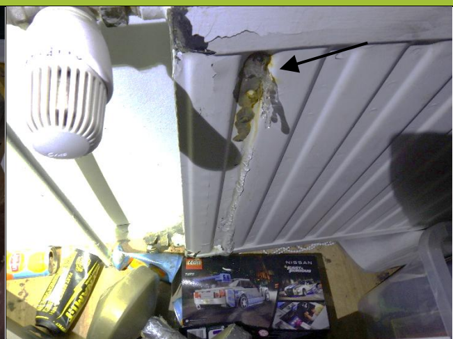
Kuva 28. Lämmityspatteri. Jäätymisvaurio.
