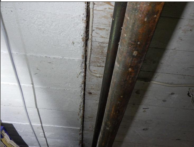
Kuva 5. Välipohjassa osin puurakenne ja osin betonilaatta.
