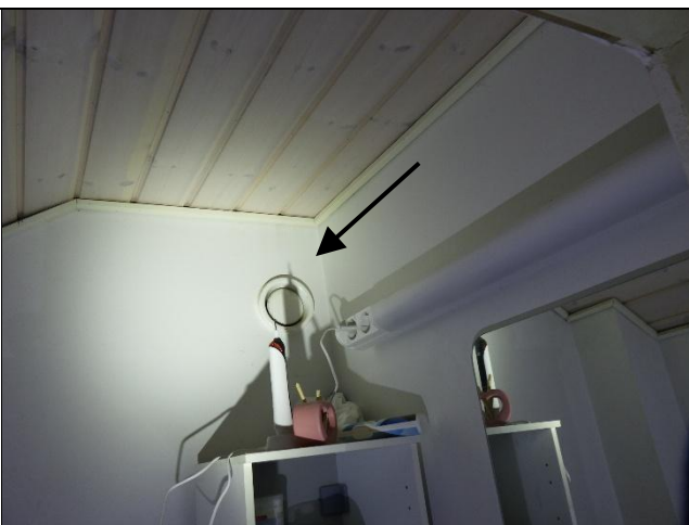
Kuva 30. Poistoilmaventtiili.
