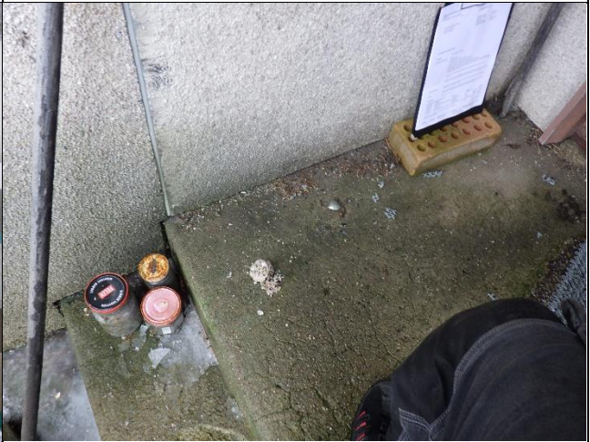
Kuva 4. Portaikko on ulkoseinän alaosan edessä.
