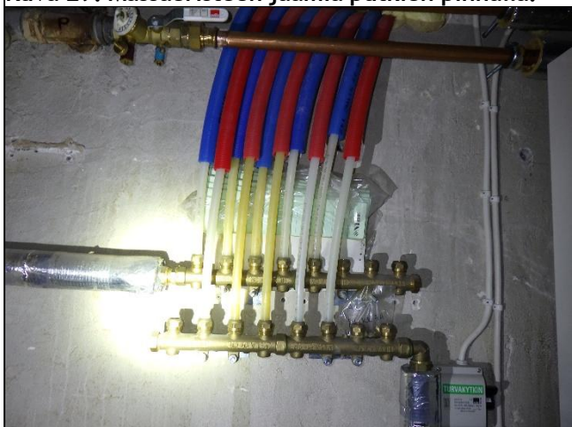
Kuva 31. Käyttövesiputkia.
