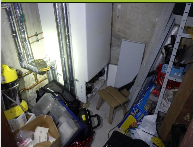
Kuva 27. Lämpöpumpun sisäyksikkö.
