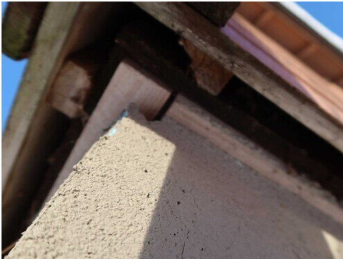
Kuva 22 Tuuletusrakoa julkisivuverhouksen taustalla
