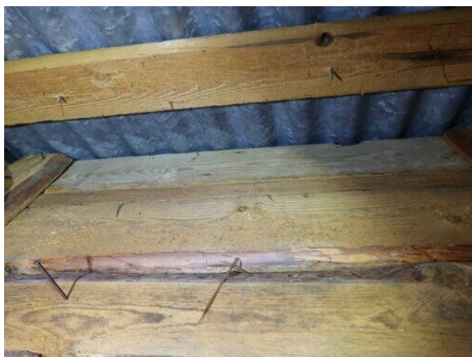
Kuva 35 Näkymää sivu-ullakolta harjalle lähes umpeen laudoitettua tuuletusrakoa
