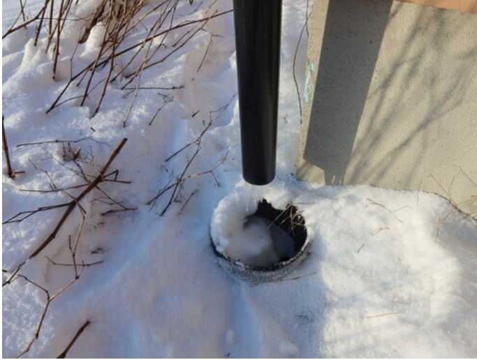
Kuva 18 Kattovesiohjausta rännikaivoon
