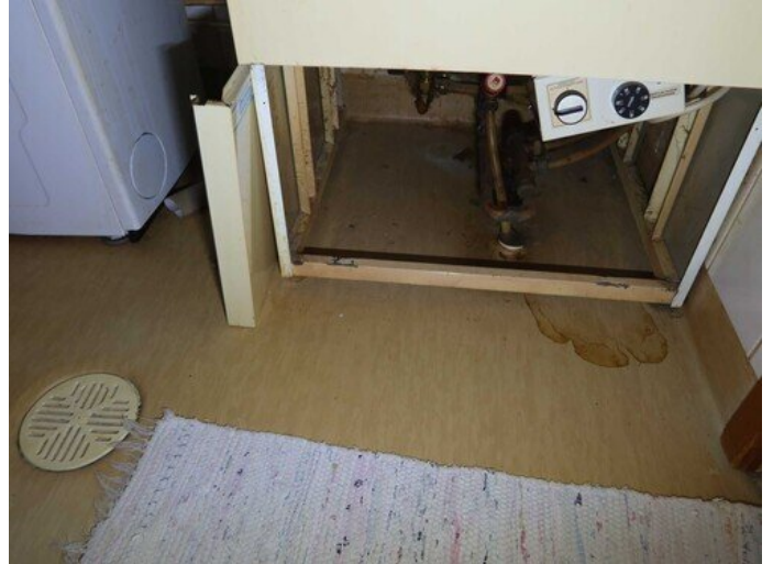
Kuva 42 Lattiakaivoa ja lämminvesivaraajan alapuolta
