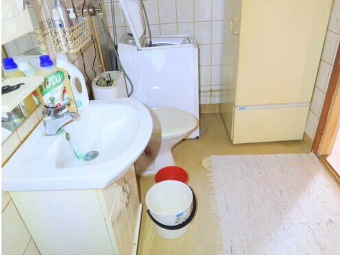
Kuva 41 Erillistä wc tilaa
