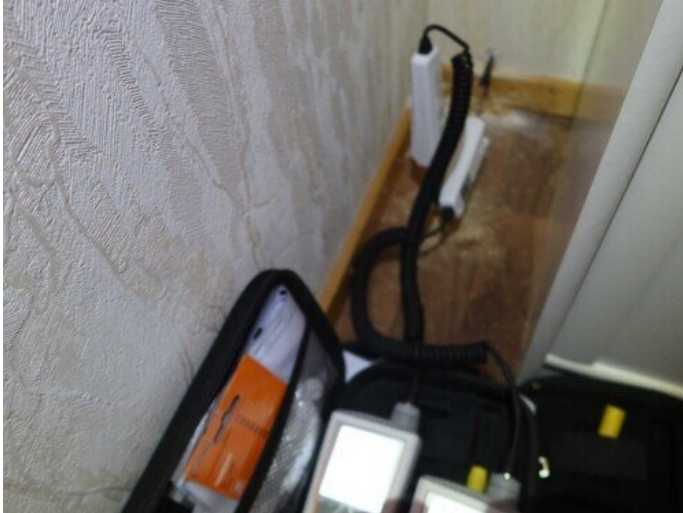
Kuva 17 Puukoolatun ja villa eristeisen lattian sekä puurunkoisen ja villa eristetyin seinän olosuhdemittausta porareistä.
