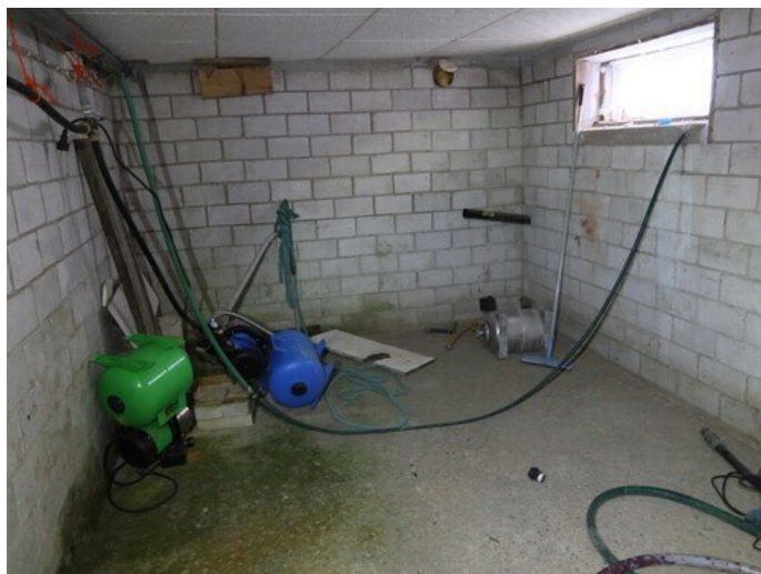
Kuva 12 Kellaritilaa, johon on sijoitettu avonainen betonirengaskaivo
