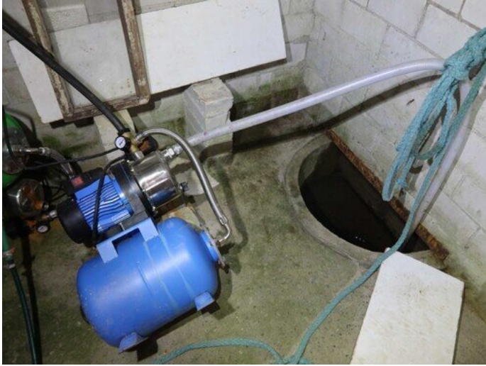
Kuva 54 Vesipumppu ja avonainen betonirenkainen käyttövesikaivo
