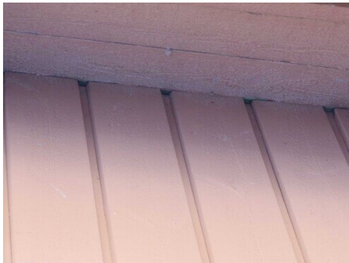
Kuva 34 Umpeen laudoitettua räystästuuletusta
