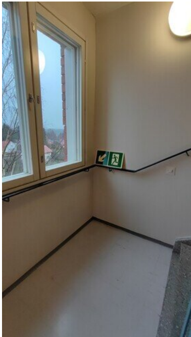
Kuva 47 Poistumistien opaste on irronnut.
