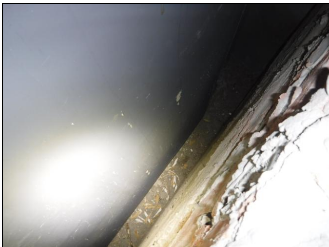
Kuva 42 Öljysäiliöstä ei havaittu vuotoon viittaavaa.
