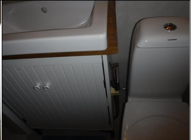
Kuva 27 Bidee liian alhaalla
