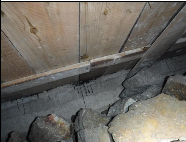
Kuva 4 Puualapohjasta ei havaittu kosteusvaurioon viittaavaa
