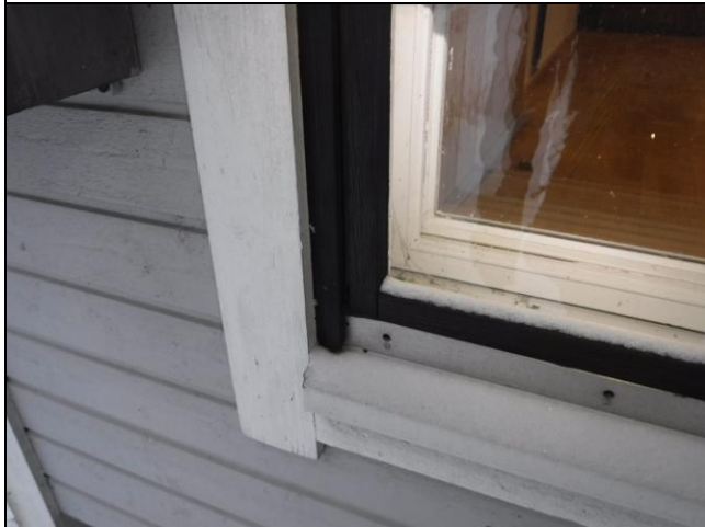
Kuva 13. ikkunaa ja pellityksiä
