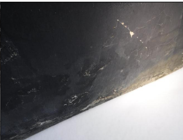
Kuva 2 Patolevyn käyttöä ei havaittavissa
