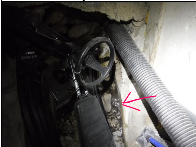
Kuva 7. Portaan alla jää puro
