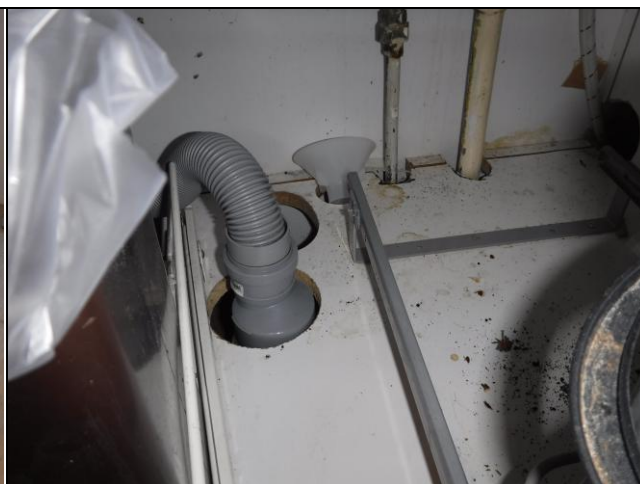
Kuva 25. Allaskaappia ei ole tiivistetty
