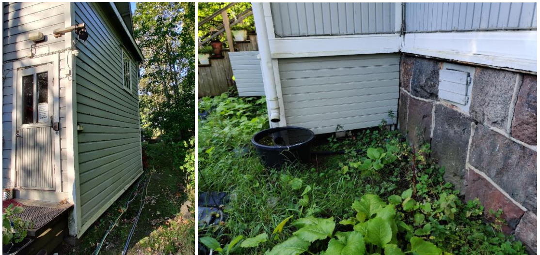
Kuvat 4 ja 5. Rakennuksen pohjoispäädystä ja itäisivulla on erilliset portaikot, joissa laudoitus on lähellä maata.
