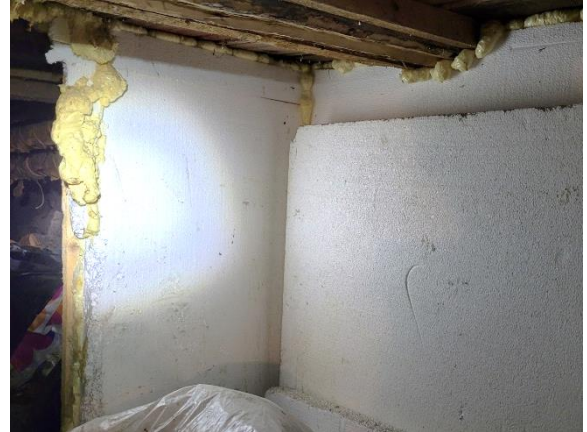
Puurakenteita vasten on vaahdotettu EPS-levyjä. Osa osioivista rakenteista on ilmeisesti jossain vaiheessa purettu.
