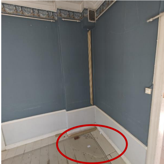
Kuvat 39 ja 40. Ensimmäisestä kerroksesta on poistettu kaksi takkaa, joiden savuhormien tilalle on asennettu IV-kanavat.
