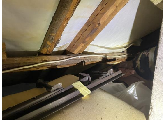
Kuvat 31 ja 32. Vesikaton aluskatteessa vanhoja vuotojälkiä. Vuodon syytä ei päästy tarkistamaan.
