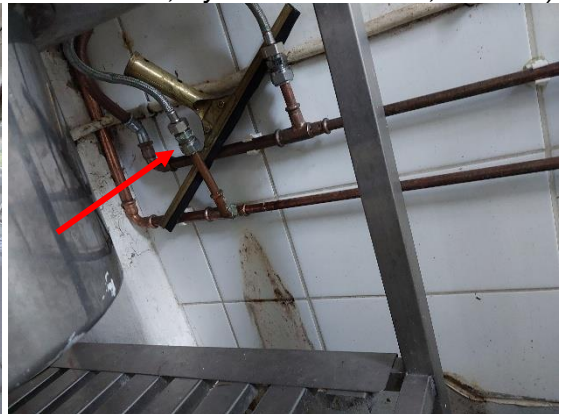
Kuva 7 (vasen). Yleiskuva tiskihuoneesta, jossa vuoto havaittiin. Vuotokohta on allaspöydän takana noin 20 cm korkeudella lattian pinnasta. Kohta on merkitty nuolella.
