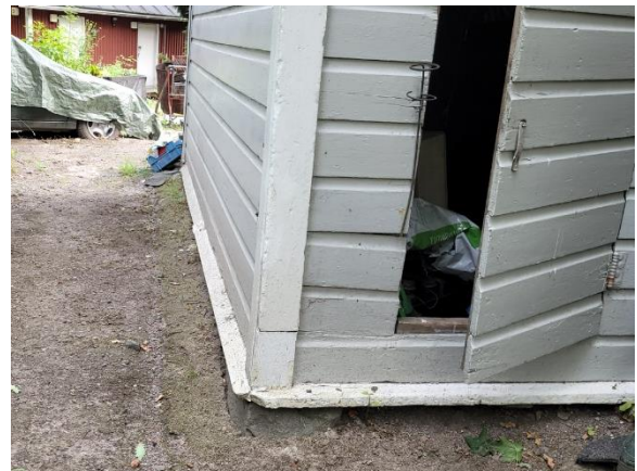
Puurakenteet ulottuvat lähes maan tasoon asti.
