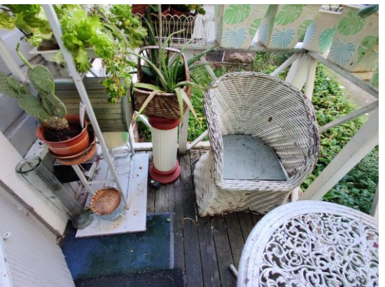
Kuvat 20 ja 21. Parvekkeiden laudoitukset ovat huonokuntoiset ja eivät ole painekyllästettyjä.
