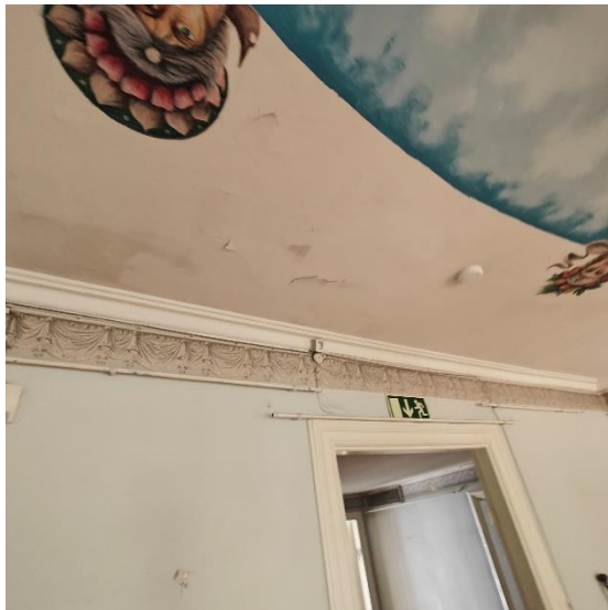
Kuva 24 ja Kuva 25. Välipohjissa havaittiin maalipinnan halkeilua.
