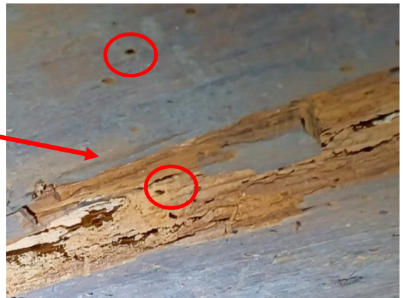
Laudoituksen pinnalla on nähtävissä jonkin kuoriaisen tms. tekemiä reikiä.
