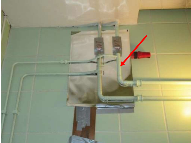
1. kerros, Miesten wc-tila; Lv-runkohaara tilan seinustalla lähellä katon rajaa 18 & 10/1,0 mm
