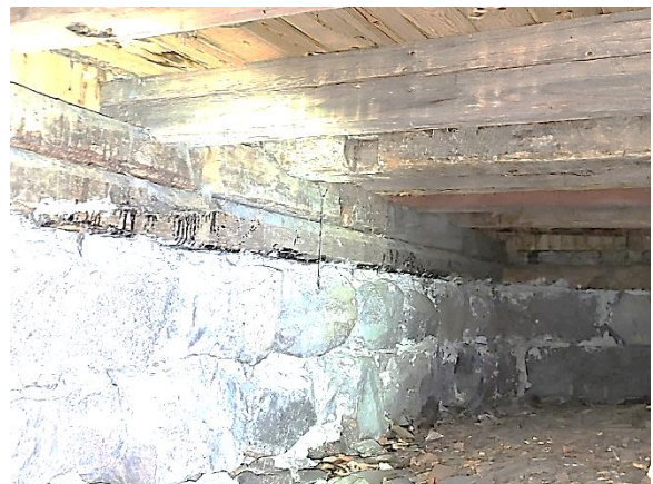
Pääsisäänkäynnin alapuolinen osio. Rossitilan vapaa korkeus on arviolta lähes 1 metri. Maa-pohjana on multaa / hiekkaa ja sen päällä rakennusjätettä tms.
