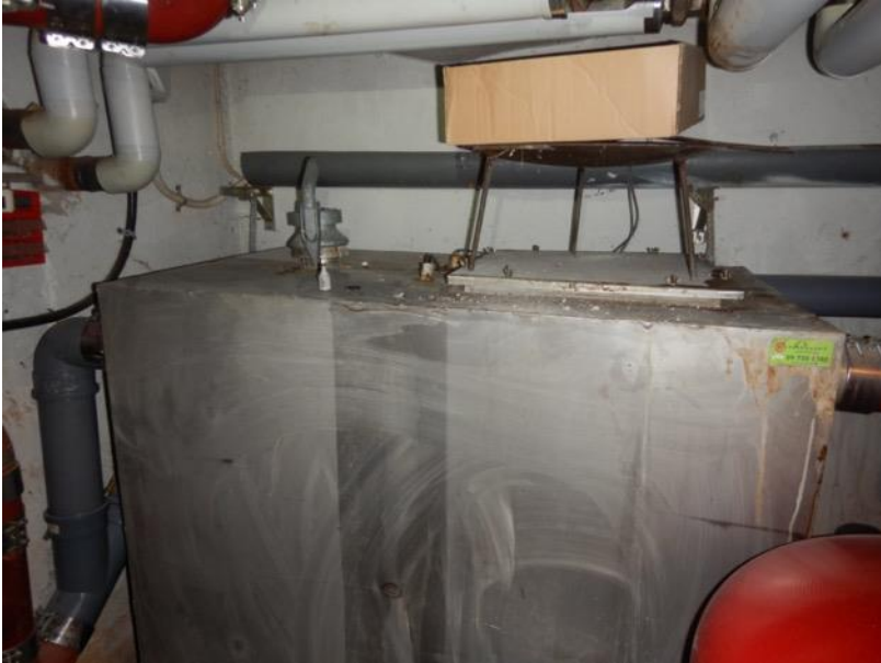
Kuva 7. Yleiskuva rasvanerotussäiliöstä.
