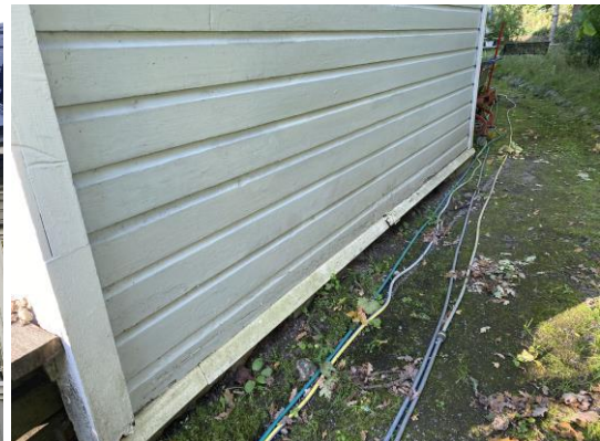
Kuvat 14 ja 15. Julkisivun puuverhouksen maalipinta ja kunto on pääosin vielä hyväkuntoinen. Pohjoispäädyn portaikon laudoitus on lähellä maanpintaa ja on paikoin kosteusvaurioitunut alapinnasta.
