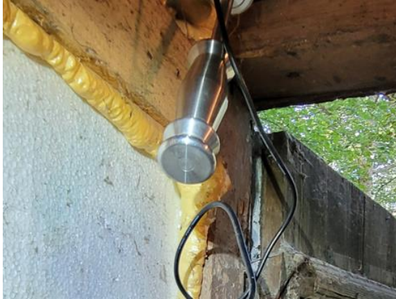
Puurakenteita vasten on vaahdotettu EPS-levyjä.
