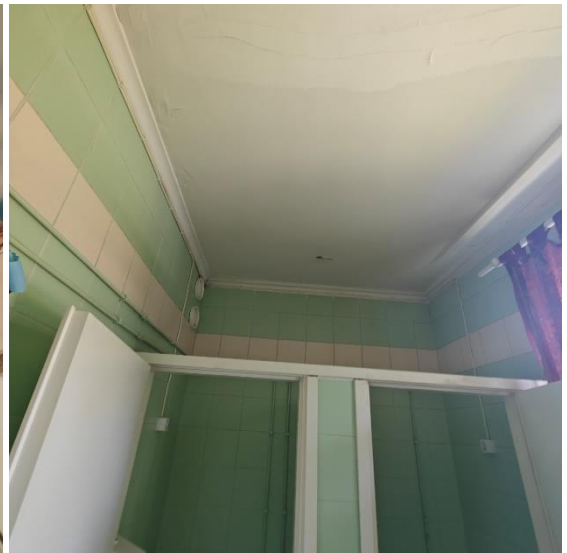
Kuva 24 ja Kuva 25. Välipohjissa havaittiin maalipinnan halkeilua.
