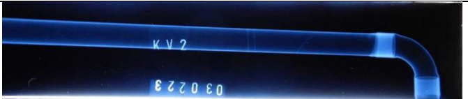
Kuvausalueen kv-runkolinjan putkiosuudelta ei havaittu syöpymiä.
