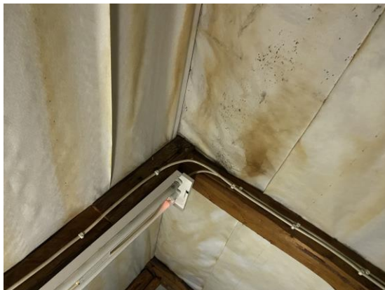
Kuvat 31 ja 32. Vesikaton aluskatteessa vanhoja vuotojälkiä. Vuodon syytä ei päästy tarkistamaan.
