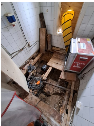
Vahinkotilan lattiarakennetta purettu
