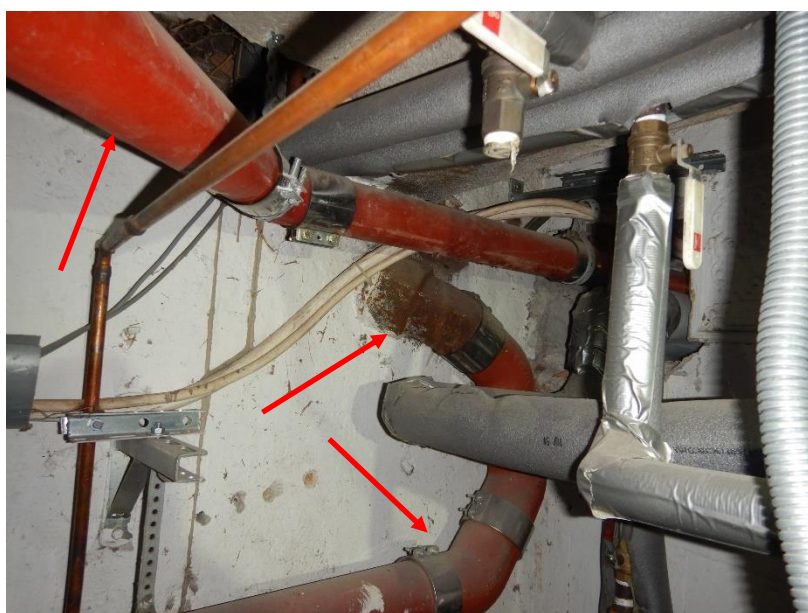
Kuva 10. Viemärit ovat eri-ikäisiä, osittain arvioilta 1960-luvulta.
