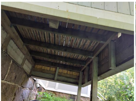
Kuvat 20 ja 21. Parvekkeiden laudoitukset ovat huonokuntoiset ja eivät ole painekyllästettyjä.
