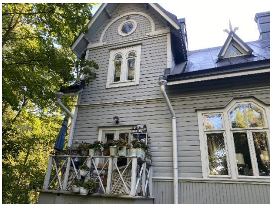
Kuvat 14 ja 15. Julkisivun puuverhouksen maalipinta ja kunto on pääosin vielä hyväkuntoinen. Pohjoispäädyn portaikon laudoitus on lähellä maanpintaa ja on paikoin kosteusvaurioitunut alapinnasta.
