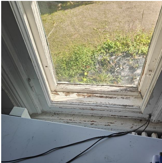
Kuvat 16 ja 17. Rakennuksen ikkunoissa havaittiin maalipinnan kulumista ja osittain puuosissa pientä halkeilua. Osa ikkunoiden sisäpuutteiden raoista on teipattu luultavasti vedon tunteen takia.
