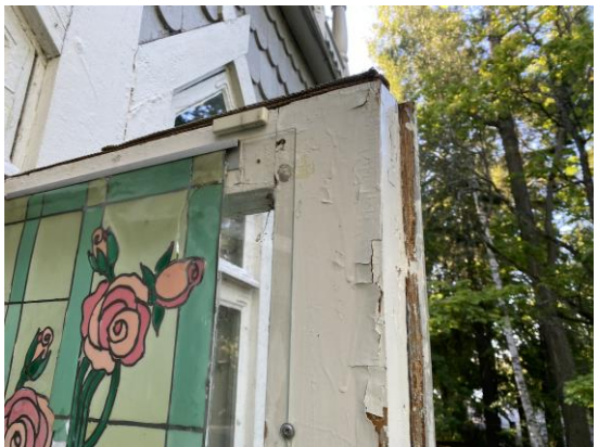
Kuvat 18 ja 19. Rakennuksen ulko-ovien maalipinnassa lohkeilua ja ovat huoltomaalauksen tarpeessa
