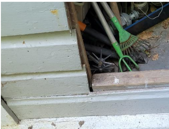
Portaikun ja siinä yhteydessä olevan varaston korkomaaailma poikkeaa merkittävästi muusta rakennuksesta.
