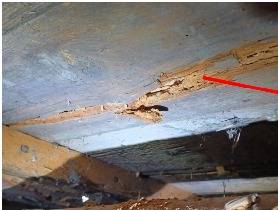
Osassa vanhemmissa eristetilan kannatinlaudoissa oli pehmeää puuainesta. Tällaista lautta todettiin osanäytteen 2 läheisyydessä (ks. kappale 5.3.1)
