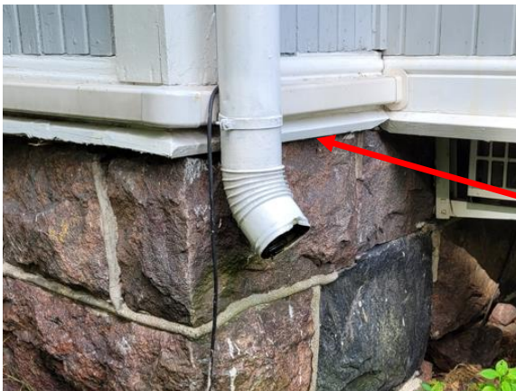
Kuva takapihan puolelta, tippalista ulottuu alimman hirren alapinnan korkoon.
