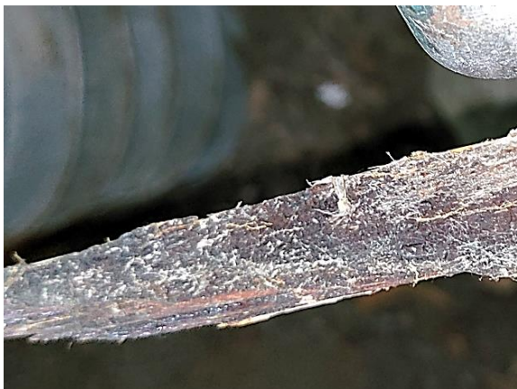
Osanäyte 3 otettiin pääsisääkäynnin alapuolelta osiosta haltiaparrun alapinnasta.
