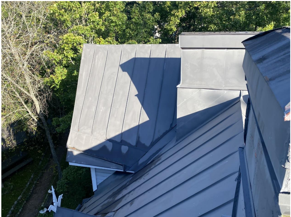
Kuva 26. Vesikatteena on peltikate.
