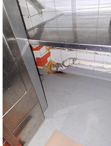
Tutkittu myös altaan viemäriputken ympäristöä pintapuolisesti. Ei havaittu normaalista poikkeavaa.
