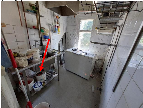
Kuva 7 (vasen). Yleiskuva tiskihuoneesta, jossa vuoto havaittiin. Vuotokohta on allaspöydän takana noin 20 cm korkeudella lattian pinnasta. Kohta on merkitty nuolella.
