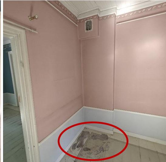
Kuvat 39 ja 40. Ensimmäisestä kerroksesta on poistettu kaksi takkaa, joiden savuhormien tilalle on asennettu IV-kanavat.
