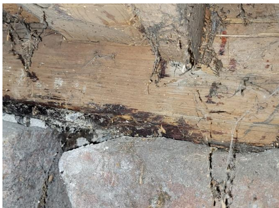
Kuva 17. Pikisivelyä/kreosoottiöljyä alimman hirren alapinnassa.
