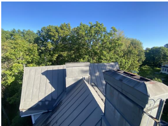
Kuva 16. Peltikatto ei sisällä asbestia.
