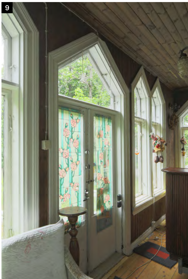
↑ Kadunpuoleisen kuistin puupinnat on lakattu. Ikkunoiden vuorilaudat ovat uusittu alkuperäisen kaltaisina. Kuistien ikkunat ovat yksilasisia.
