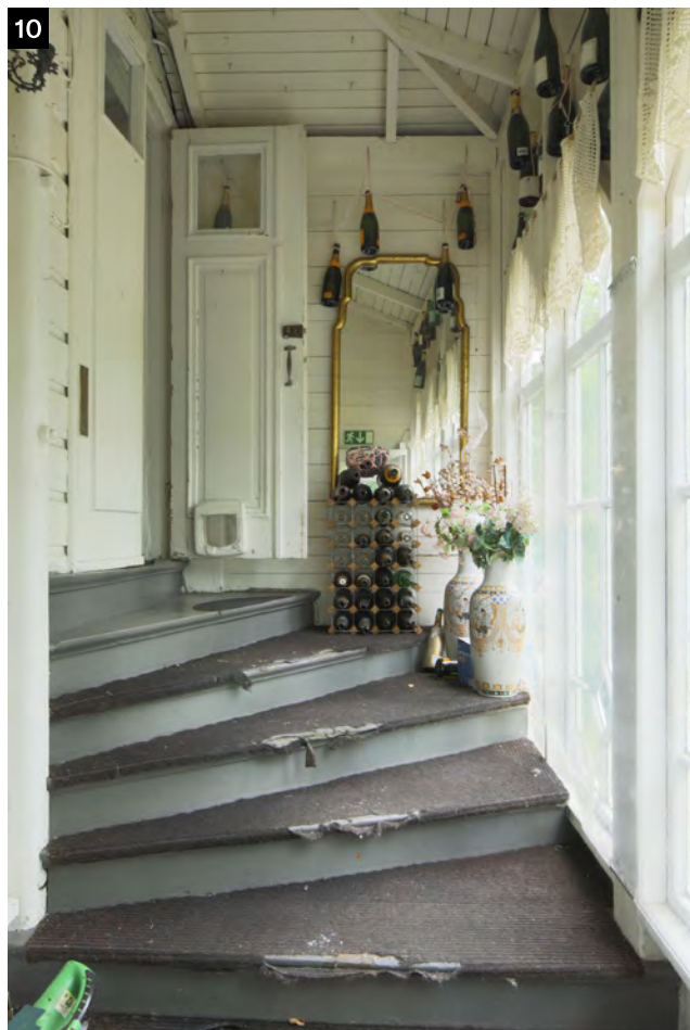
↑ Toiseen kerrokseen johtava portaikko rakennuksen lännenpuoleisella julkisivulla on vuoden 1911 lisäys.
