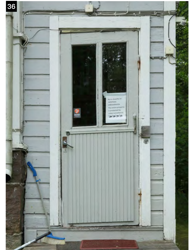
↑ Rakennuksen käyntiovet on uusittu 1930-luvulla nykyisiksi ikkunallisiksi oviksi, joiden alaosassa on sormipanelointipinta.
