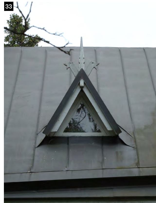
↑ Kolmionmuotoiset kattoikkunat ovat muodoltaan alkuperäisiä. Niihin on palautettu nikkari-tyyliselle arkkitehtuurille tyypilliset koristeet.
