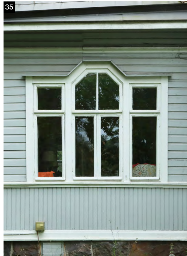
↑ Rakennuksen ikkunat ovat sisään-ulos aukeavia puuikkunoita.
