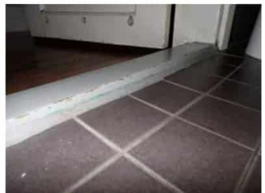
Kuva 49. Pesuhuoneen oviaukossa tulvakynnys.
