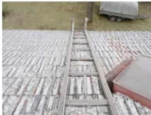
Kuva 32. Puurakenteiset lapetikkaat.
