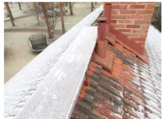
Kuva 33. Myös kulkusilta puurakenteinen.
