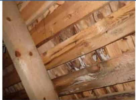
Kuva 10. Vuotojälkiä vesikattorakenteissa.
