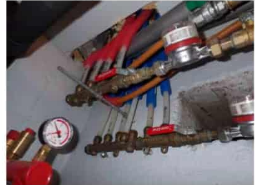
Kuva 38. Käyttövesiputkistoja.
