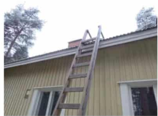
Kuva 31. Puurakenteiset alatikkaat.
