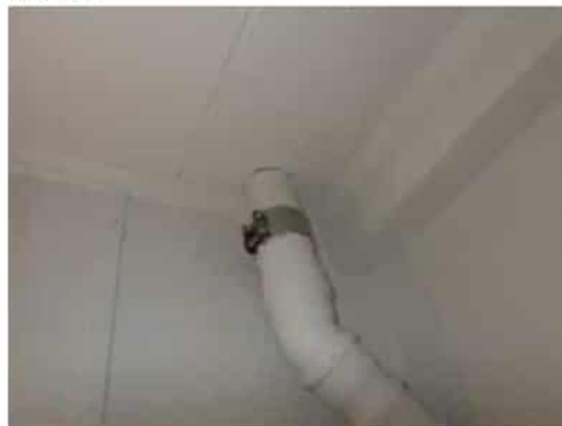
Kuva 39. Viemärit osittain uusittu.
