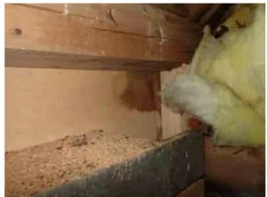
Kuva 12. Vuotojälkiä sivu-ullakolla.
