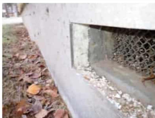
Kuva 3. Sokkelin ulkopinnalla eriste ja sokkelilevytytys.
