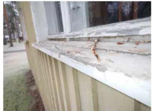
Kuva 23. Vesipellitysten tilalla laudoitukset.
