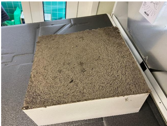
IV-koneen karkeasuodattimeen kertynyt ulkoilman epäpuhtauksia
