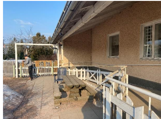
Sisäpihan puolella räystäät ovat pitkät ja tuetut
