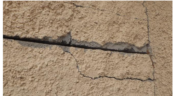
Sisäpihalla julkisivua suojaa pitkä räystäs/katos. Rappauksen lohkeilua
