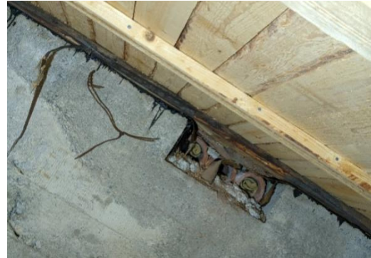
Uusittua aluslaudoitusta keittiön kohdalla
