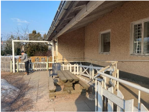
Sisäpihalla julkisivua suojaa pitkä räystäs/katos. Rappauksen lohkeilua
