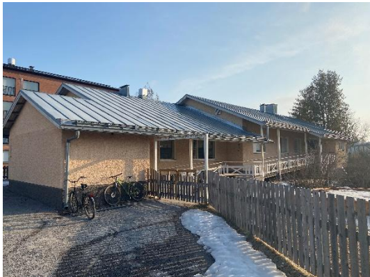
Sisäpihan puoli, rakennus on porrastettu siten että autotallipäädyn puoleisella osalla (rossipohja) lattiapinta on reilu puoli metriä alemmalla tasolla kuin kellariosuudella
