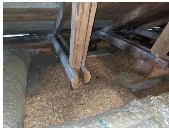
Vanhaa lämmöneristettä ja uudet villaeristeiset ilmanvaihtokanavat
