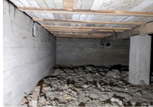
Ryömintätilassa maapohja pääosin savea
