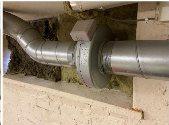
Kellarin kanavapuhallin
