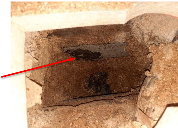
Kuva 8. (vas.) Pienryhmätila 106 välipohjatilassa sijaitsevan perusmuurin sisäpinnalla havaittiin PAH(16)-summapitoisuuden ylittävää tervapahvia
