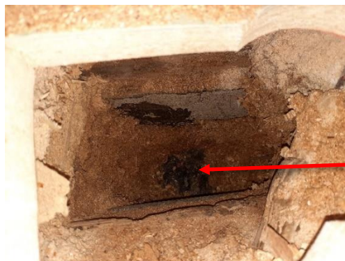
Kuva 11. (vas.) Varasto 012 ulkoseinässä perusmuurin sisäpinnalla havaittiin PAH(16)-summapitoisuuden ylittävää bitumisivelyä
