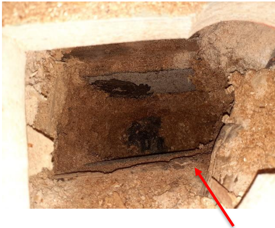
Kuva 1. Asbestipitoinen putkieriste
