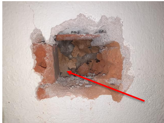
Kuva 8. (vas.) Pienryhmätila 106 välipohjatilassa sijaitsevan perusmuurin sisäpinnalla havaittiin PAH(16)-summapitoisuuden ylittävää tervapahvia
