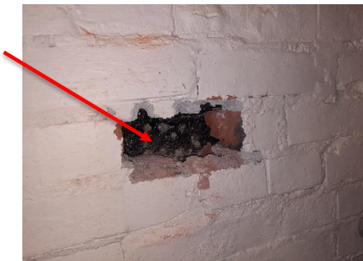
Kuva 11. (vas.) Varasto 012 ulkoseinässä perusmuurin sisäpinnalla havaittiin PAH(16)-summapitoisuuden ylittävää bitumisivelyä
