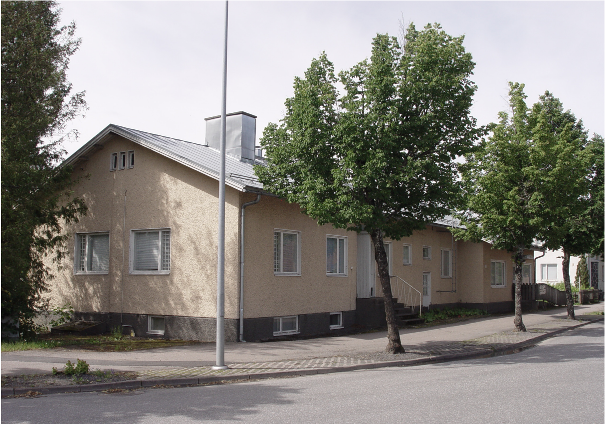
kuva 15 Ristiraatio I Linja-autoaseman risteyksestä nähtynä
