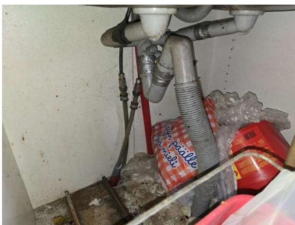
Käyttövesiputket on muoviputkia.
