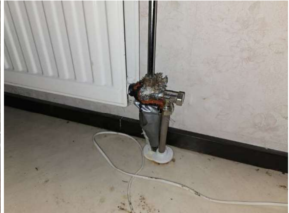
Alakerran takapihan puoleisen makuuhuoneen patteriputksissa teippauksia. (Ei näkyvää vuotoa).
