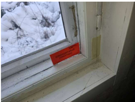
Alkuperäiset ikkunat ovat 2-lasisia.
