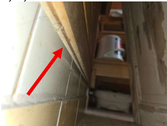
Ilmarako paneloinnin alaosassa on niukka.
