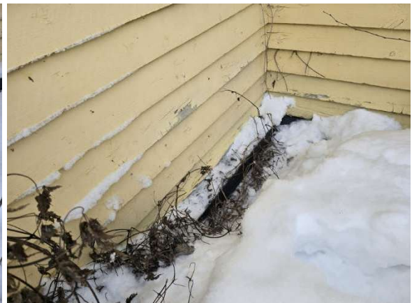
Laajennusosan harkkosokkelissa kastumisjälkiä.
