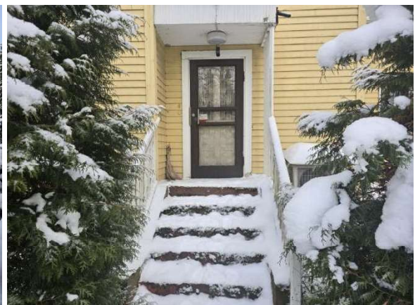
Ulkopoortaat nousevat ulkoseinän alaosa ylemmäksi.
