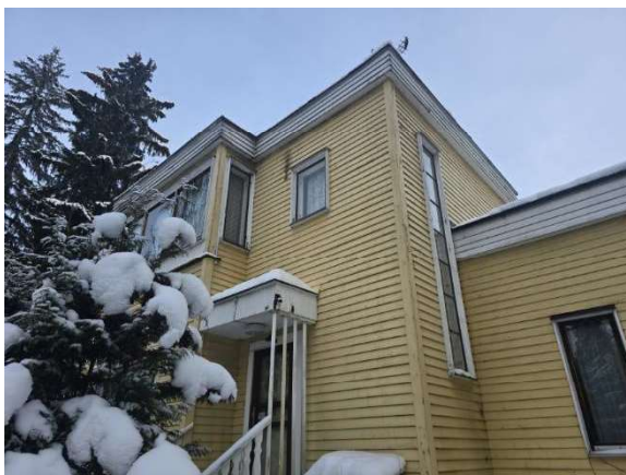
Lyhyet räystäät kuuluvat talon arkkitehtuuriin, mutta muodostavat ikääntyessään riskin vuotamisella.
