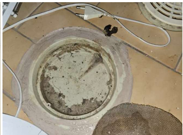
Suihkun alla ja saunassa on ns. kuivakaivot, jotka on yhdistetty pesuhuoneen kaivoon.
