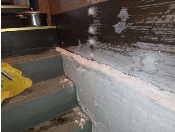
Jäätä ja kuuraa sokkelin pinnalla sekä ulkoseinän alaosassa.
