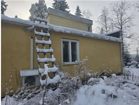
Vanhan osan sivuseinä on rapattu.
