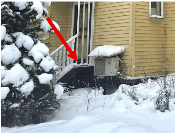
Betoniportaatt ulkoseinän alaosa ylemmänä.
