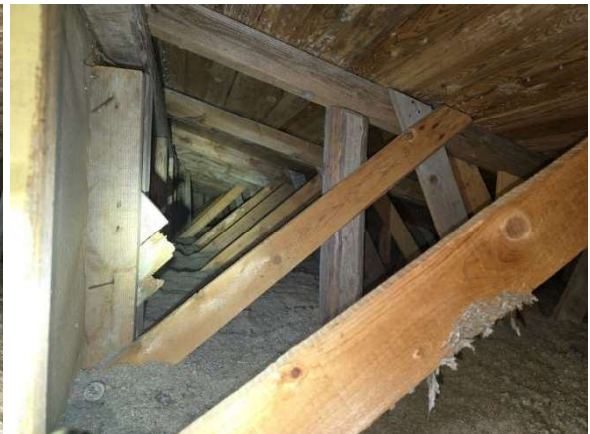
Luukkun vanhan osan yläpohjatilaan. Eristeenä puhallusvillaa. Kulkusiltojen puuttuminen rajoitti tarkastamista.
