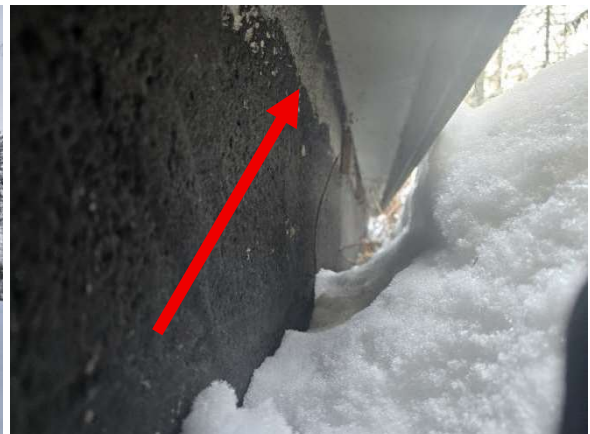
Kuva laajennusosan verhouksen alaosasta. Ilmarako verhouksen taustaan.
