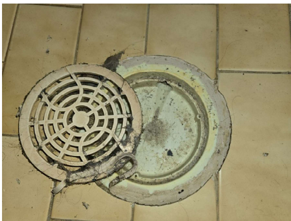
Suihkun alla ja saunassa on ns. kuivakaivot, jotka on yhdistetty pesuhuoneen kaivoon.
