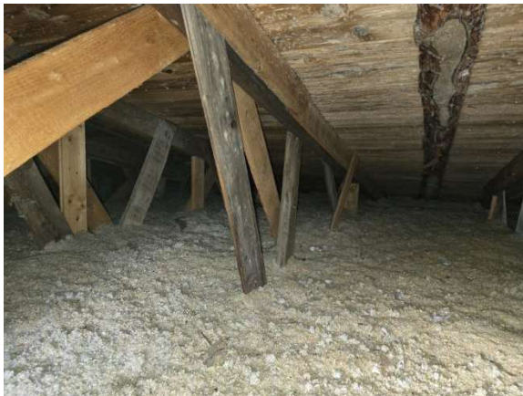
Luukkun vanhan osan yläpohjatilaan. Eristeenä puhallusvillaa. Kulkusiltojen puuttuminen rajoitti tarkastamista.
