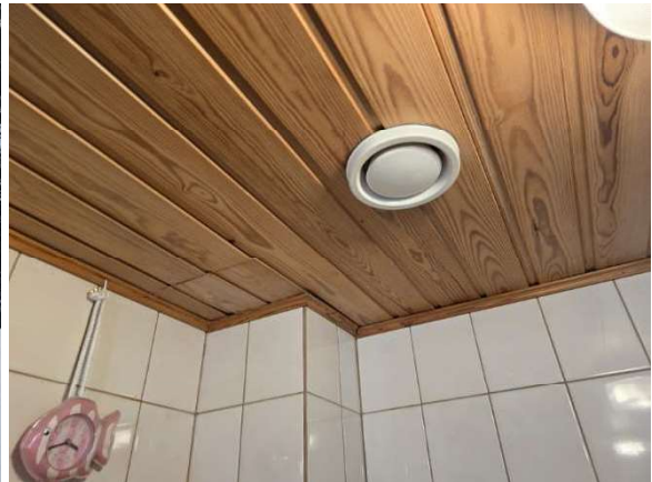
Pesuhuoneen poistoventtiili.
