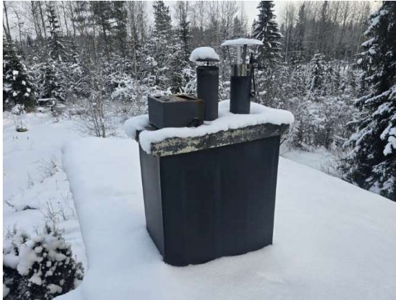
Laajennusosan savupiippu, jossa kattilan ja puulieden hormit, sekä liesituulettimen poistohormi.
