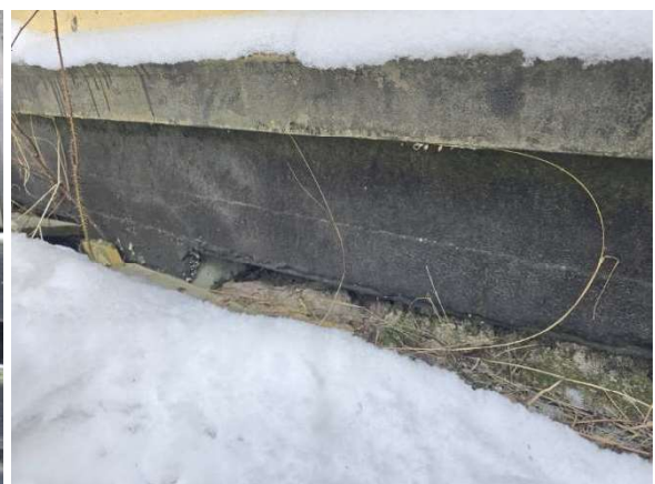
Vanhan osan perustukset on toteutettu ns. pilari-palkkimenetelmällä.
