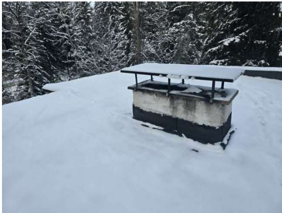
Takan piippu on suojattu piipuhatulla. Piipun yläosa on havaintojen perusteella ehjä.
