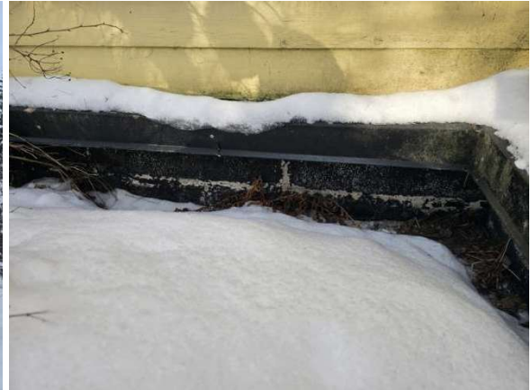
Laajennusosan harkkosokkelissa kastumisjälkiä.
