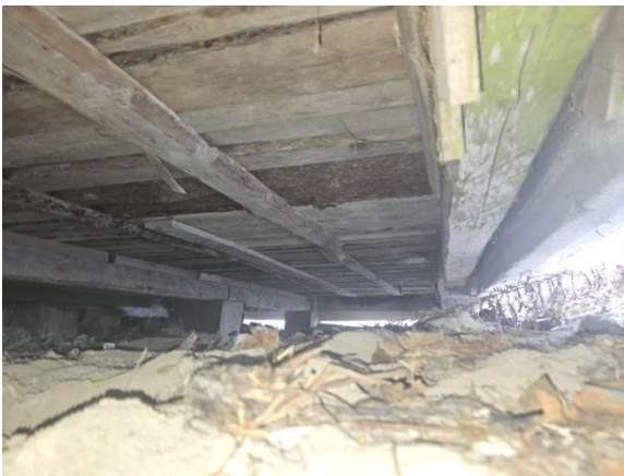
Puurakenteet ulkoasultaan ehjiä. Lahovaurioita ei havaittu.
