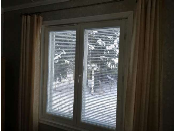
Juhlasalin sivuikkuna on asennettu 2008.
