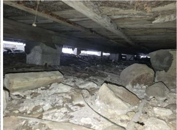
Maapohja on täynnä rakennusaikaista puujätettä.
