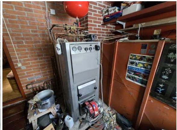
Öljykattila kattilahuoneessa.
