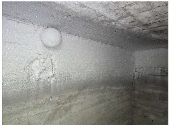
Seinien yläosat ja katto kuurassa.
