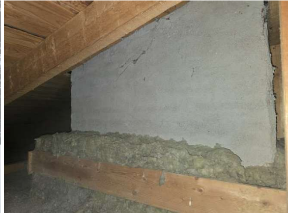
Piippu on yläpohjatilalla ehjä ja siisti.
