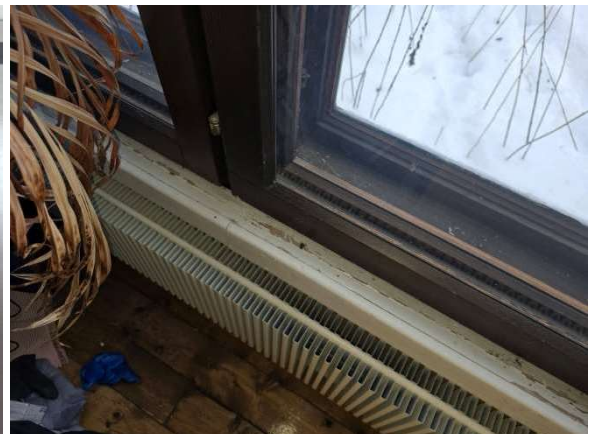
Osa lämpöpattereista on ulkoasun perusteella 1990 lukua vanhempaa mallia.
