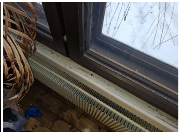
Laajennuksen ja peruskorjauksen ikkunat 3-lasisia.
