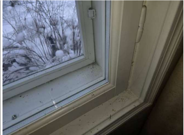
Ikkuna on nykyaikainen, jossa elementtilasi sisäpuiteessa.
