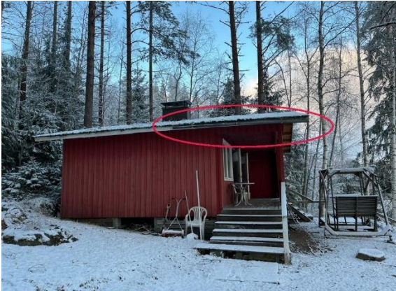
Kuva 4. Kuvassa osoitettu yksittäinen vesikouru.
