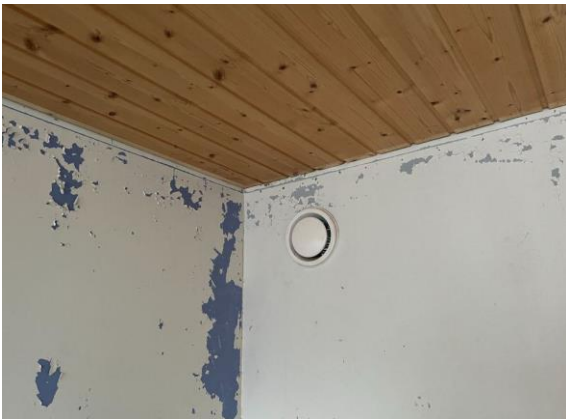
Kuva 27. Sisätilojen poistoilmaventtiili
