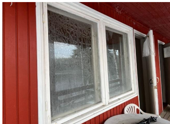
Kuva 19. Ikkunoiden maalipinnat ovat ulkopuolelta parempikuntoiset katetulla alueella, mutta silti niissä on havaittavissa huoltotarvetta
