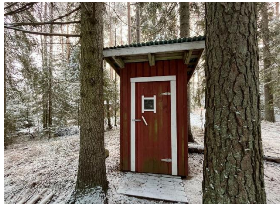
Kuva 16. Ulkokuussin maalipinnassa sammalkasvustoa
