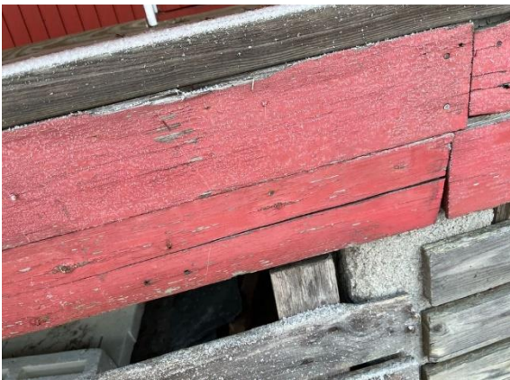
Kuva 15. Maalipinta hilseilee
