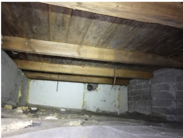
3. Ryömintätilaa ja alapohjaa
