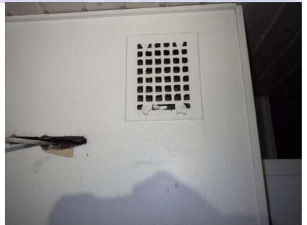
38. Poistoilmaventtiili
