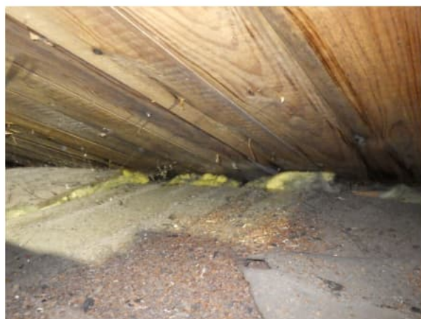
22. Vinon yläpohjan tuuletus ummessa harjakolmiotilassa
