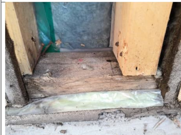
Kuva 47 - Alaohjauspuun yläpinnassa tummentumaa [US11]
