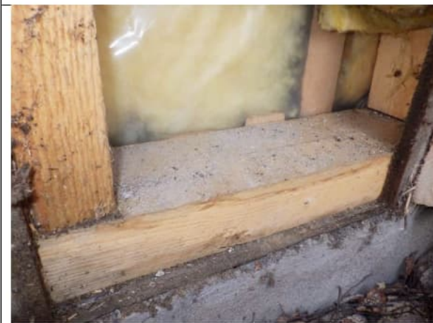
Kuva 59 - Alaohjauspuun yläpintaa [US14]
