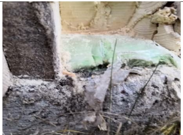
Kuva 8 - Alaohjauspuun alapuoliset materiaalit, [US1]
