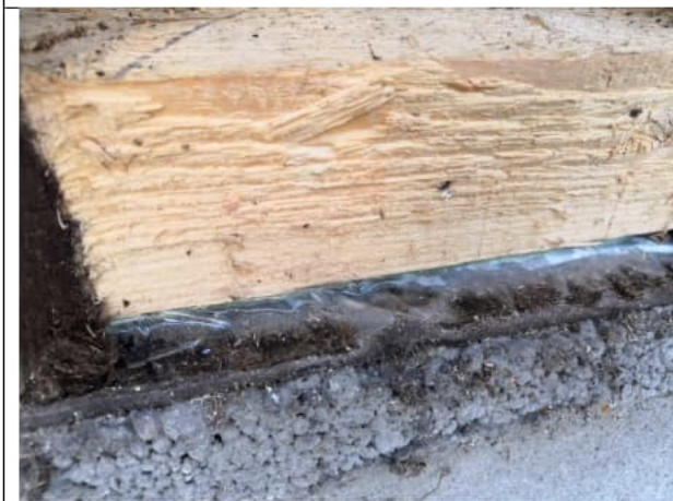
Kuva 55 – Alaohjauspuun alapuolisia materiaalikerroksia [US13]
