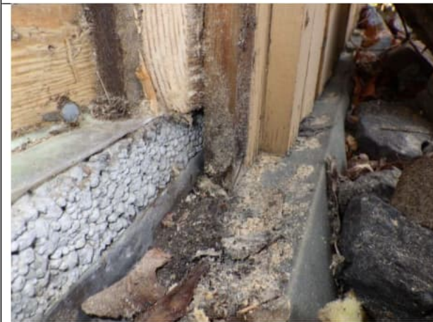
Kuva 31 - Alaohjauspuun alla olevia materiaalikerroksia [US7]
