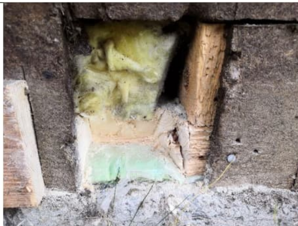
Kuva 7 - Ulkoseinän rakenteita [US1]
