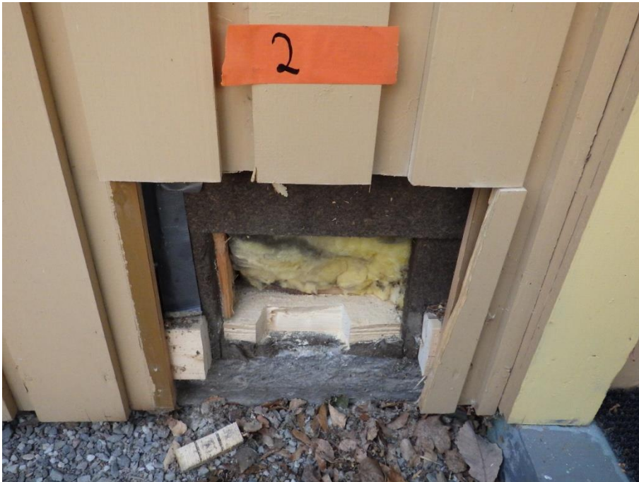
Kuva 1 - Tutkimuksessa tehty rakenneavaustyyppi, avaus [US2]
