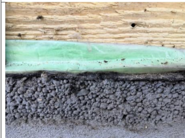
Kuva 27 - Alaohjauspuun alla olevia materiaalikerroksia [US6]
