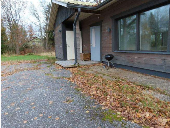
Julkisivut ovat pääosin kunnossa
