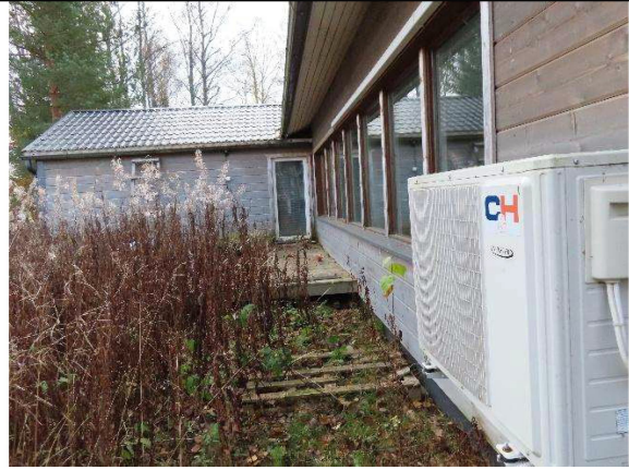
Julkisivut ovat pääosin kunnossa
