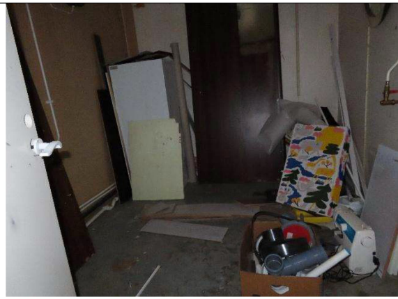
Yleiskuvaa lämpimästä varastosta
