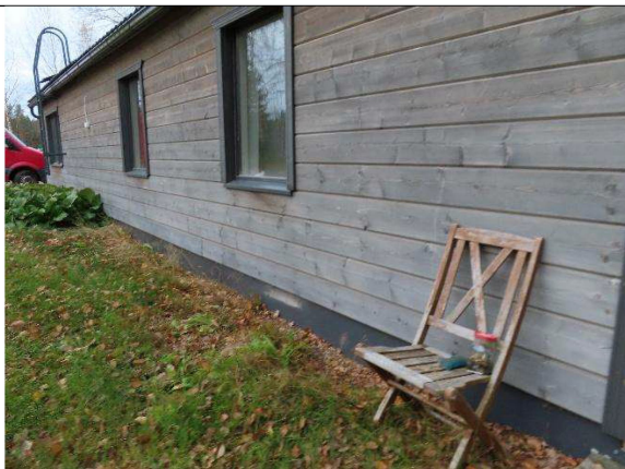
Julkisivut ovat pääosin kunnossa
