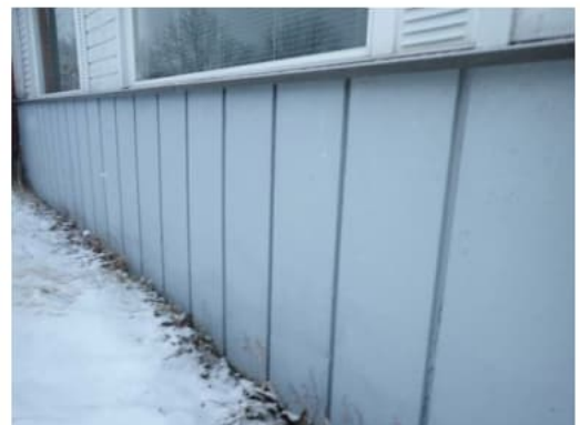
Kuva 17. Seinän alaosissa julkisivuna betoninen sokkeli.
