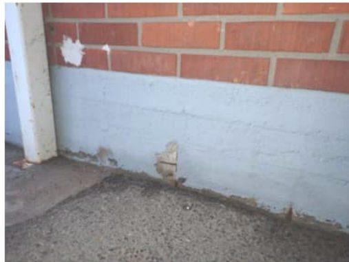
Kuva 3. Sokkelin raudoitusta näkyvillä.
