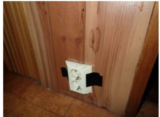
Kuva 28. Pistorasia irronnut kiinnityksestään.
