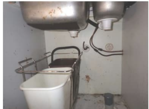
Kuva 39. Näkymä keittiön allaskaappiin.
