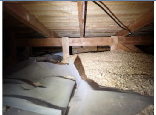
Kuva 9. Muovikelmua yläpohjan eristeen päällä.
