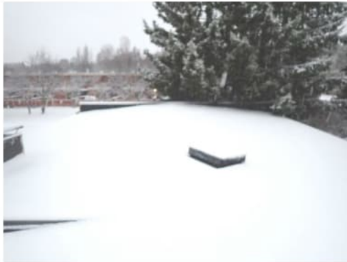
Kuva 22. Vesikatetta ei voitu tarkastaa lumipeitteen vuoksi.
