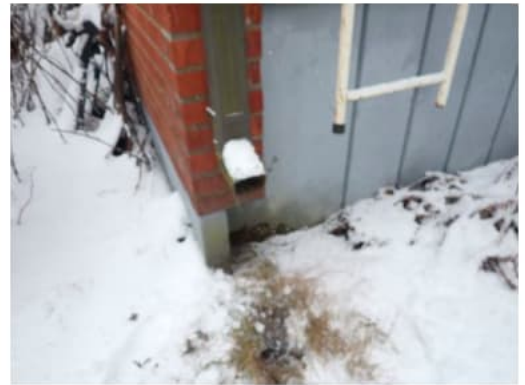
Kuva 24. Kattovedet suositeltavaa johtaa kauemmas rakennuksen vierustalta.
