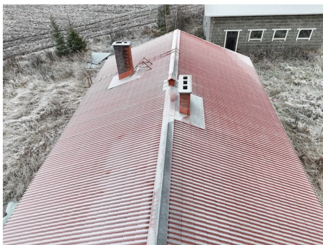
Kuva 5. Vesikatteen läpivienneissä ja asennuksissa ei havaittu poikkeamia tai vaurioita.
