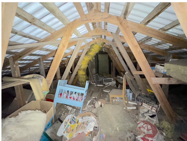
Kuva 6. Vesikaton kantavien rakenteiden kunto on hyvä.
