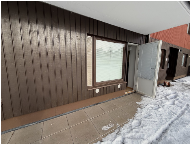
Kuvat 7. Julkisivupinnat, ikkunat ja ovet hyväkuntoisia.
