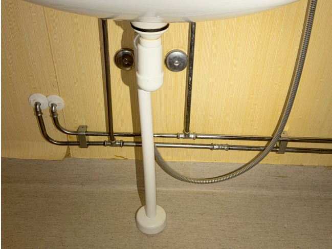
Kuva 8. Käyttövesiputkisto ja näkyvät viemärit tarkastettiin
