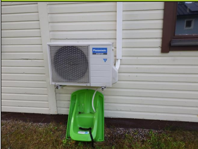
Kuva 20 Ilmalämpöpumppu.
