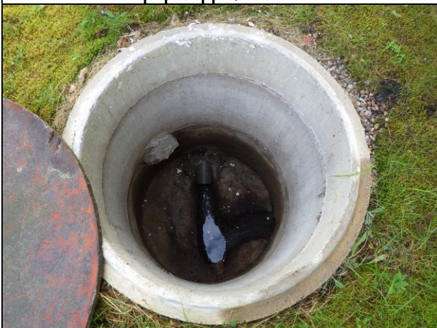
Kuva 22 Viemärin tarkastuskaivo
