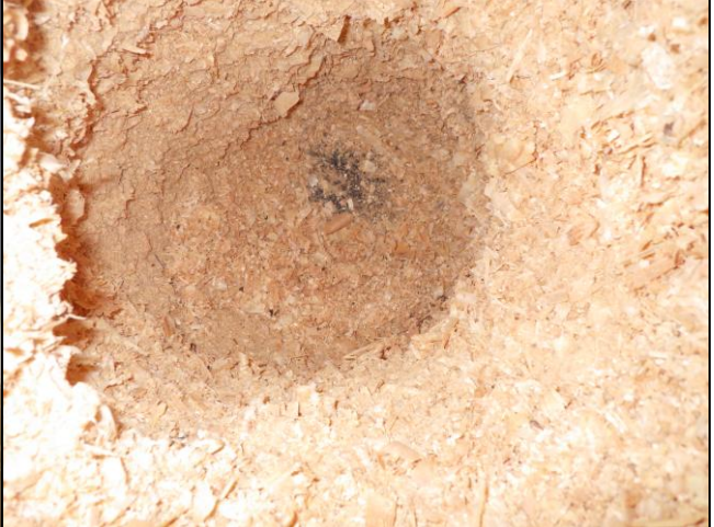
Kuva 2 Alapohjan purueristystä
