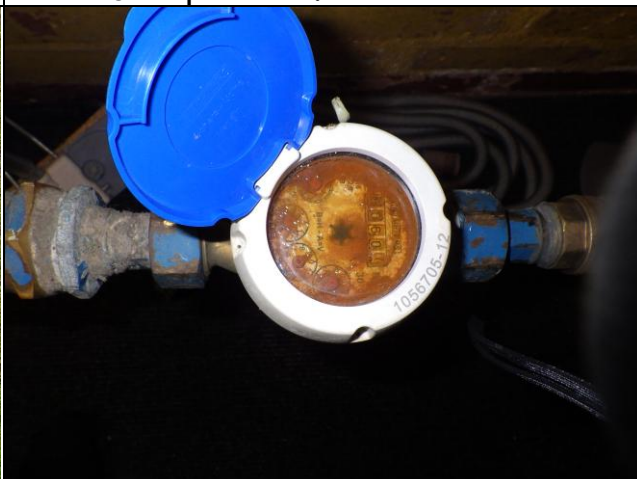
Kuva 23 Vesimittarissa "ruostetta"
