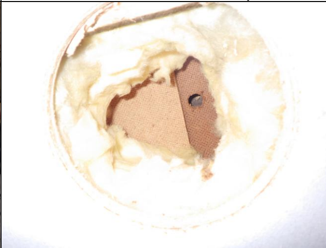
Kuva 13 Rakenneavaus sivu-ullakon katosta
