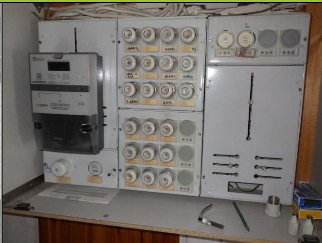
Kuva 21 Sähköpääkeskus.
