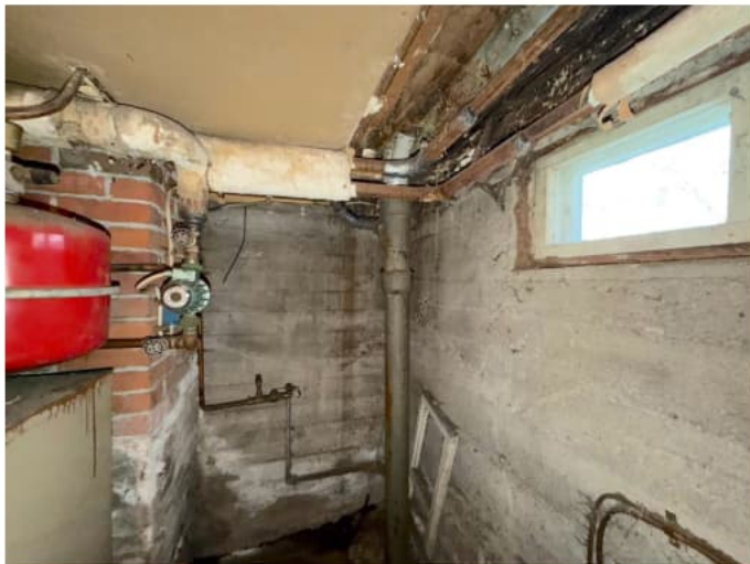
Kuva 11. Kellaritilaa ei ole sisustettu
