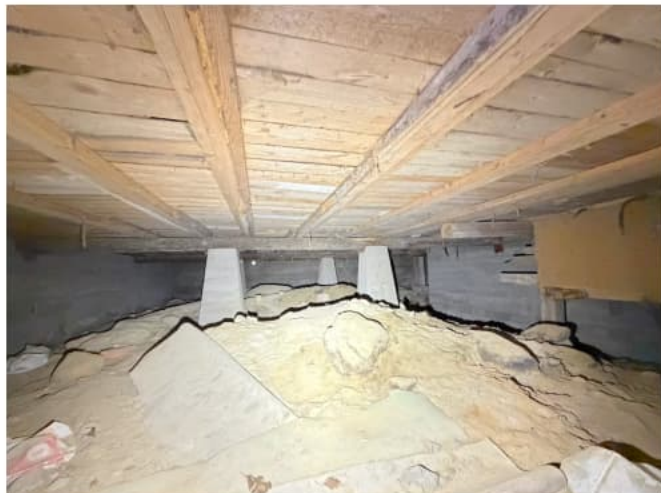
Kuva 12. Alapohjan rakenteissa ei vaurioita
