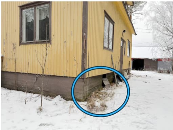
Kuva 9. Selkeää sokkelin liikehdintää ja painumaa
