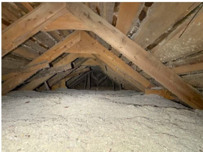
Kuva 6. Vesikaton kantavien rakenteiden kunto on hyvä.
