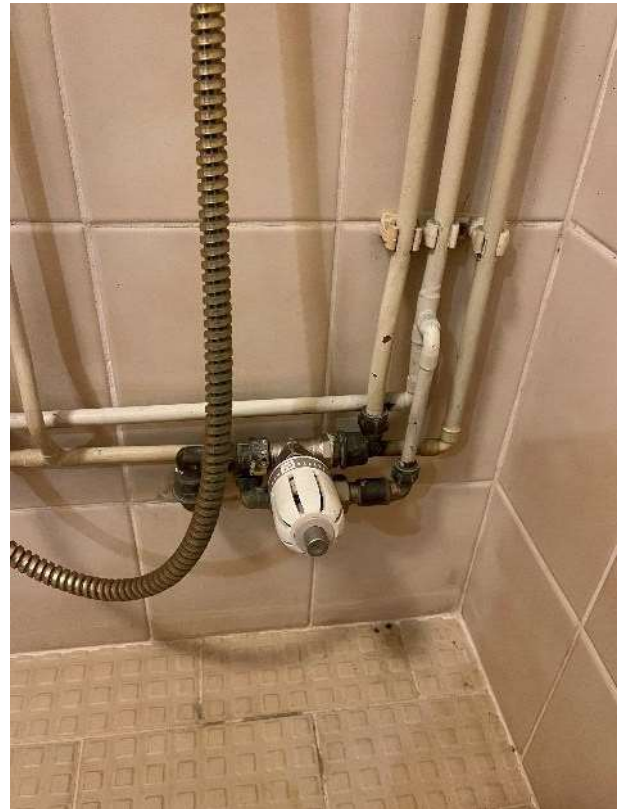
Kuva 26. Pesuhuoneen oven kynnyks – metallinen peitelistä. Kuva 27. Lattialämmityksen termostaatti suihkulaitteen alapuolella.
