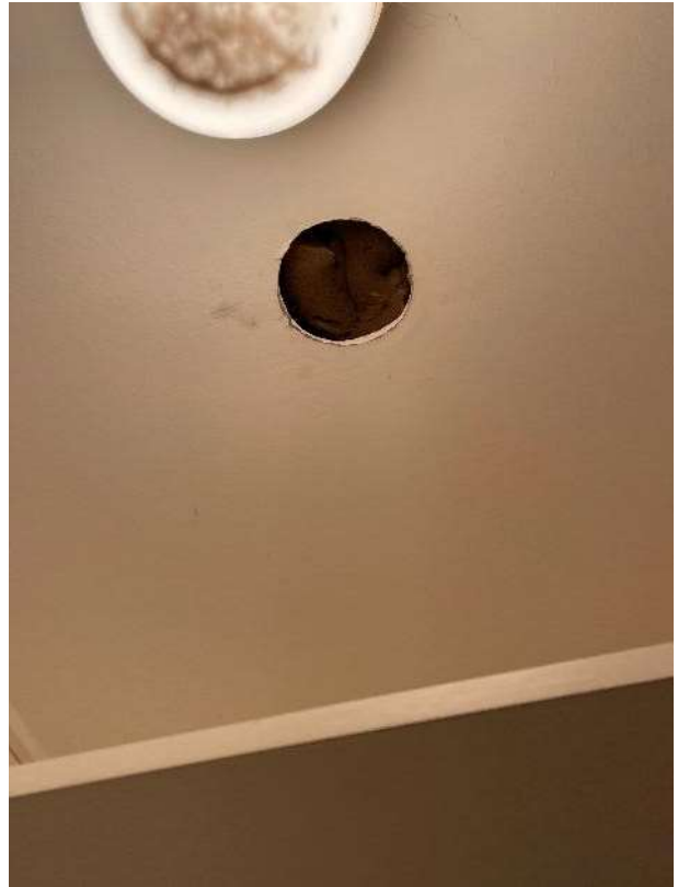
Kuva 43. Pesuhuoneen poistoilmaventtiili. Kuva 44. Vaatehuoneen poistoilmaventtiili puuttuu. Putki tukittu.
