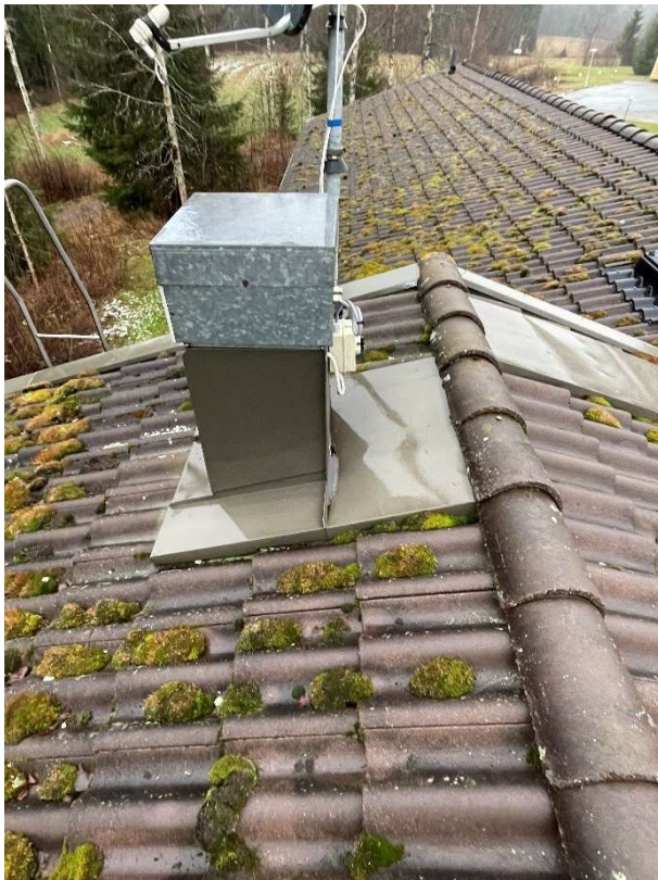
Kuva 24 & 25. Yleiskuvat vesikatteelta. Tiilipinnalla on paljon sammalta, kate on pääosin ehjä.
