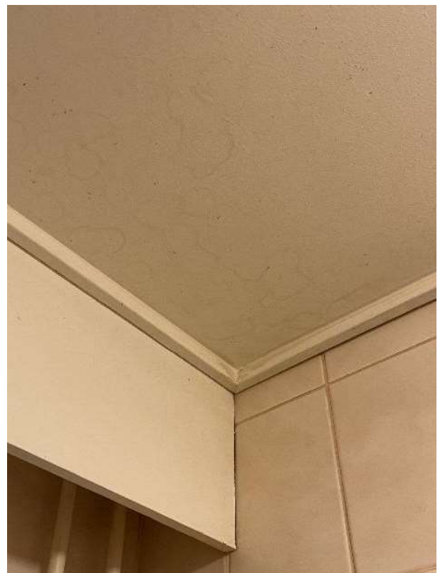
Kuva 28. Lattialämmityksen termostaatti puuttuu. Kuva 29. Pesuhuoneen laakaovi. Kuva 30 & 31. Kosteusjälkiä pesuhuoneen katossa.
