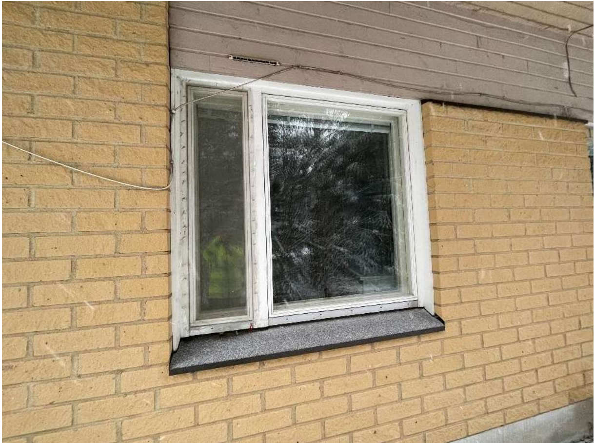
Kuva 15. Ikkuna ulkopuolelta kuvattuna.
