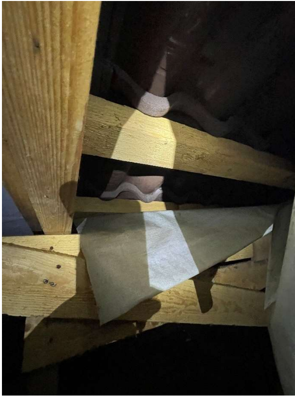
Kuva 22. Irronnut aluskate. Kuva 23. Reilusti puhallusvillaa.
