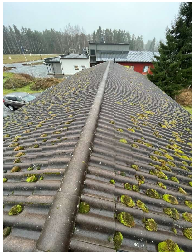
Kuva 24 & 25. Yleiskuvat vesikatteelta. Tiilipinnalla on paljon sammalta, kate on pääosin ehjä.
