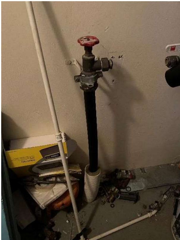
Kuva 40. Päävesiputki suoja-putkessa. Kuva 41. Keittiön pesualtaan kytkennät.
