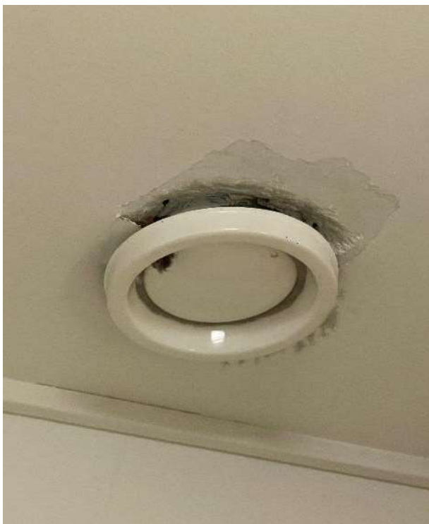
Kuva 18. Pesuhuoneen poistoilmaventtiili ja katossa näkyvät vauriot. Kuva 19. Kulmapelti vesikatolla rakennusosien liitoskohdassa.
