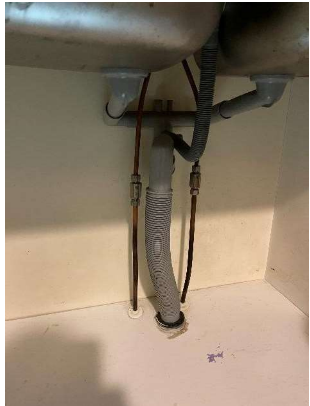
Kuva 40. Päävesiputki suoja-putkessa. Kuva 41. Keittiön pesualtaan kytkennät.
