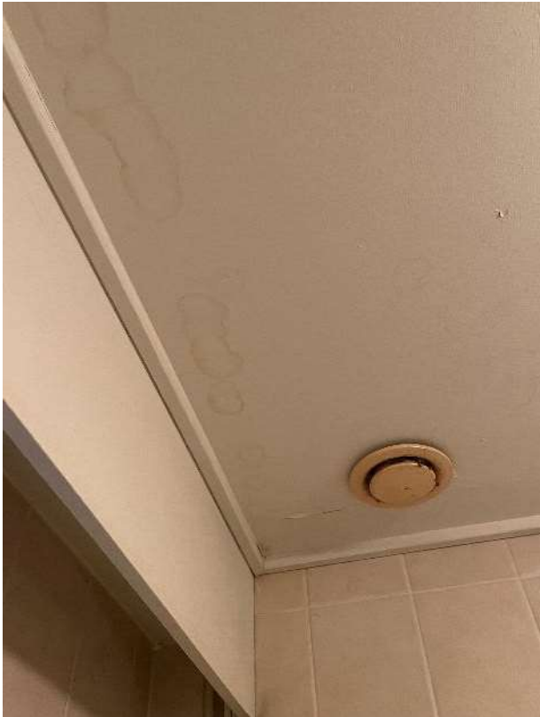
Kuva 43. Pesuhuoneen poistoilmaventtiili. Kuva 44. Vaatehuoneen poistoilmaventtiili puuttuu. Putki tukittu.
