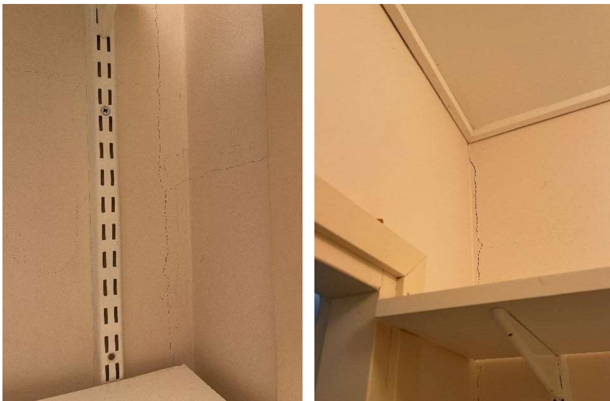
Kuva 9 & 10. Tiiliväliseinien halkeamat
