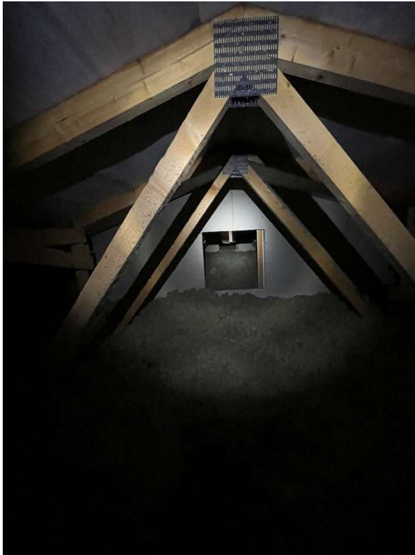
Kuva 19. Yläpohjan osastoitu paloseinä ja kulkuluukku. Kuva 20. Viemärin tuuletusputken läpivienti. Kuva 21 (alla). Kulkuluukku yläpohjaan.
