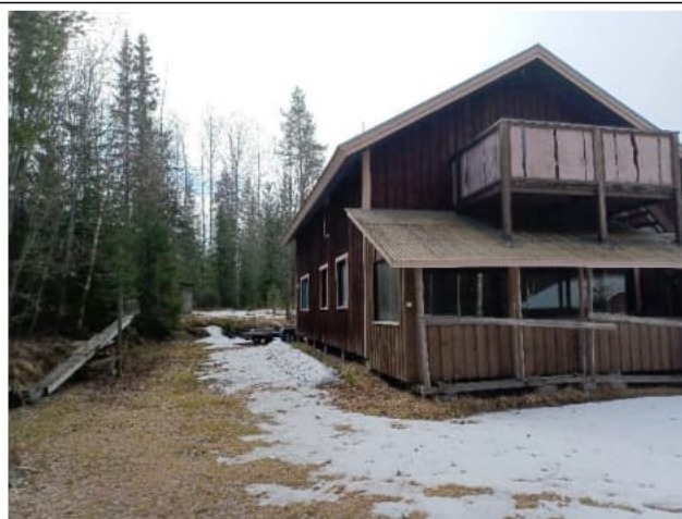
Maanpinnat kallistuvat rakennuksesta pois päin asianmukaisesti
