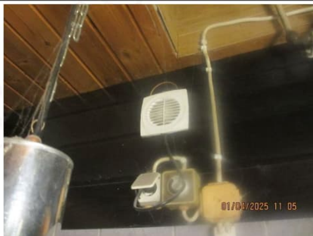
Pesuhuoneen ilmanvaihtoa on tehostettu poistopuhaltimella
